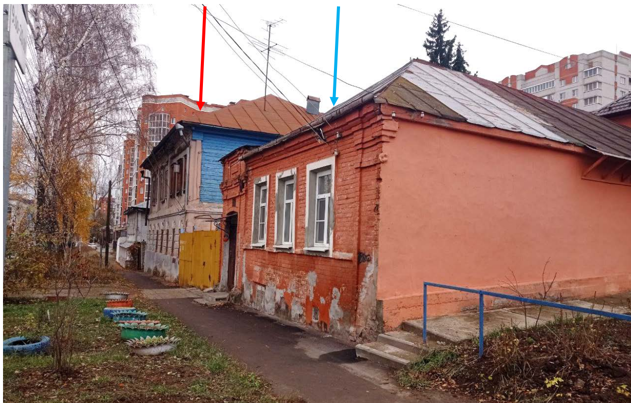
Фото 15. Выявленный объект культурного наследия «Городская усадьба М.В. Пузанова, конец XIX – нач. XX вв.:- Главный дом, - Флигель», конец XIX – нач. XX вв, г. Курск, ул. Карла Либкнехта, 30, 30а. Красным цветом указан выявленный объект культурного наследия «Дом жилой», г. Курск, ул. Карла Либкнехта, 30. Синим – выявленный объект культурного наследия «Дом жилой», г. Курск, ул. Карла Либкнехта, 30а. Общий вид с севера. Фото Коротеевой Е.В. 11.11.2024 г.
