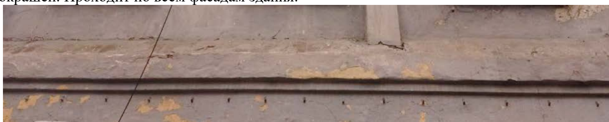
Восточный фасад. Межэтажный карниз
