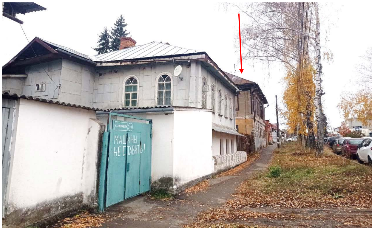
Фото 13. Выявленный объект культурного наследия «Дом жилой», г. Курск, ул. Карла Либкнехта, 30. Вид с юга. Фото Коротеевой Е.В. 11.11.2024 г.
