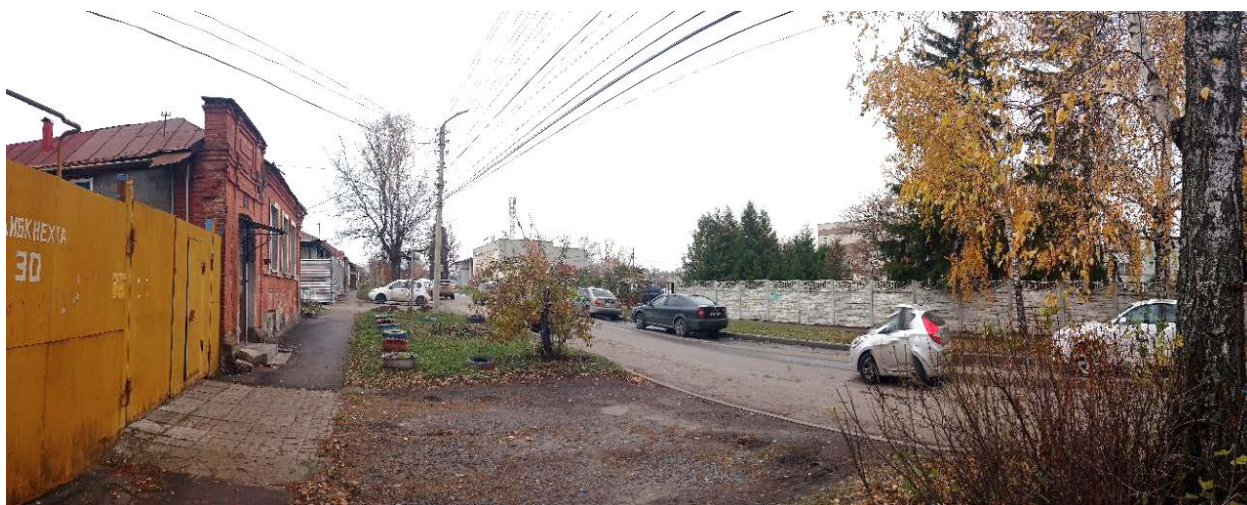
Фото 16. Выявленный объект культурного наследия «Дом жилой», г. Курск, ул. Карла Либкнехта, 30а. Общий вид с юга. Фото Коротеевой Е.В. 11.11.2024 г.
