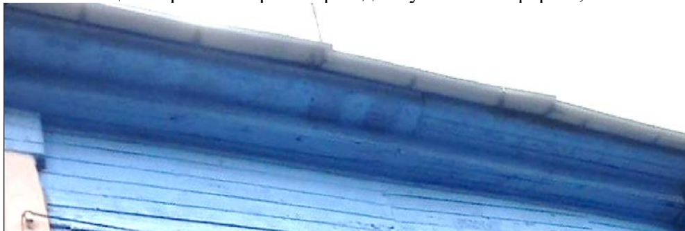
Северный фасад. Венчающий карниз
