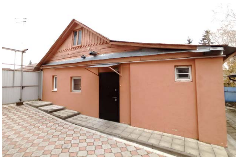
Западный фасад. Общий вид
