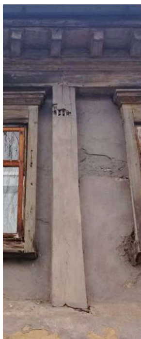
Восточный фасад. Лопатка второго этажа
