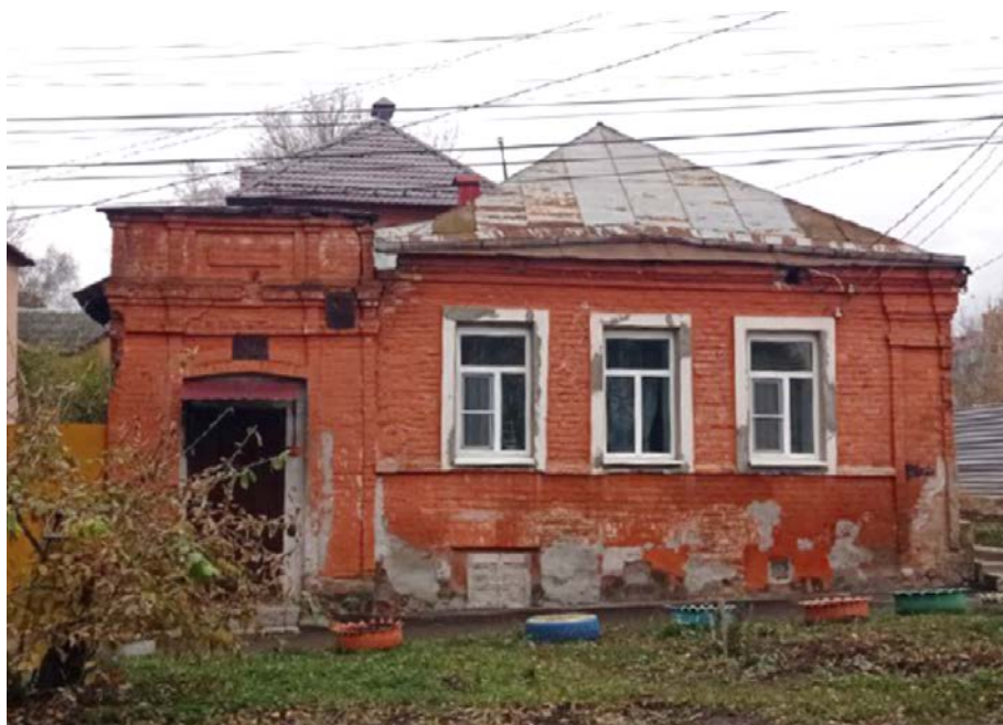
Главный (восточный) фасад. Общий вид
