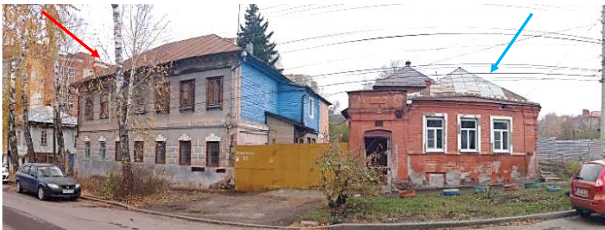
Фото 1. Выявленный объект культурного наследия «Городская усадьба М.В. Пузанова, конец XIX – нач. XX вв.: - Главный дом, - Флигель», конец XIX – нач. XX вв, г. Курск, ул. Карла Либкнехта, 30, 30а. Красным цветом указан выявленный объект культурного наследия «Дом жилой», г. Курск, ул. Карла Либкнехта, 30. Синим – выявленный объект культурного наследия «Дом жилой», г. Курск, ул. Карла Либкнехта, 30а. Общий вид с востока. Фото Коротеевой Е.В. 11.11.2024 г.
