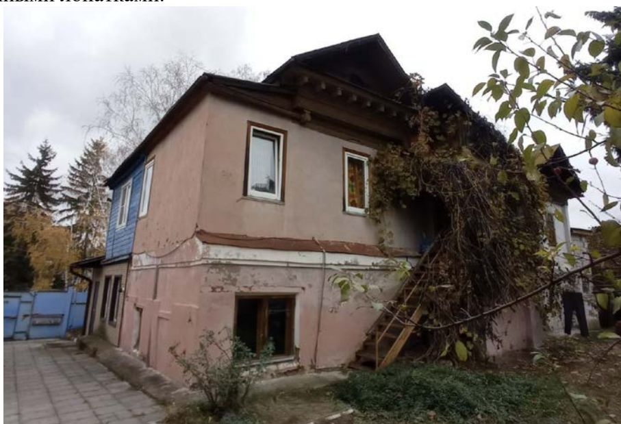
Фрагмент южного фасада. Общий вид
