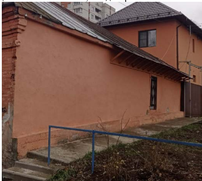
Северный фасад. Общий вид
