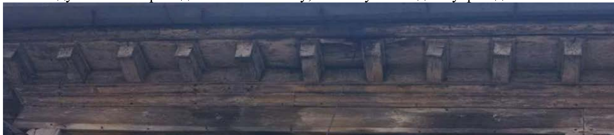
Восточный фасад. Венчающий карниз
