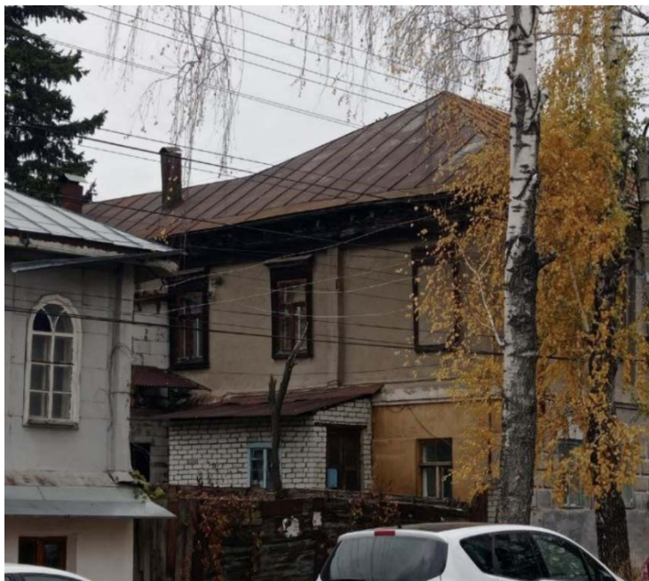
Фрагмент южного фасада. Общий вид
