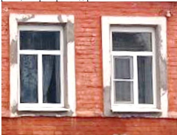
Восточный фасад. Оконные проемы
