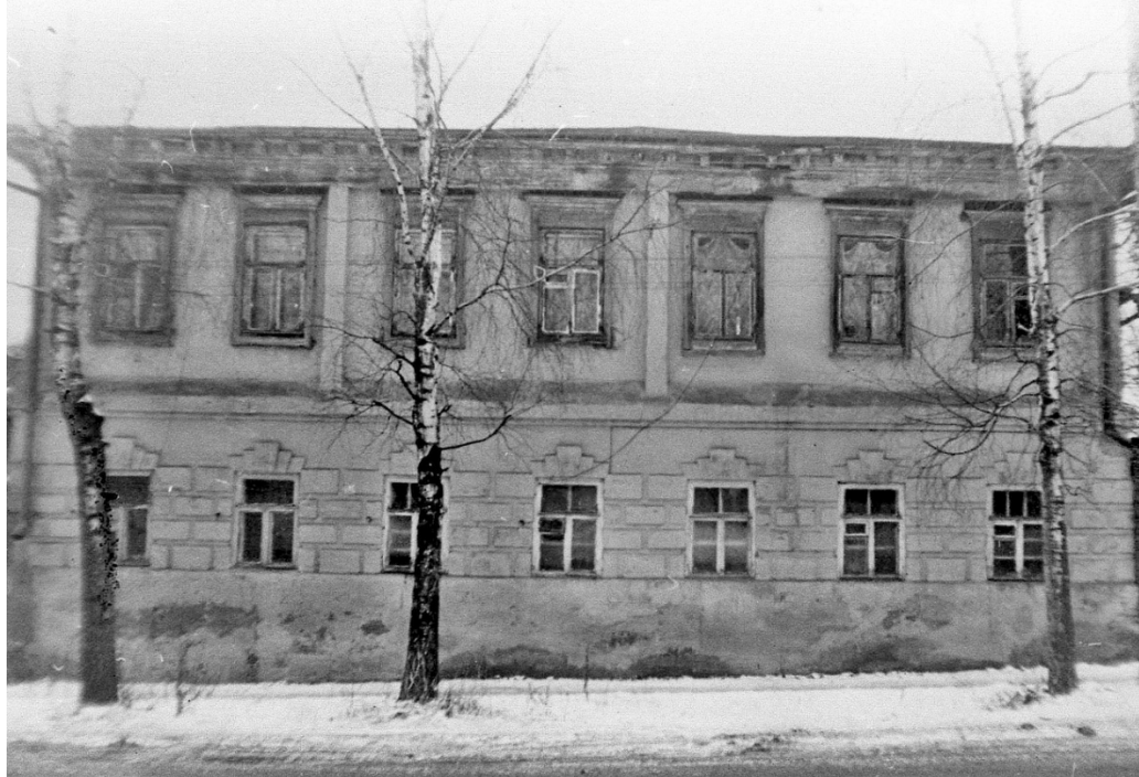
Иллюстрация 28 – выявленный объект культурного наследия «Городская усадьба М.В. Пузанова, конец XIX – нач. XX вв.: - Главный дом, - Флигель», конец XIX – нач. XX вв., г. Курск, ул. Карла Либкнехта, 30. Источник: ГАКО. Фотодокументы. Ед. хр. № 0-56626. Ул. К. Либкнехта, 30. 1990-е гг.
