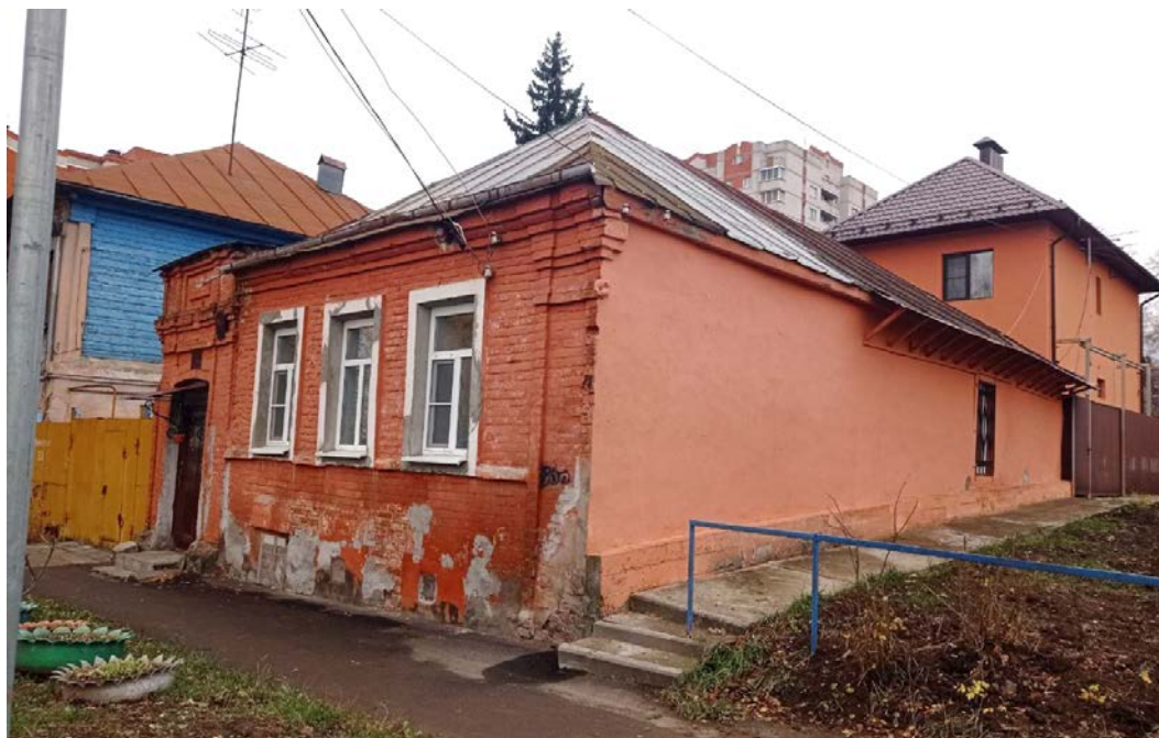
Фото 17. Выявленный объект культурного наследия «Дом жилой», г. Курск, ул. Карла Либкнехта, 30а. Северный и восточный фасады. Фото Коротеевой Е.В. 11.11.2024 г.
