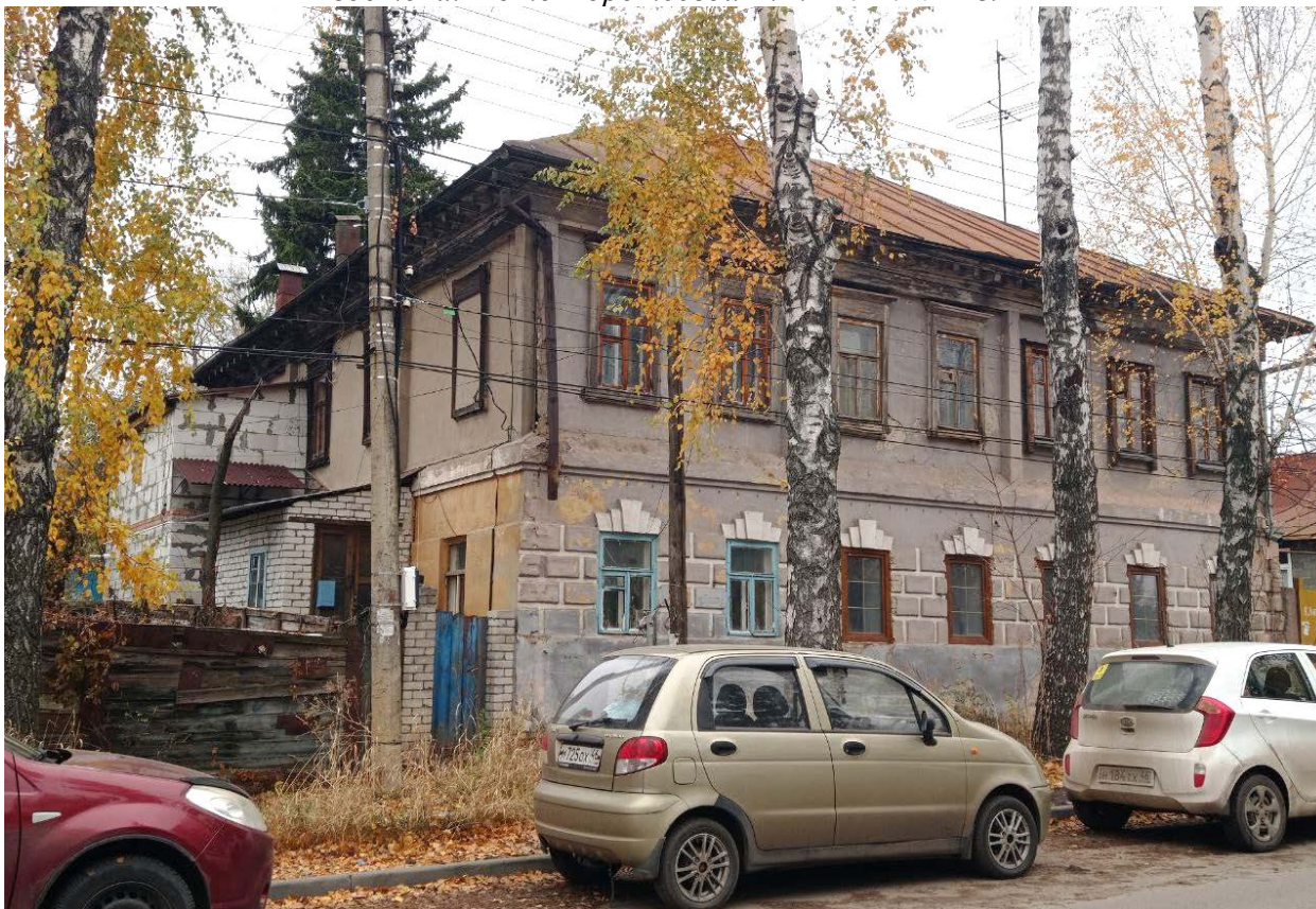
Фото 2. Выявленный объект культурного наследия «Дом жилой», г. Курск, ул. Карла Либкнехта, 30. Южный и восточный фасады. Фото Коротеевой Е.В. 11.11.2024 г.
