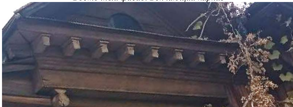
Западный фасад. Венчающий карниз
