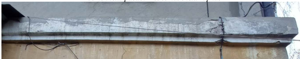
Южный фасад. Межэтажный карниз
