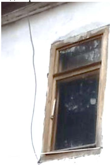
Восточный фасад. Оконный проем второго этажа
