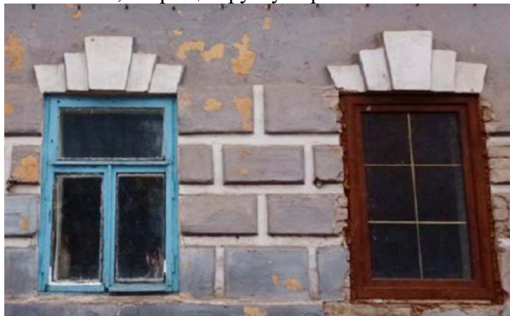
Дом № 30. Восточный фасад. Оконные проемы первого этажа
