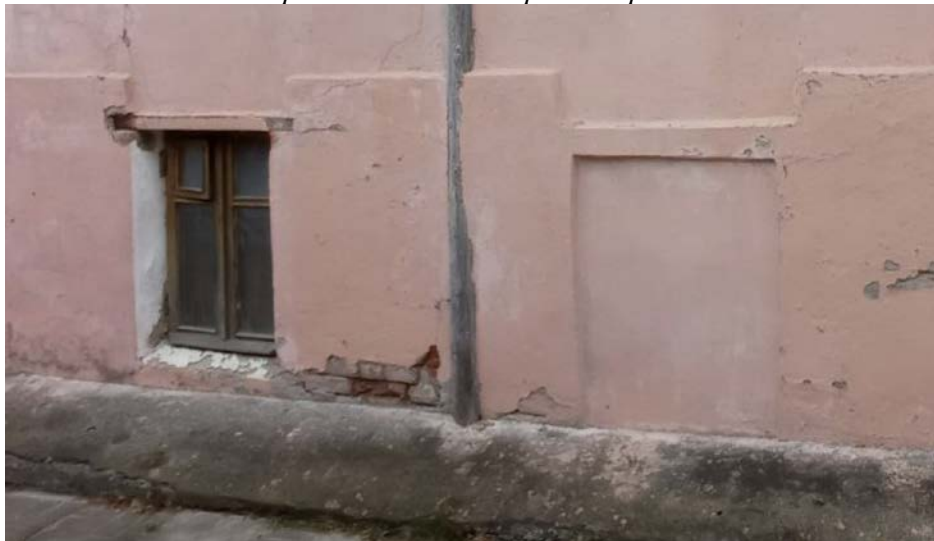
Северный фасад. Оконные проемы первого этажа
