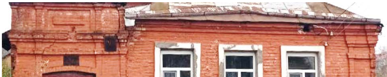
Восточный фасад. Венчающий карниз
