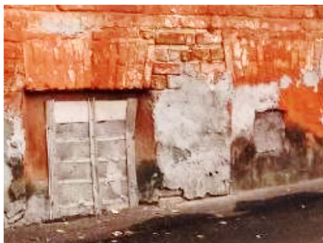
Восточный фасад. Оконные проемы
