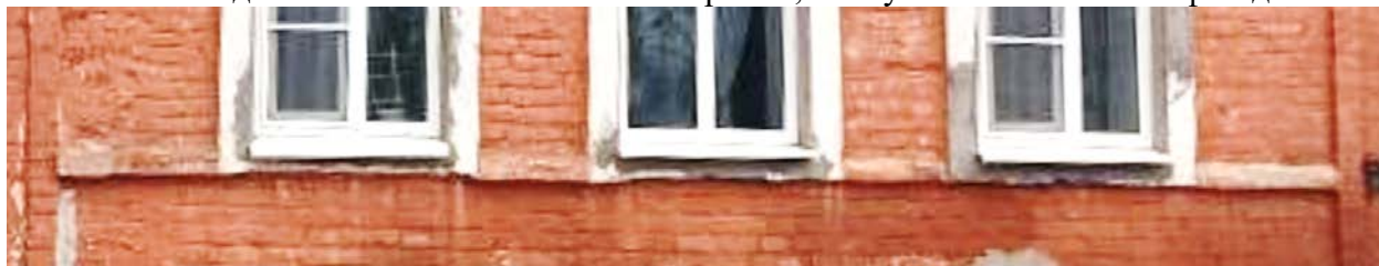
Восточный фасад. Подоконный пояс
