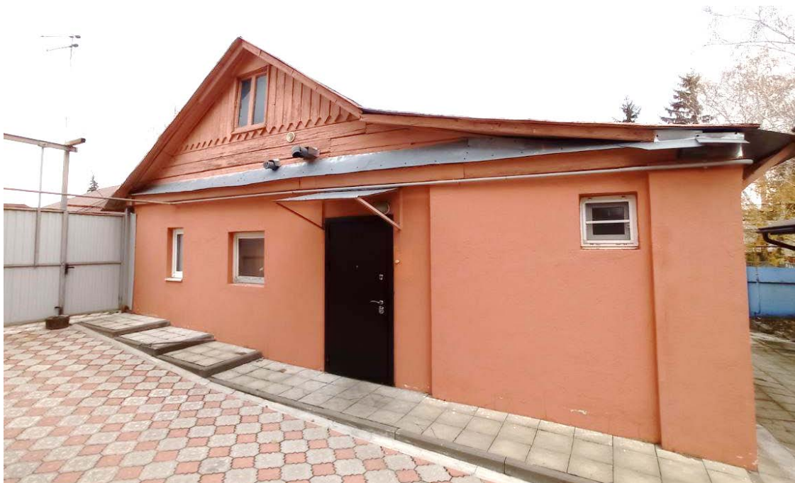
Фото 19. Выявленный объект культурного наследия «Дом жилой», г. Курск, ул. Карла Либкнехта, 30а. Западный фасад. Фото Коротеевой Е.В. 11.11.2024 г.
