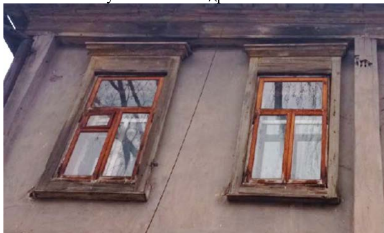
Восточный фасад. Оконные проемы второго этажа
