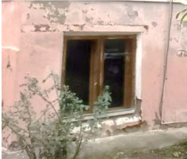
Западный фасад. Оконный проем первого этажа
