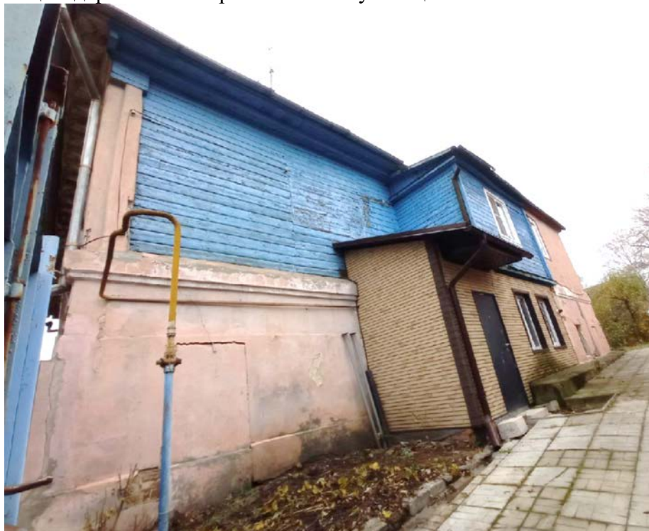
Северный фасад. Общий вид
