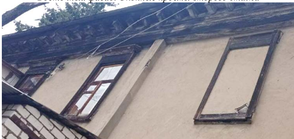
Южный фасад. Оконные проемы второго этажа
