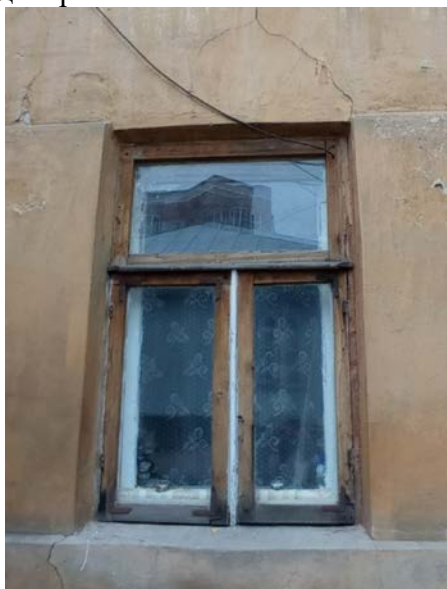
Южный фасад. Оконный проем первого этажа
