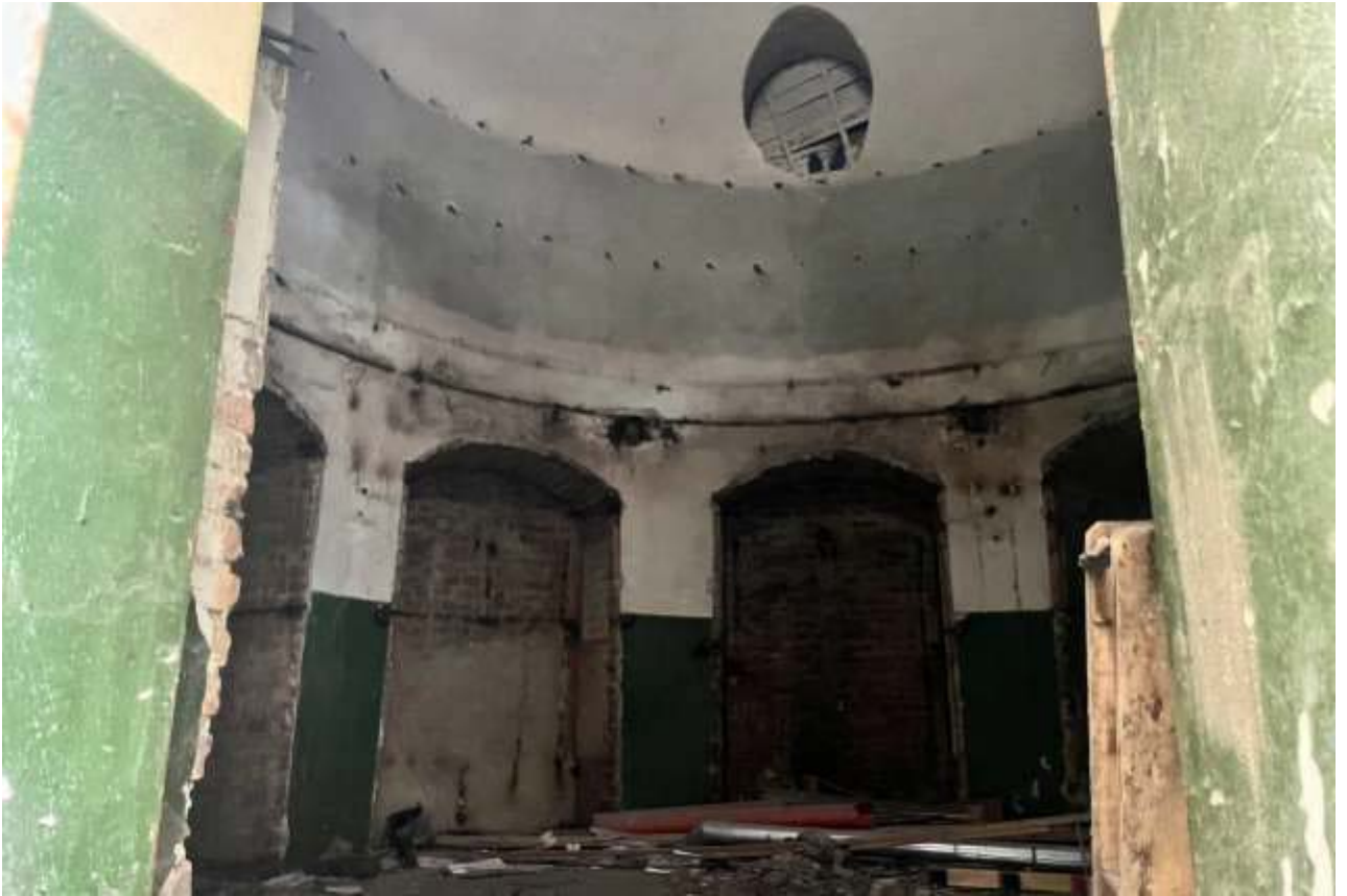
Фото интерьера верхнего яруса Башни ограды, январь 2025 г (текущее состояние)
