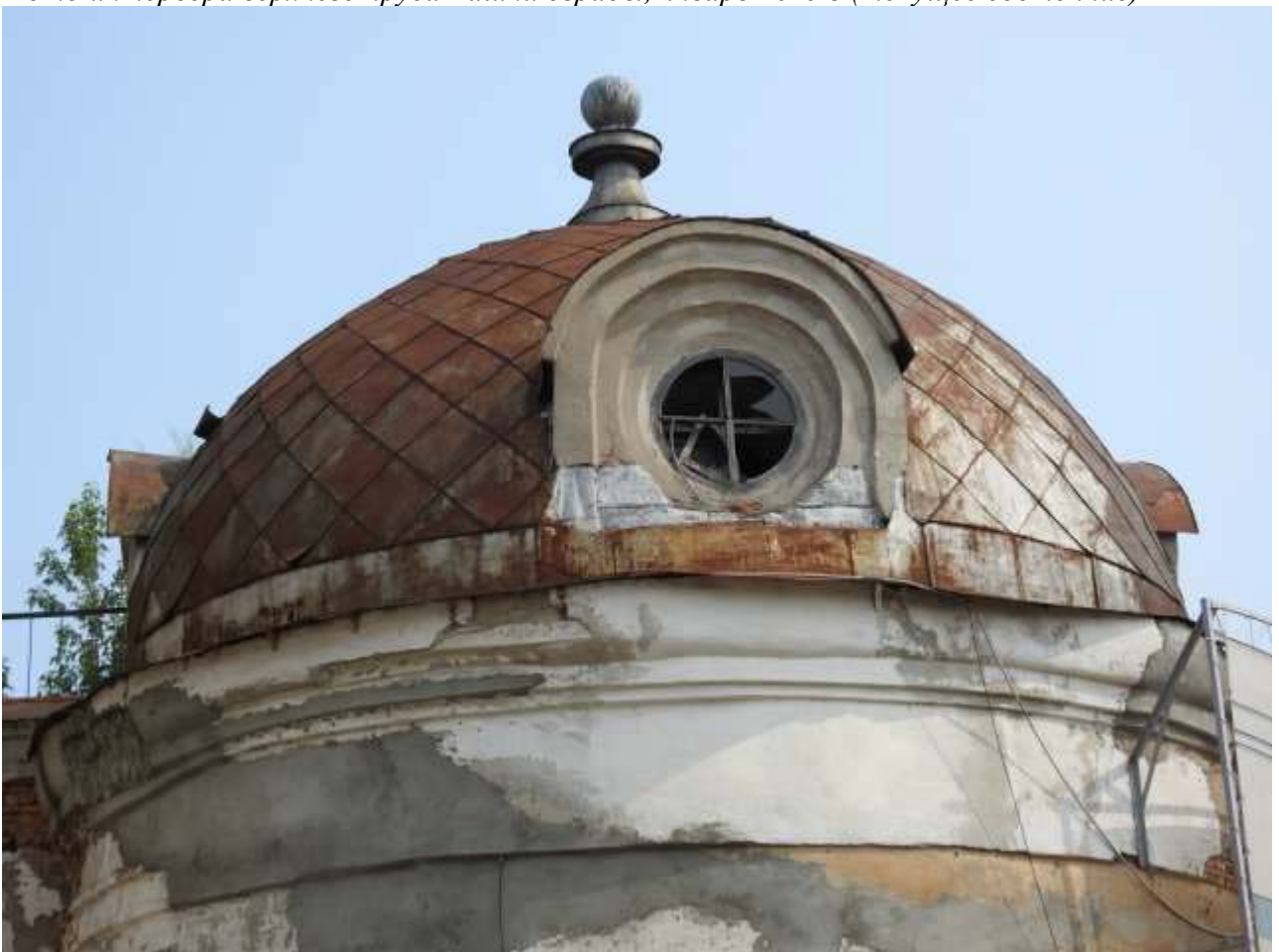
Фото кровли Башни ограды, июнь 2025 г. (текущее состояние)
