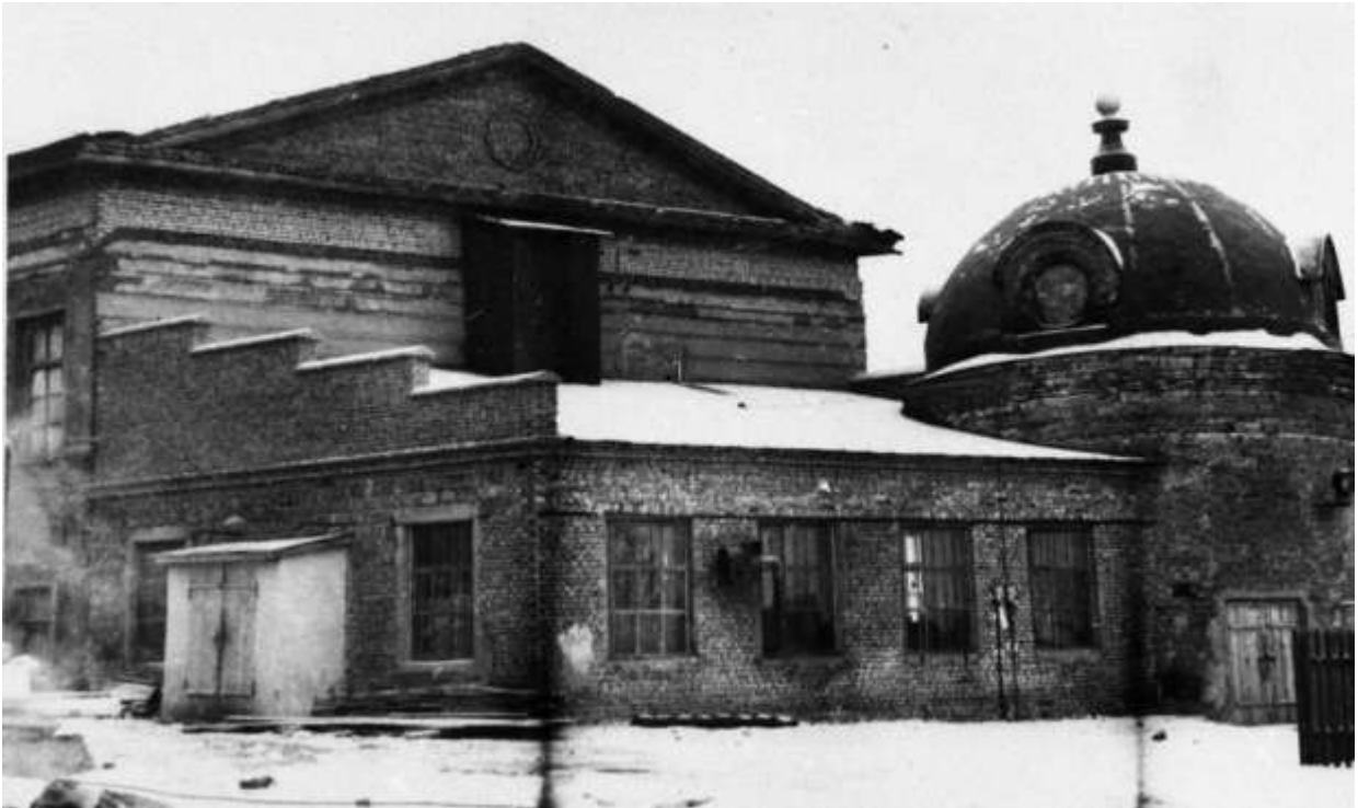
Фото пристроя к зданию Башни ограды, соединяющего ее с зданием Окружного суда (корпусом №5 Курского Электроаппаратного Завода) 1955 г.
