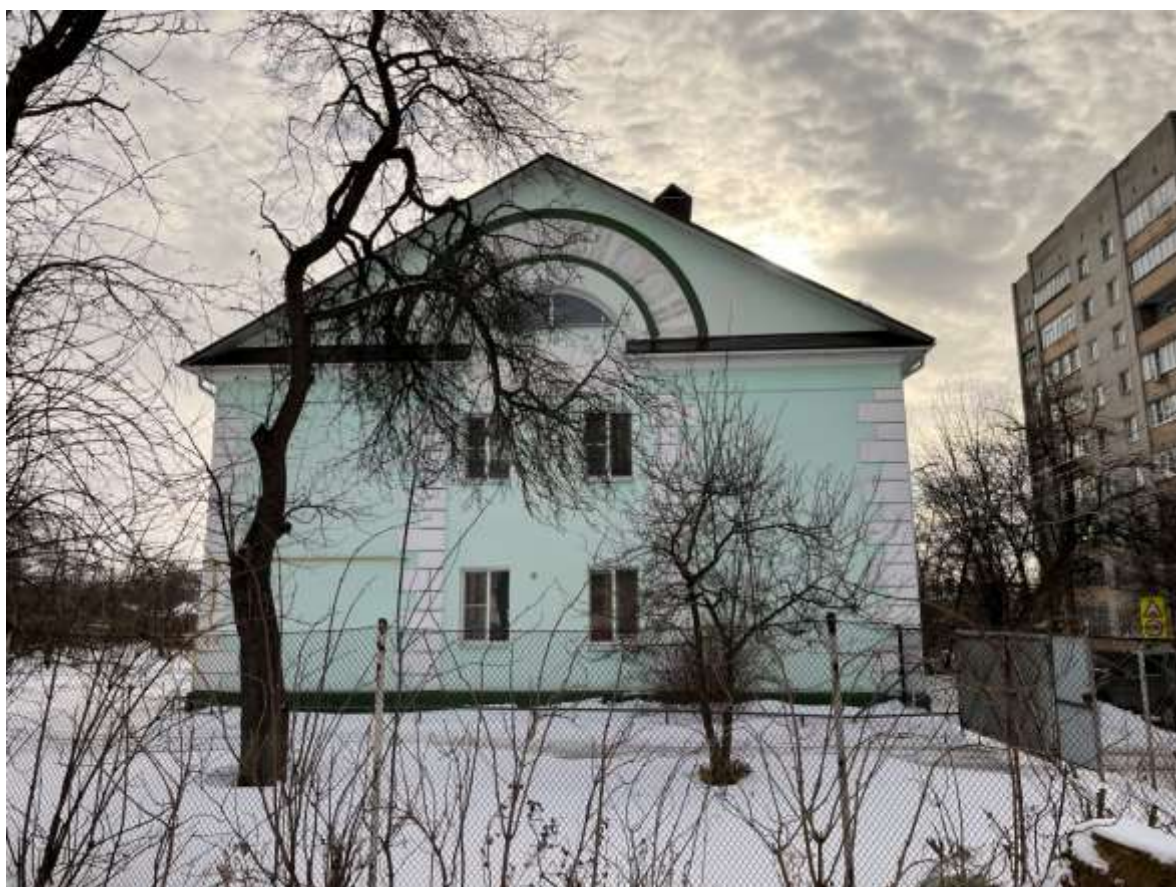
Т.ф. №4. Выявленный объект культурного наследия «Дом жилой», 1953 г. (Курская область, г. Курск, ул. Семёновская, д. 75). Северный фасад.
