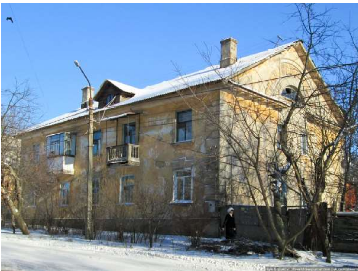
27. Вид Объекта до ремонтно-реставрационных работ. 2014 г. Источник: https://photobuildings.com/photo/1872/
