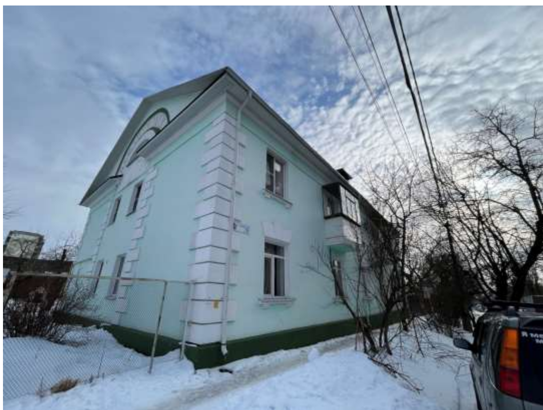
Т.ф. №2. Выявленный объект культурного наследия «Дом жилой», 1953 г. (Курская область, г. Курск, ул. Семёновская, д. 75). Вид с северо-запада.
