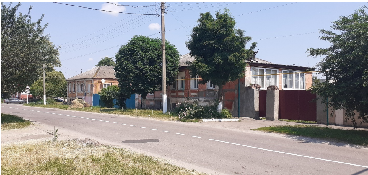
Фотография № 1. Вид с юго-запада на Объект.
