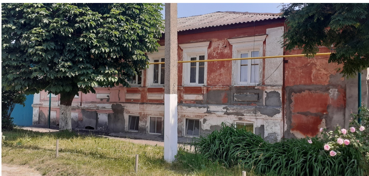
Фотография № 4. Вид с юго-запада на Объект.
