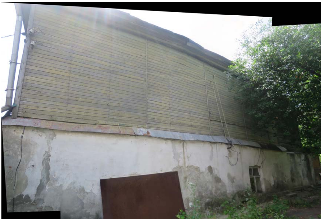
5. Вид с севера со двора.
