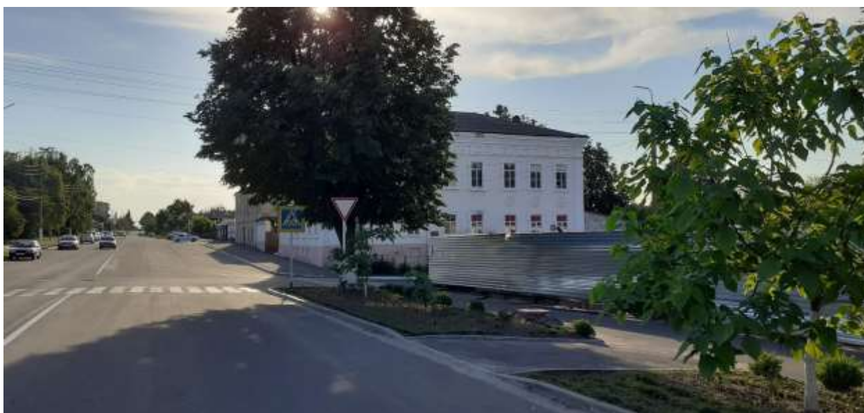
Фотография № 12. Вид с юго-востока на Объект.
