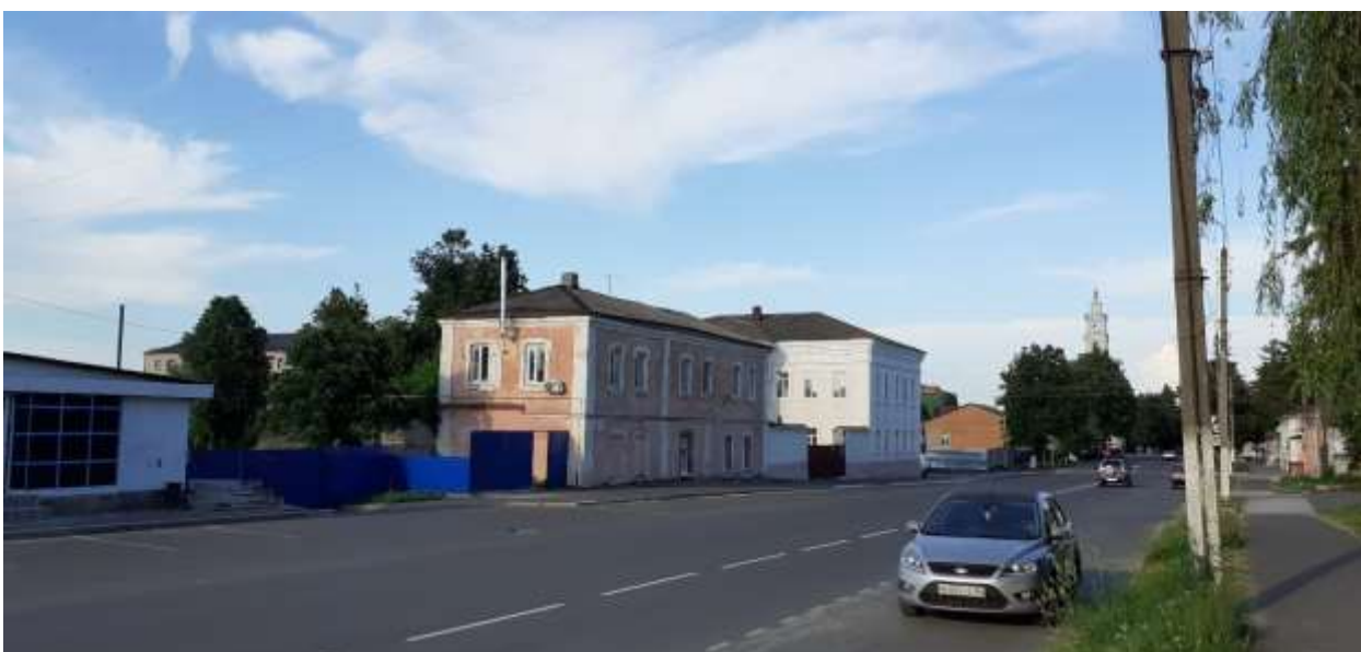
Фотография № 2. Вид с юго-запада на Объект.
