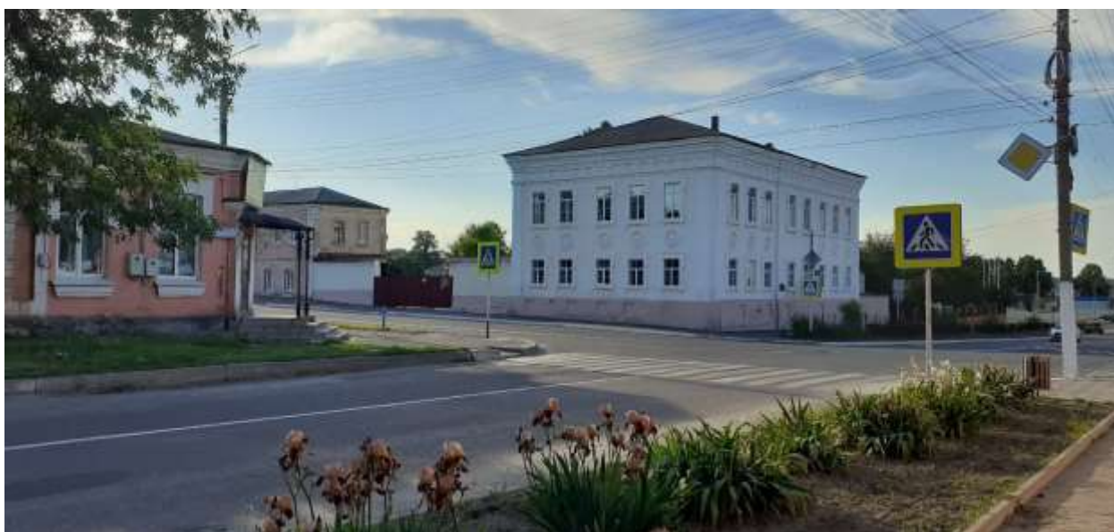
Фотография № 8. Вид с юго-востока на Объект.
