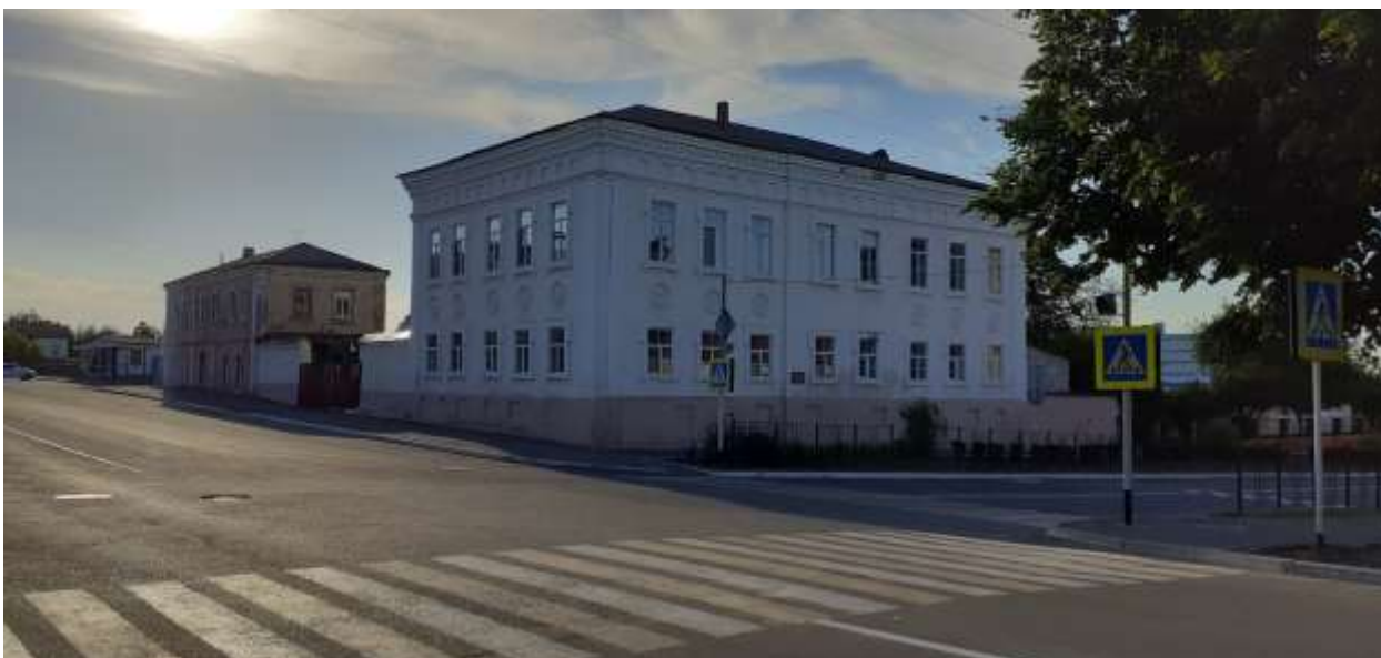
Фотография № 9. Вид с юго-востока на Объект.
