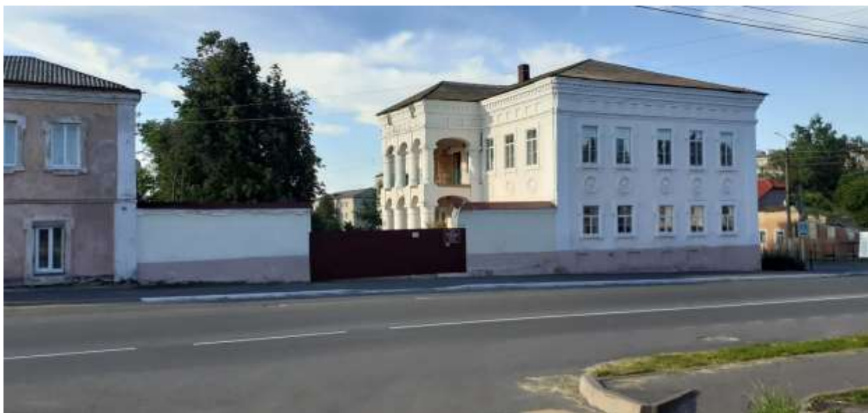
Фотография № 5. Вид с юго-запада на Объект.
