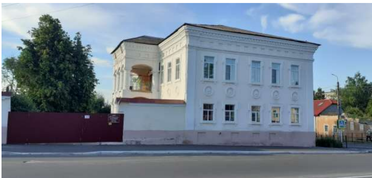
Фотография № 6. Вид с юго-запада на Объект.
