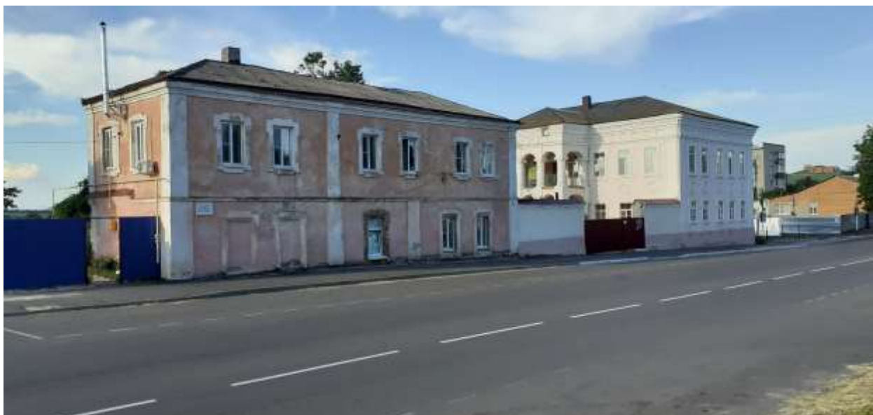
Фотография № 3. Вид с юго-запада на Объект.
