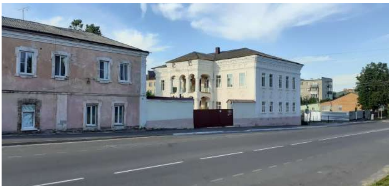
Фотография № 4. Вид с юго-запада на Объект.
