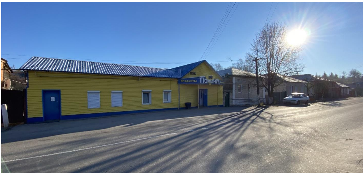
Фотография №1. Вид с северо-запада на Объект.
