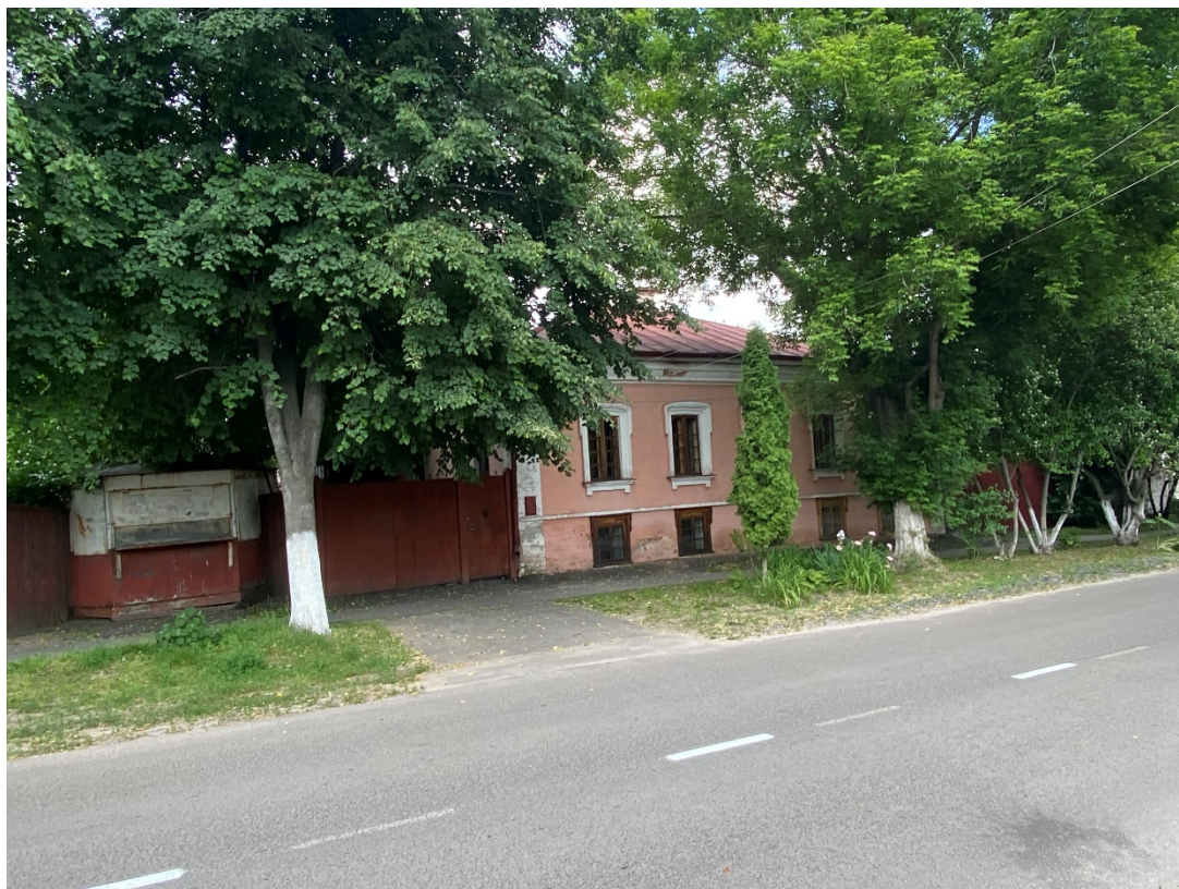
Фотография № 4. Вид с юго-запада на Объект.
