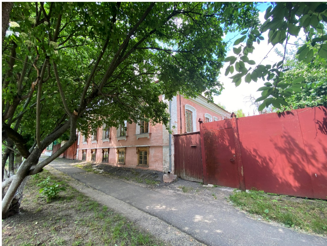
Фотография № 9. Вид с юго-востока на Объект.
