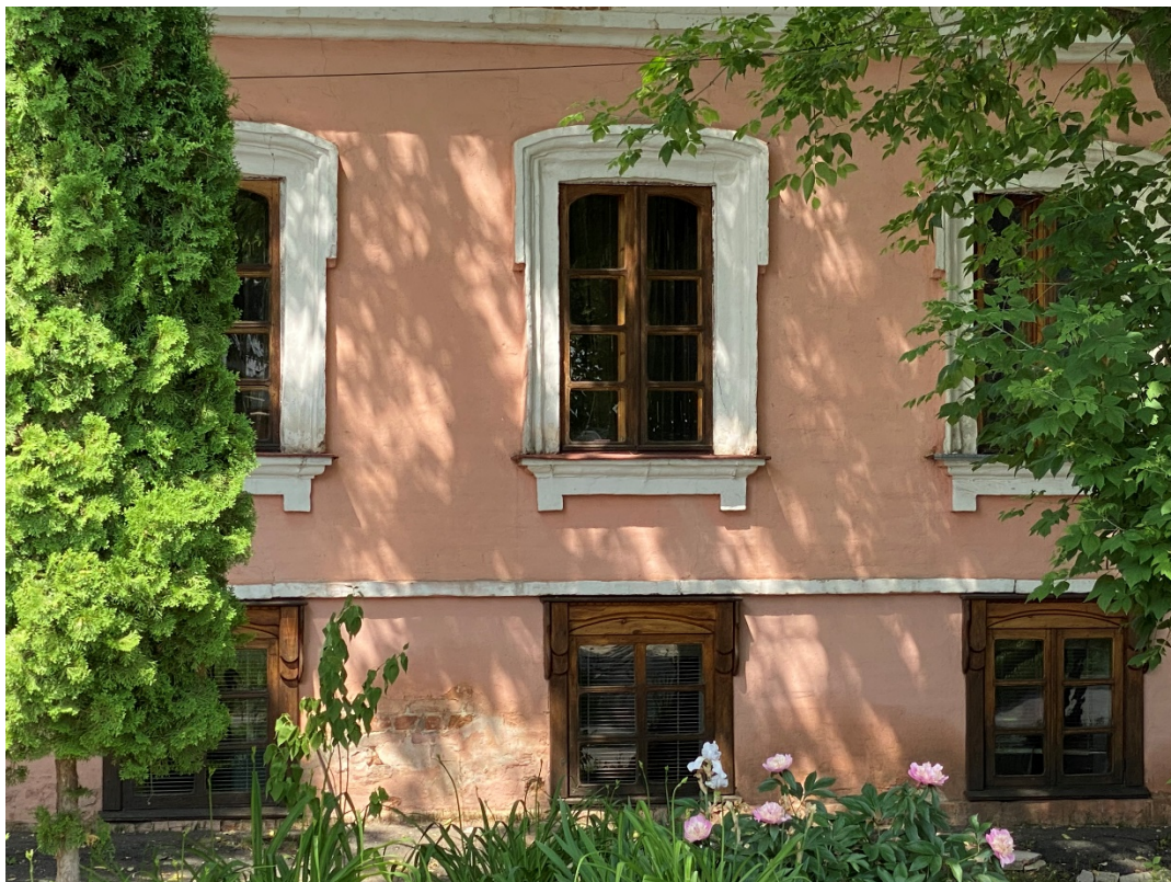
Фотография № 11. Вид с юга на Объект. Центральный фасад. Фрагмент.
