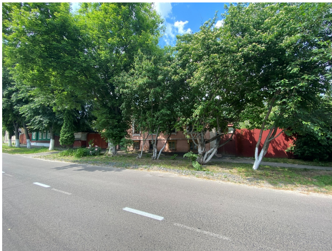
Фотография № 10. Вид с юго-востока на Объект.
