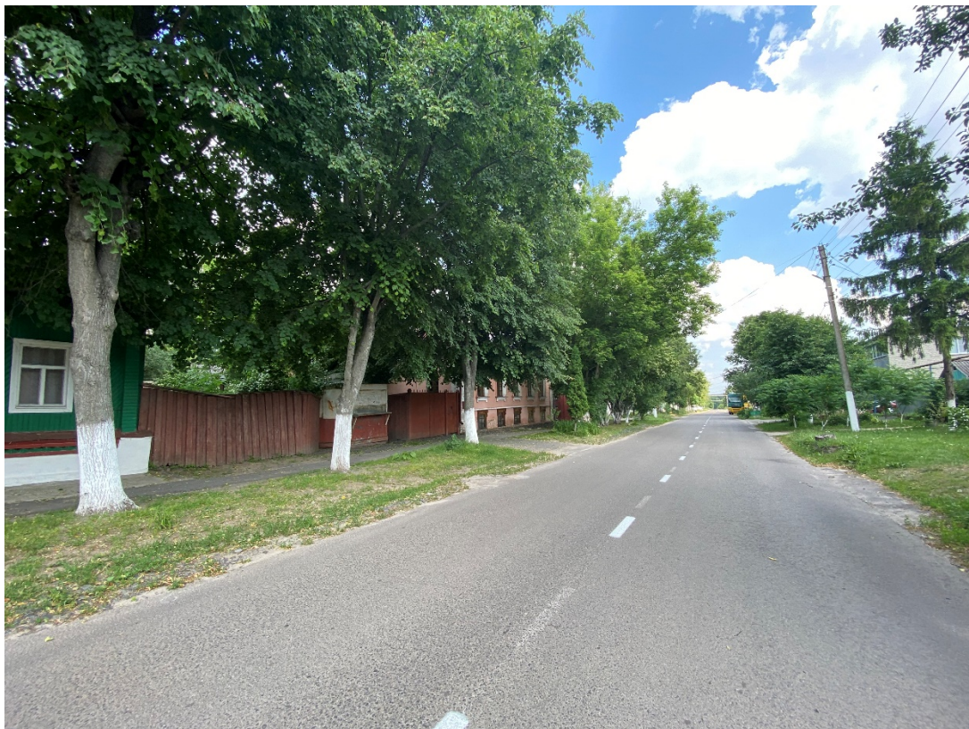
Фотография № 1. Вид с юго-запада на Объект.
