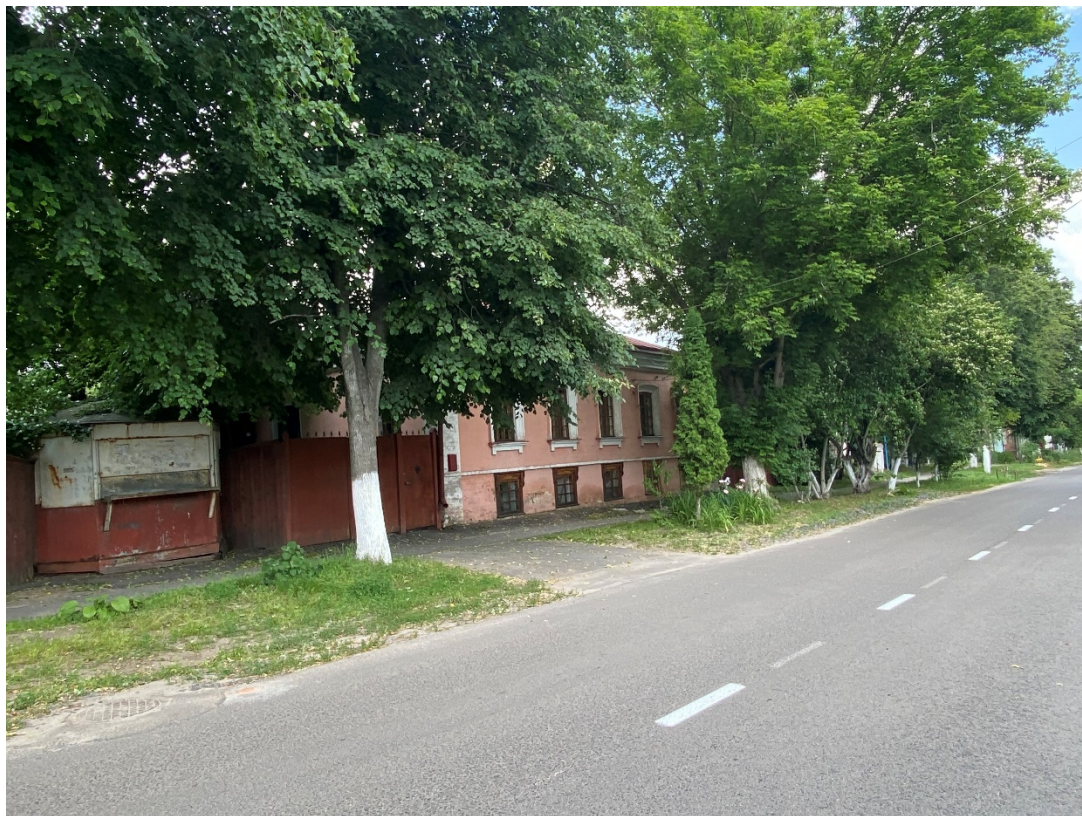
Фотография № 3. Вид с юго-запада на Объект.
