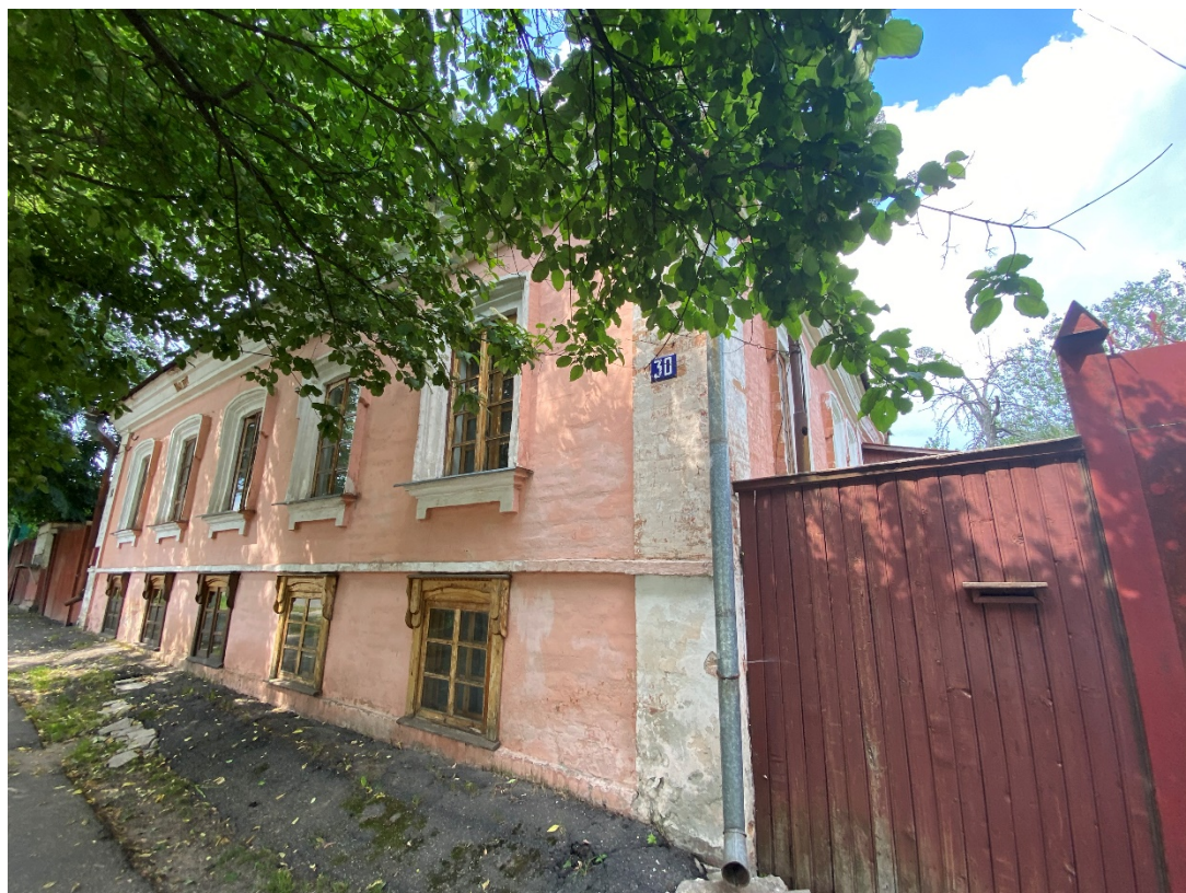
Фотография № 8. Вид с юго-востока на Объект.
