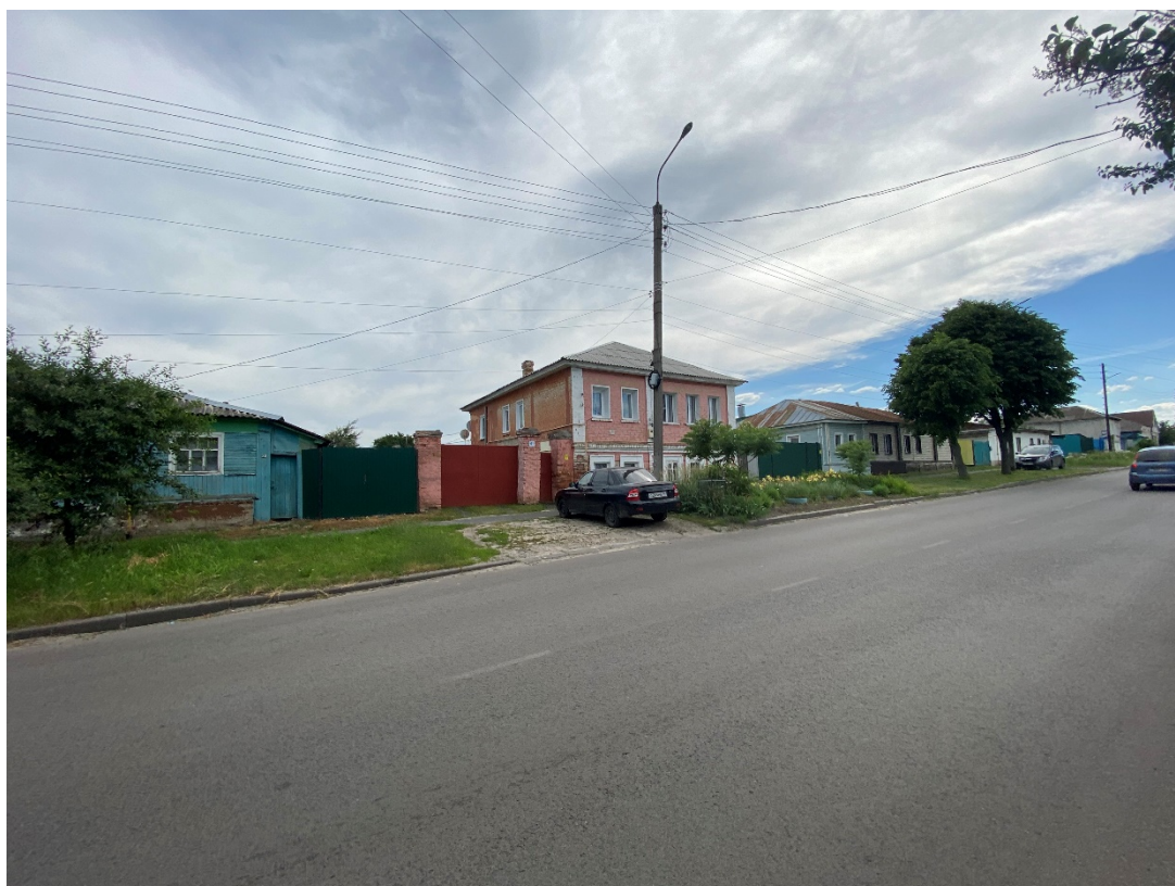
Фотография № 10. Вид с северо-востока на Объект.
