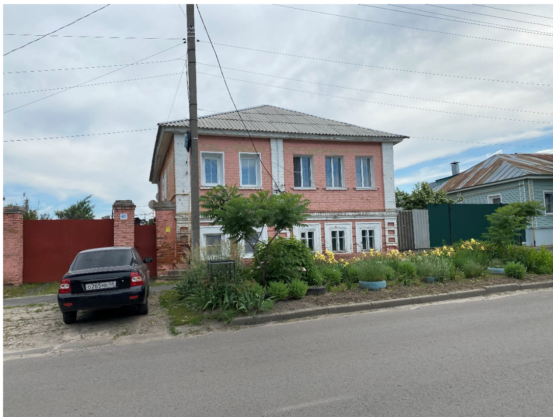
Фотография № 7. Вид с северо-востока на Объект.
