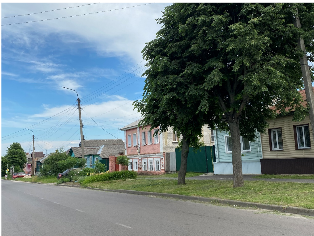
Фотография № 2. Вид с северо-запада на Объект.
