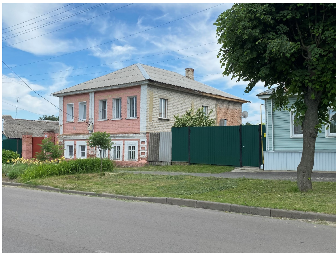
Фотография № 4. Вид с северо-запада на Объект.
