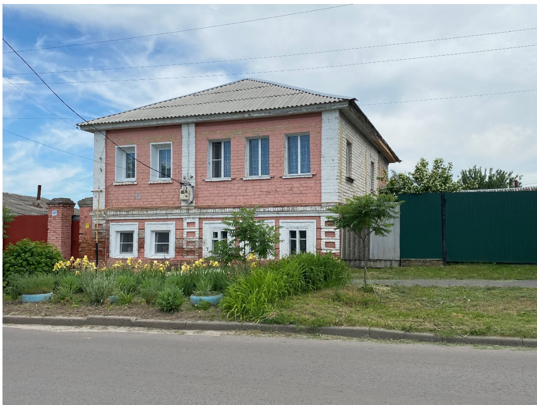
Фотография № 5. Вид с северо-запада на Объект.
