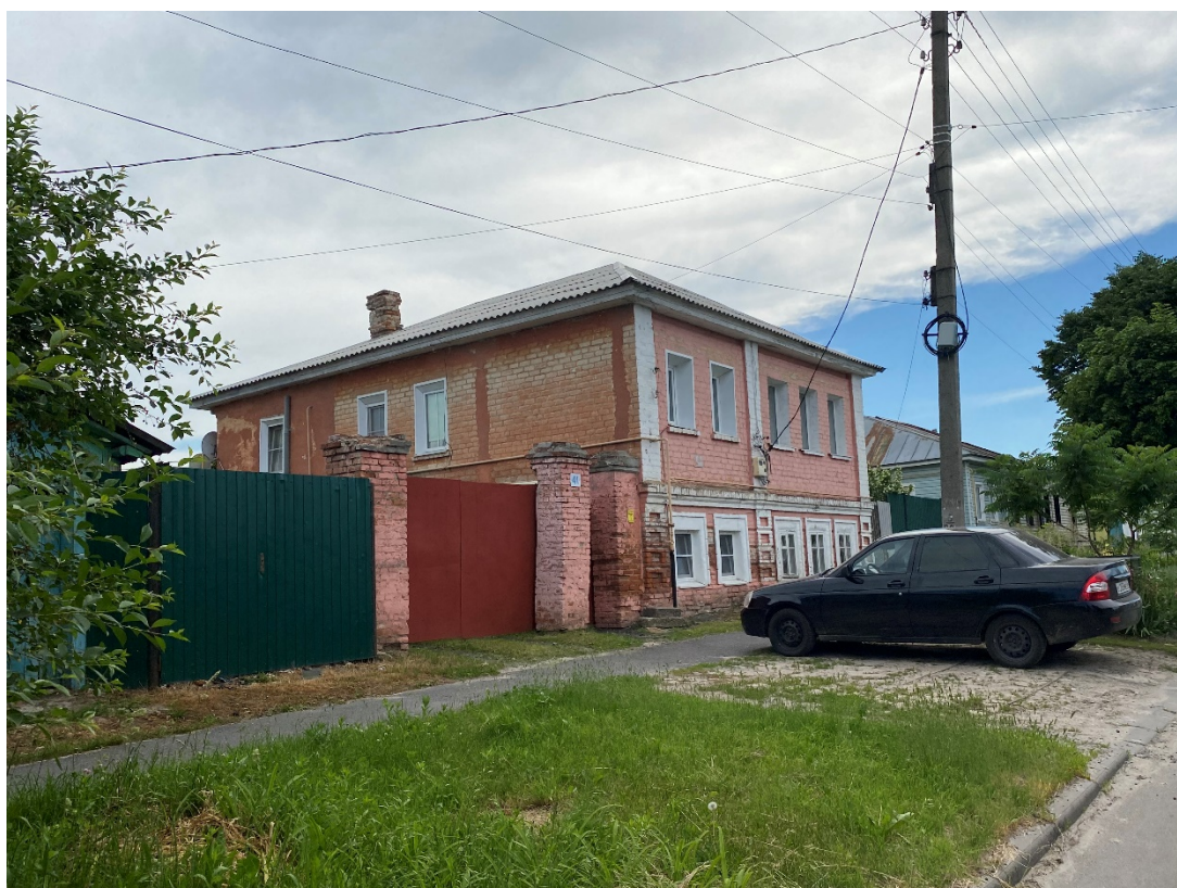
Фотография № 8. Вид с северо-востока на Объект.
