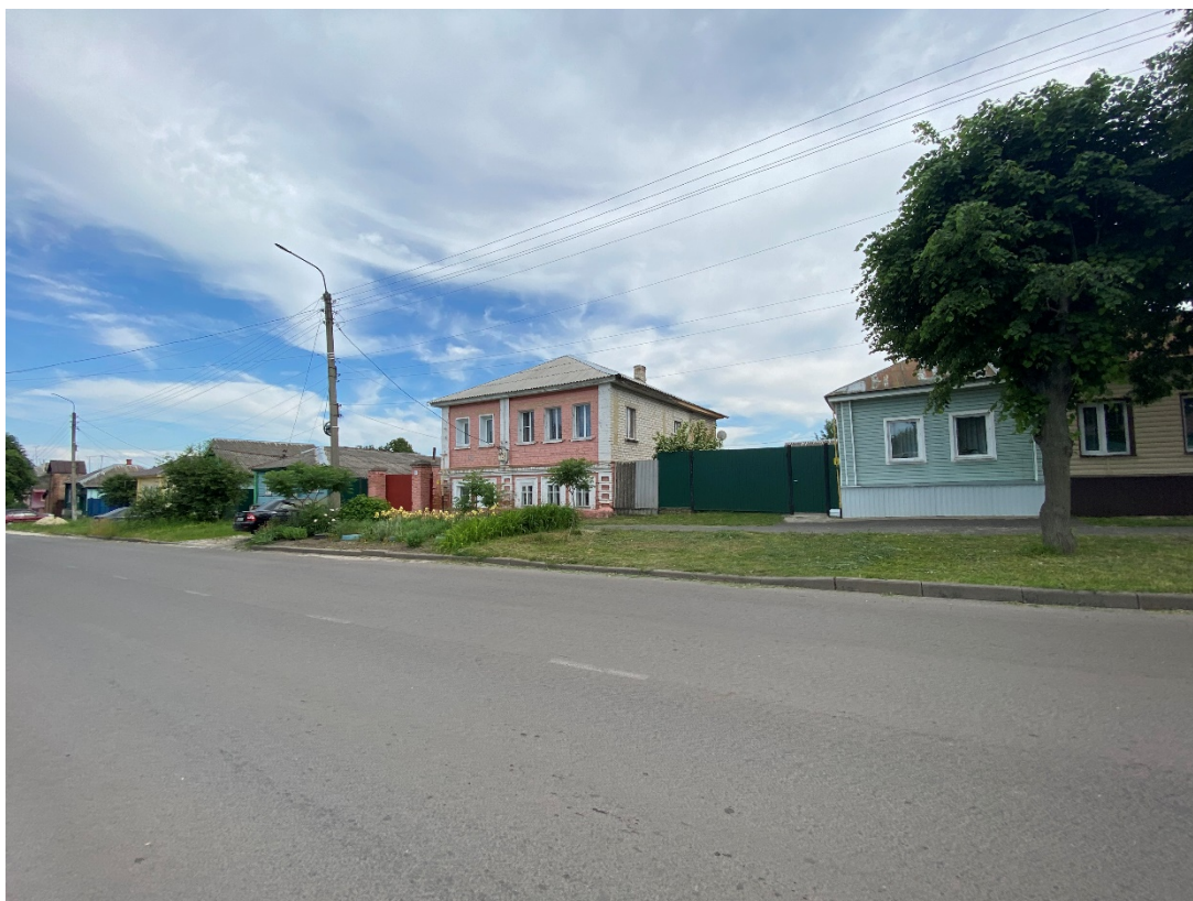
Фотография № 3. Вид с северо-запада на Объект.
