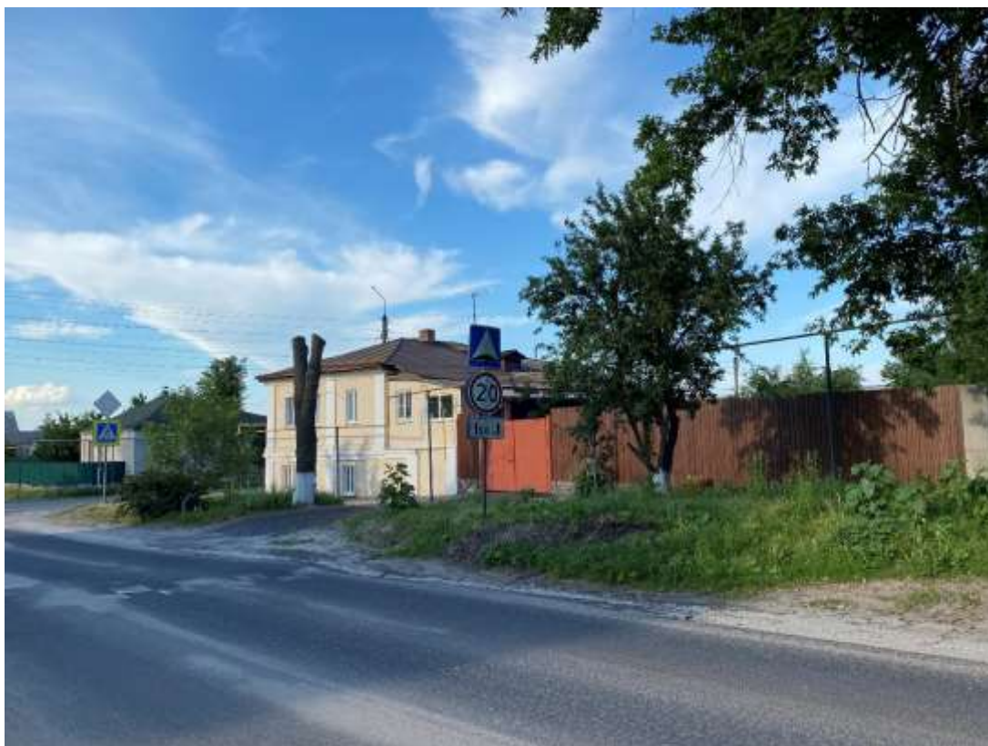
Фотография № 10. Вид с юго-запада на Объект.
