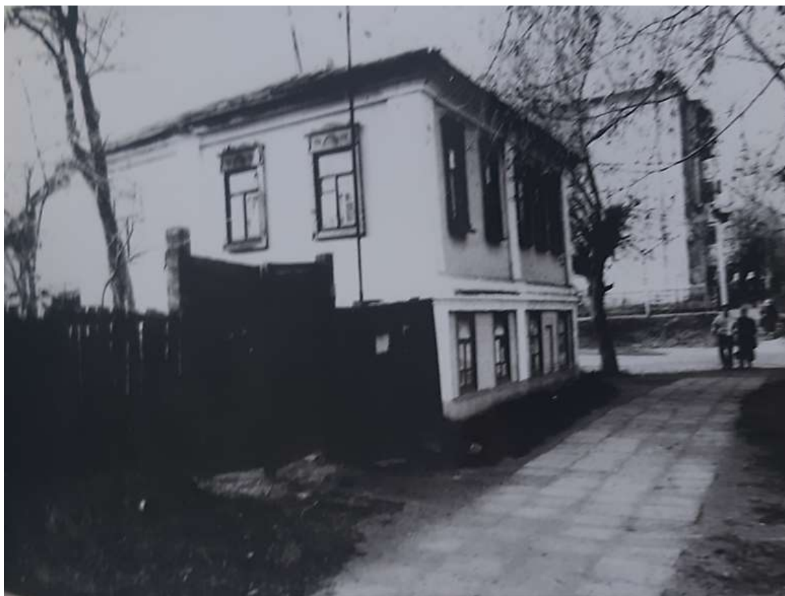
17. Дом по ул. Володарского, 67 (угловой дом по ул. К. Либкнехта). Здание Объекта на фотографии в «Проекте охранных зон г. Рыльска Курской обл.» 1990 года.
