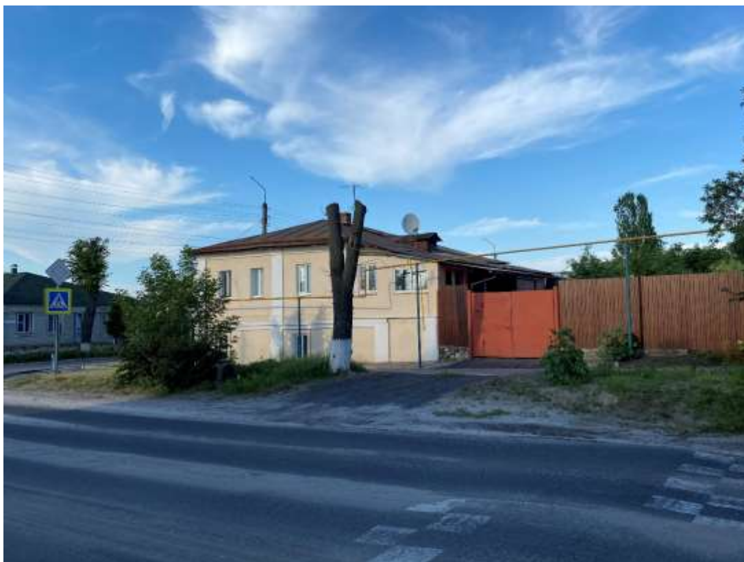
Фотография № 9. Вид с юго-запада на Объект.
