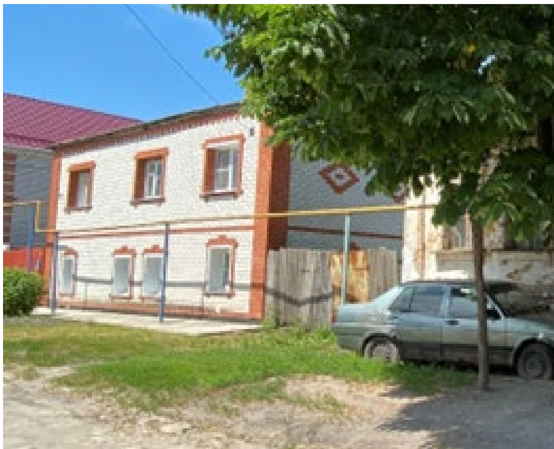
Фотография № 4. Вид с юго-востока на Объект.
