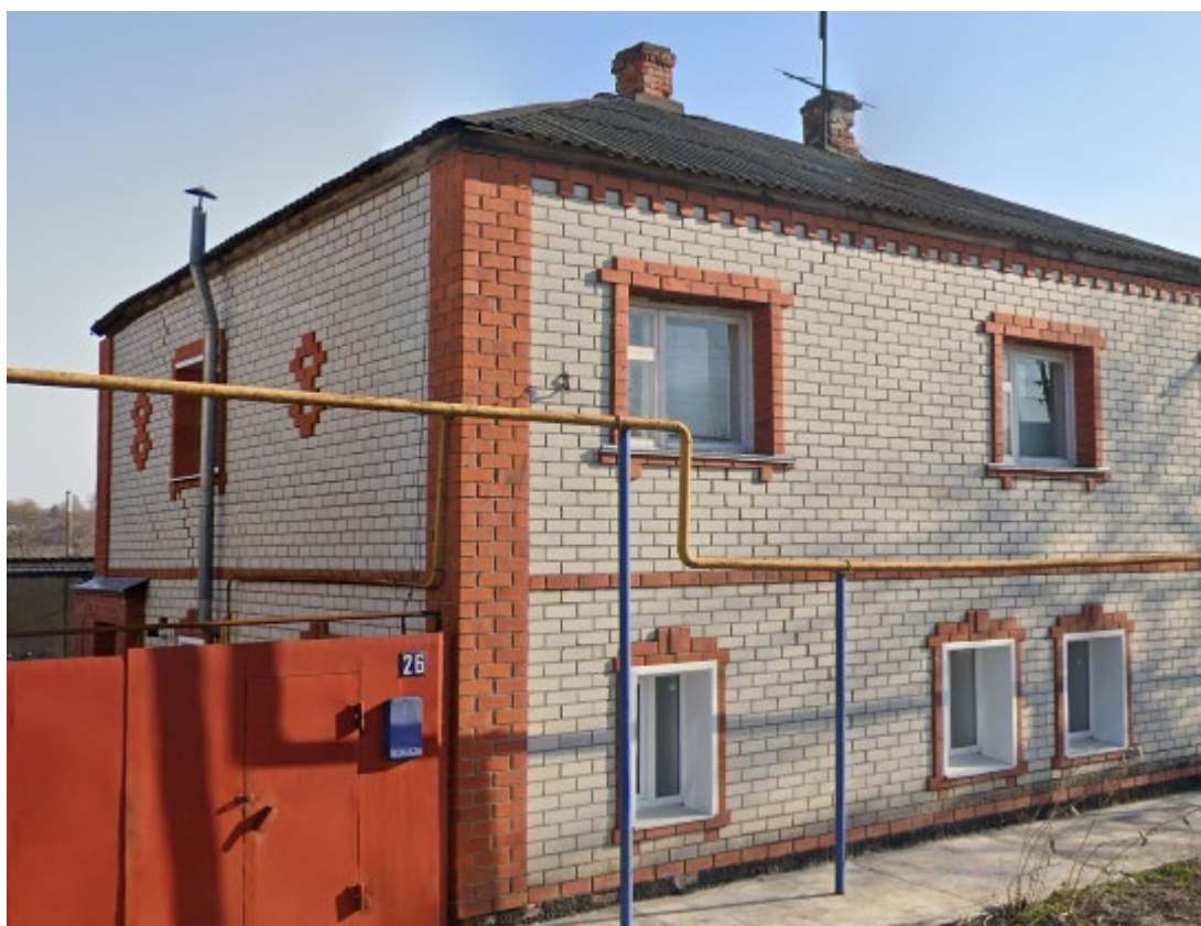
Фотография № 10. Вид с юго-запада на Объект. Угол центрального и западного фасадов.
