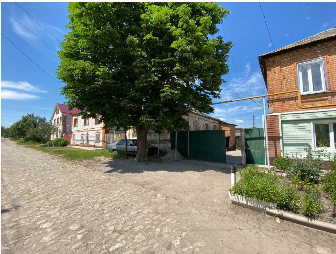
Фотография № 1. Вид с юго-востока на Объект.
