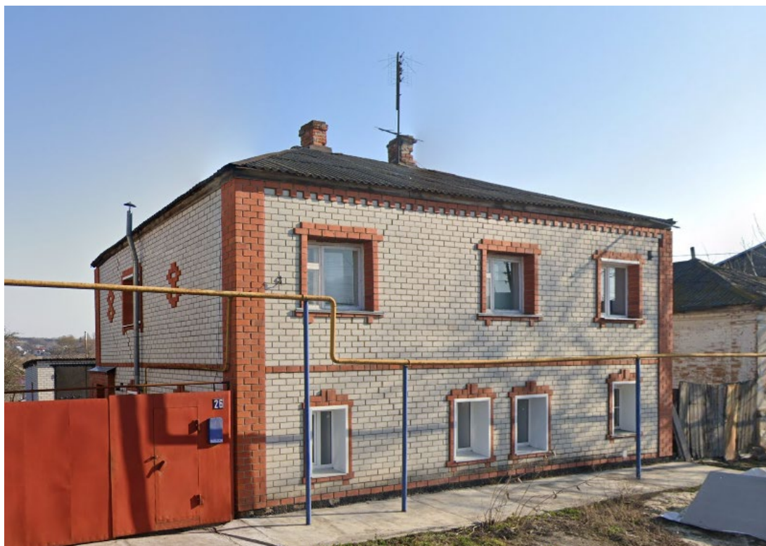
Фотография № 7. Вид с юго-запада на Объект.
