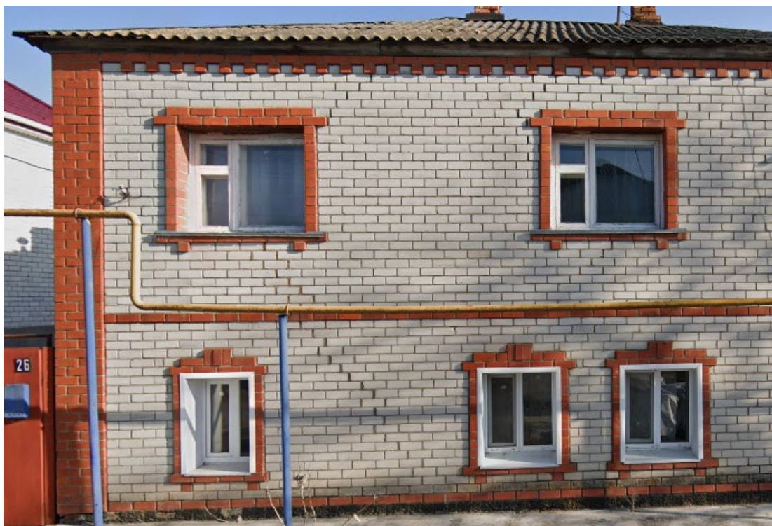
Фотография № 9. Вид с юга на Объект. Центральный фасад. Фрагмент.
