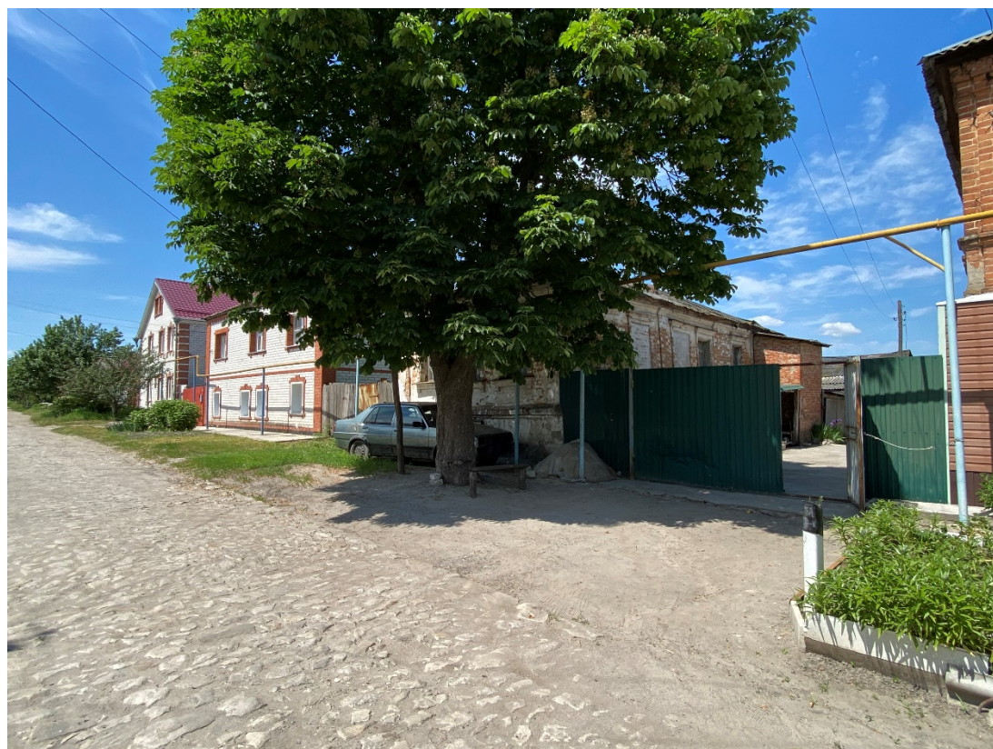
Фотография № 2. Вид с юго-востока на Объект.
