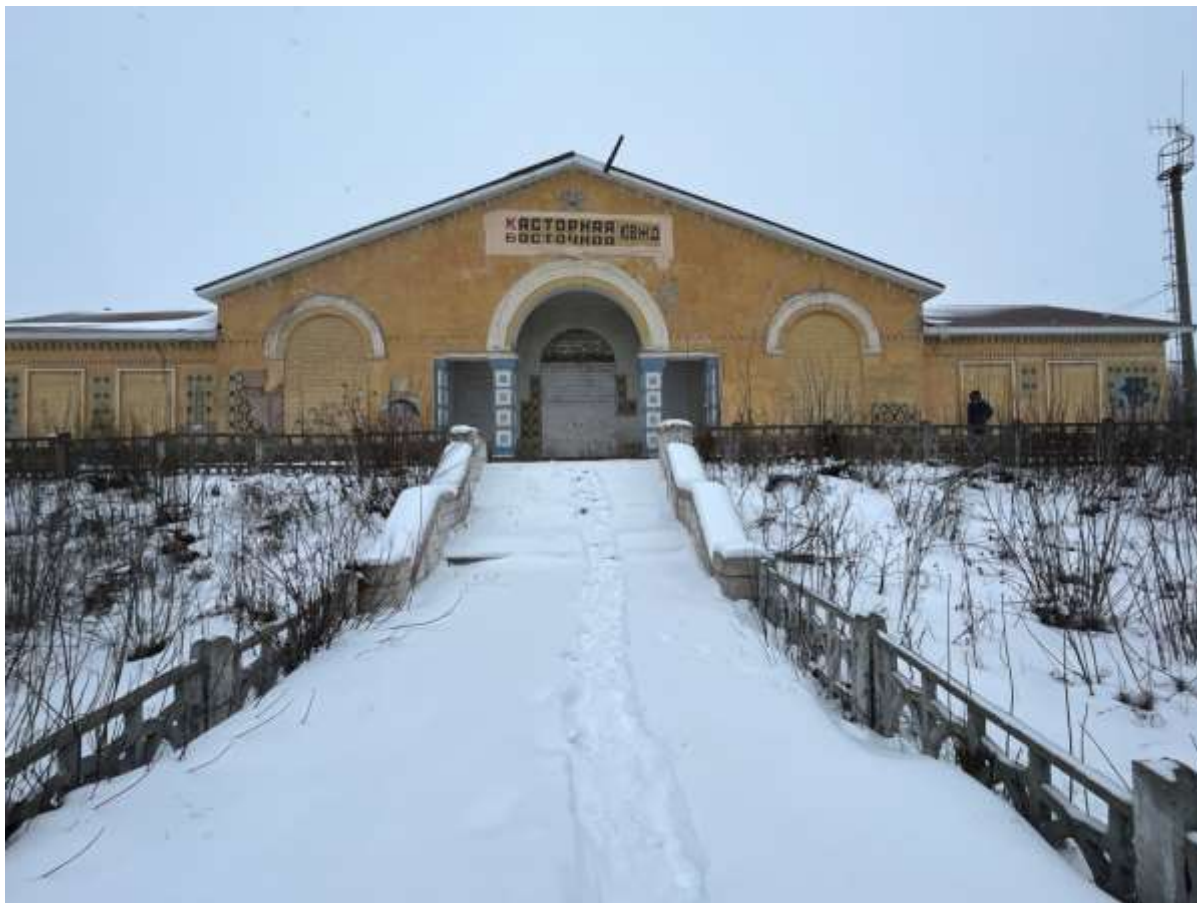
Т.ф. 1. Общий вид Объекта со стороны железнодорожных путей
