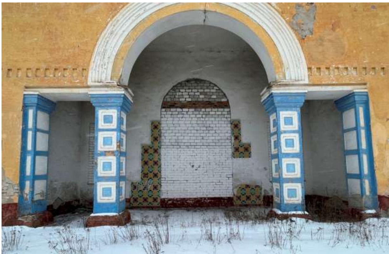
Т.ф. 3. Общий вид фрагмента фасада Объекта со стороны железнодорожных путей
