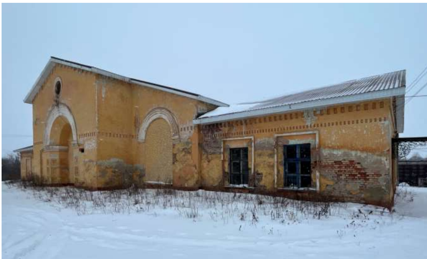
Т.ф. 6. Общий вид фасада Объекта со стороны пгт. Касторное
