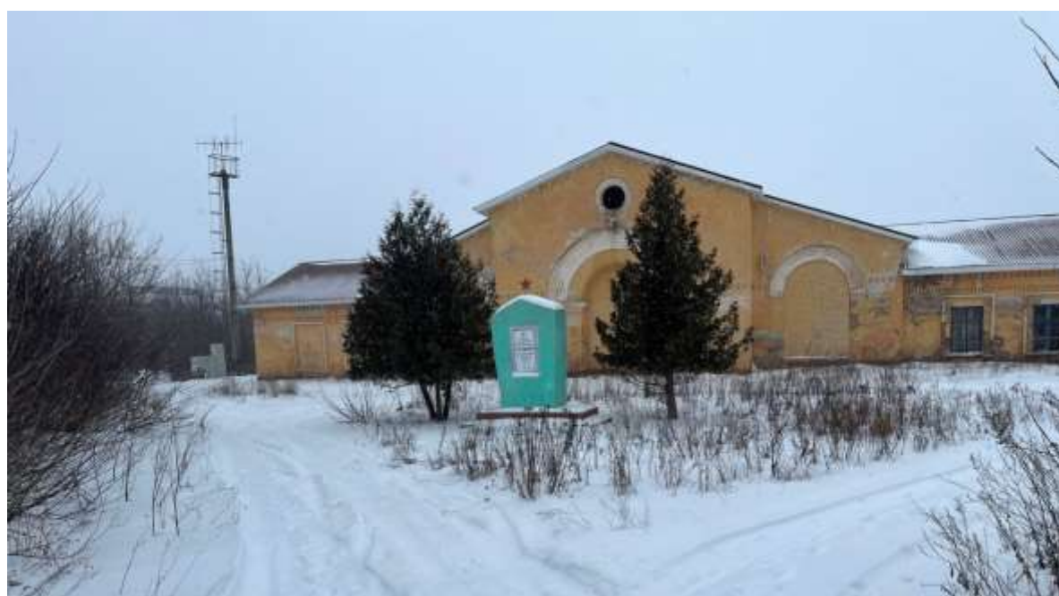
Т.ф. 2. Общий вид Объекта со стороны пгт. Касторное
