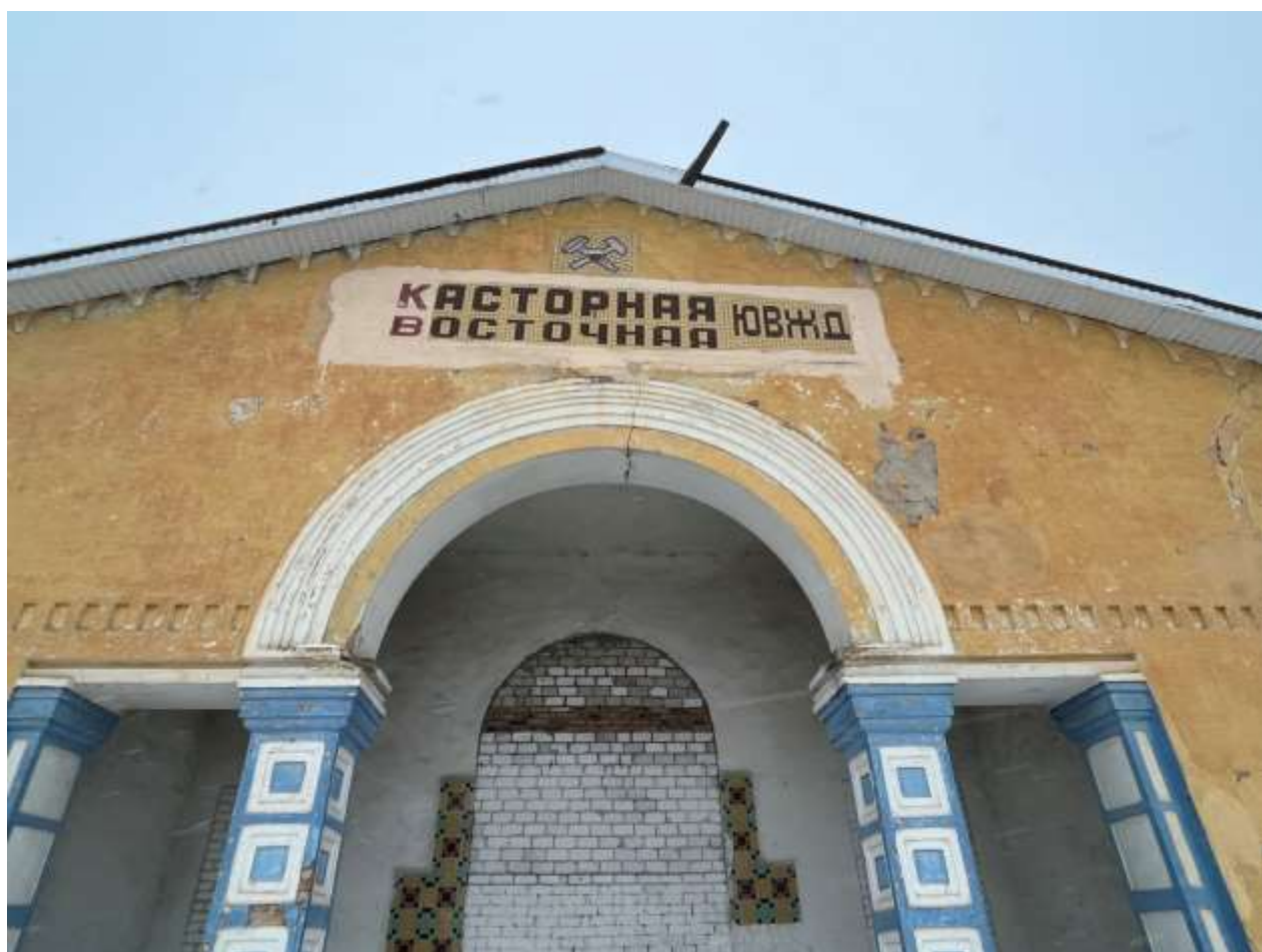
Т.ф. 4. Общий вид фрагмента фасада Объекта со стороны железнодорожных путей
