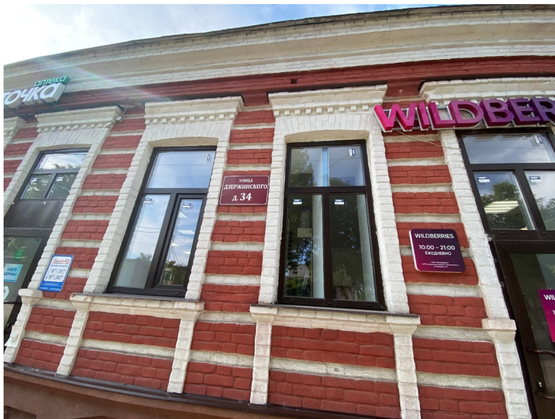
Фотография № 11. Вид с юга на Объект. Центральный (южный) фасад. Фрагмент.
