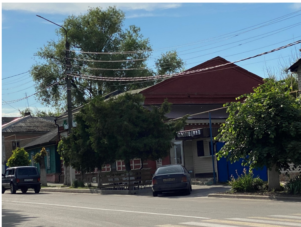
Фотография № 2. Вид с юго-востока на Объект.
