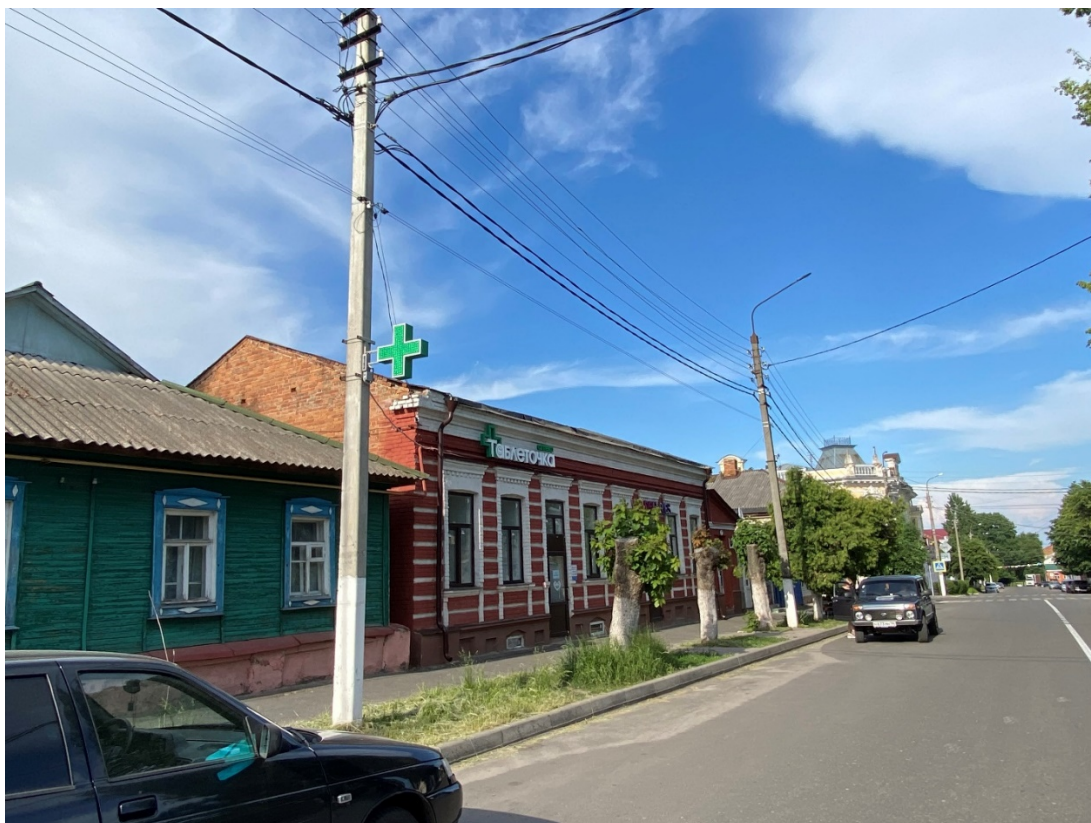
Фотография № 9. Вид с юго-запада на Объект.
