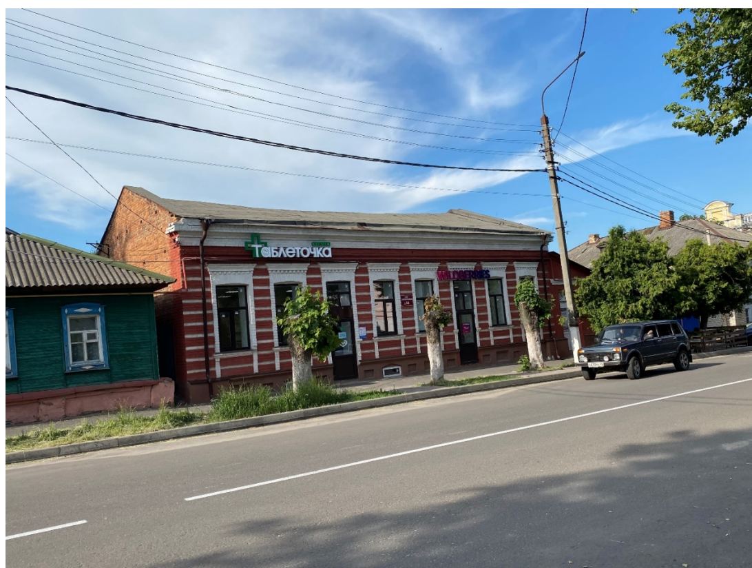
Фотография № 8. Вид с юго-запада на Объект.
