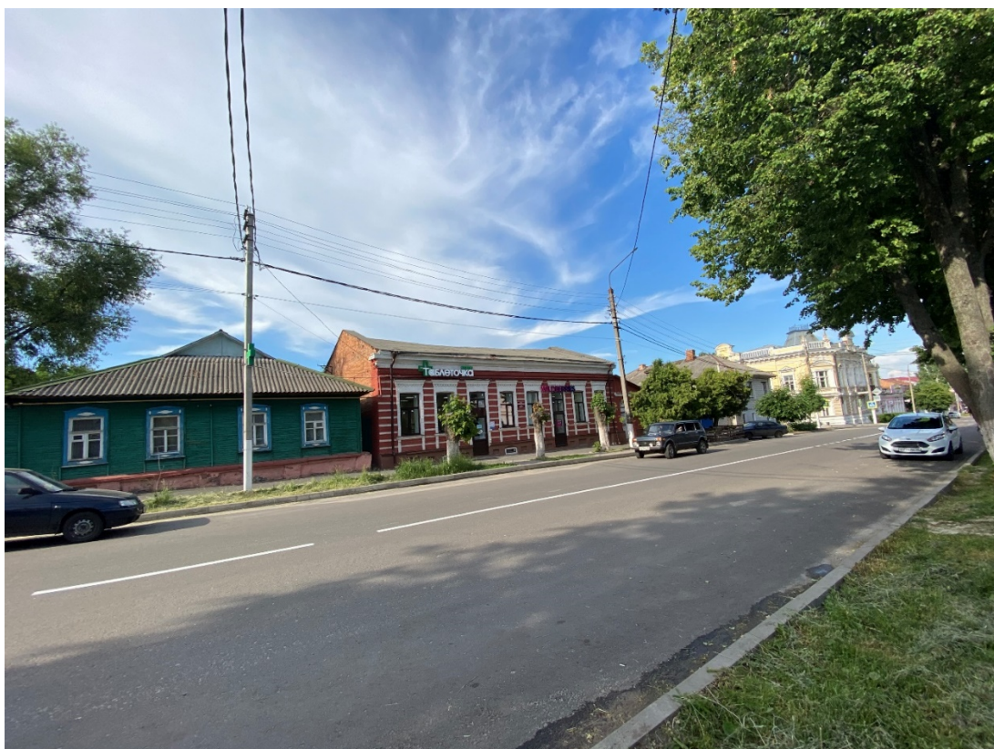
Фотография № 10. Вид с юго-запада на Объект.
