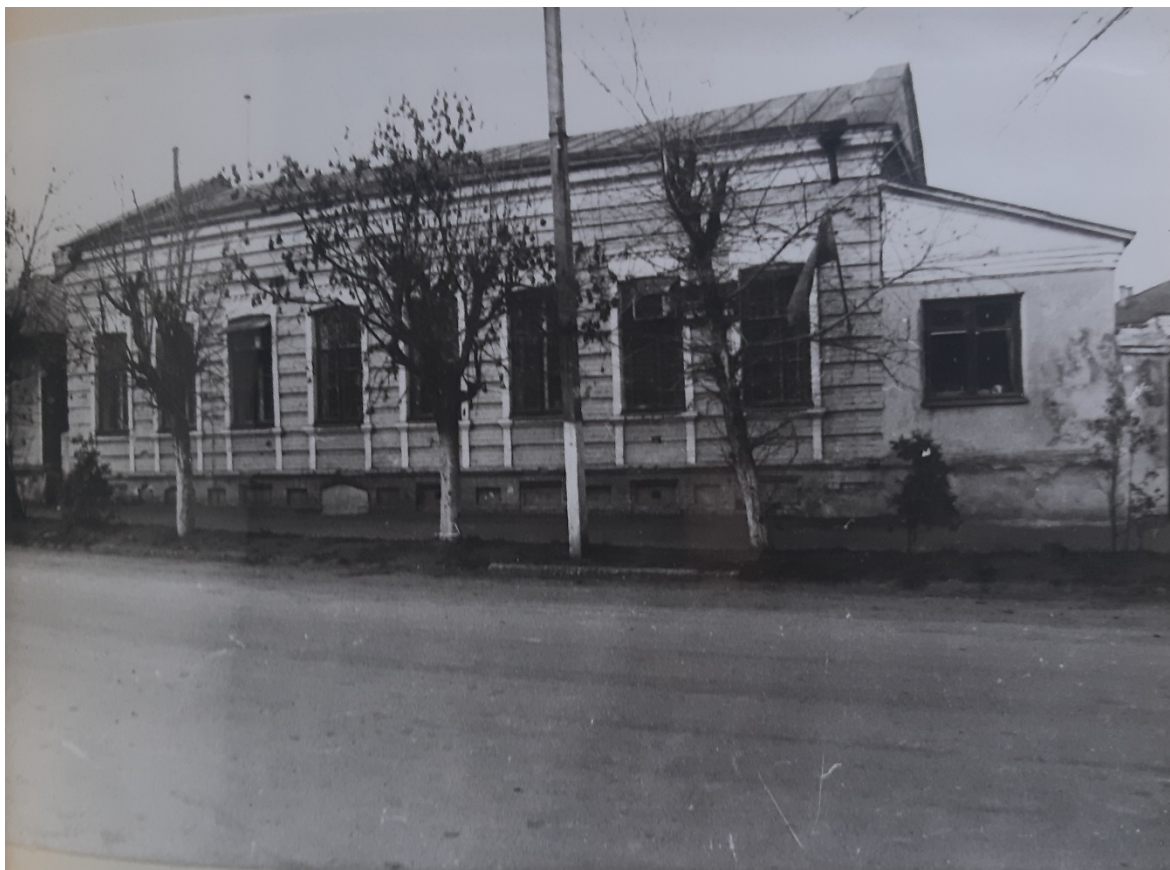
20. Дом по ул. Дзержинского, 34. Здание Объекта на фотографии в «Проекте охранных зон г. Рыльска Курской обл.» 1990 года.
