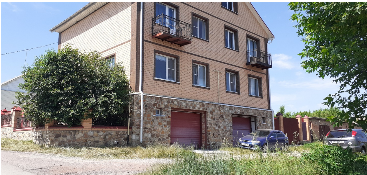
Фотография № 3. Вид с юго-востока на Объект.
