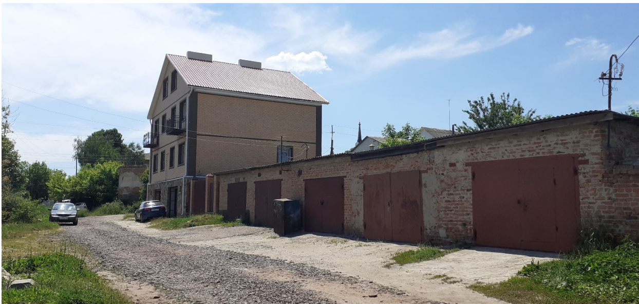
Фотография № 9. Вид с северо-востока на Объект.
