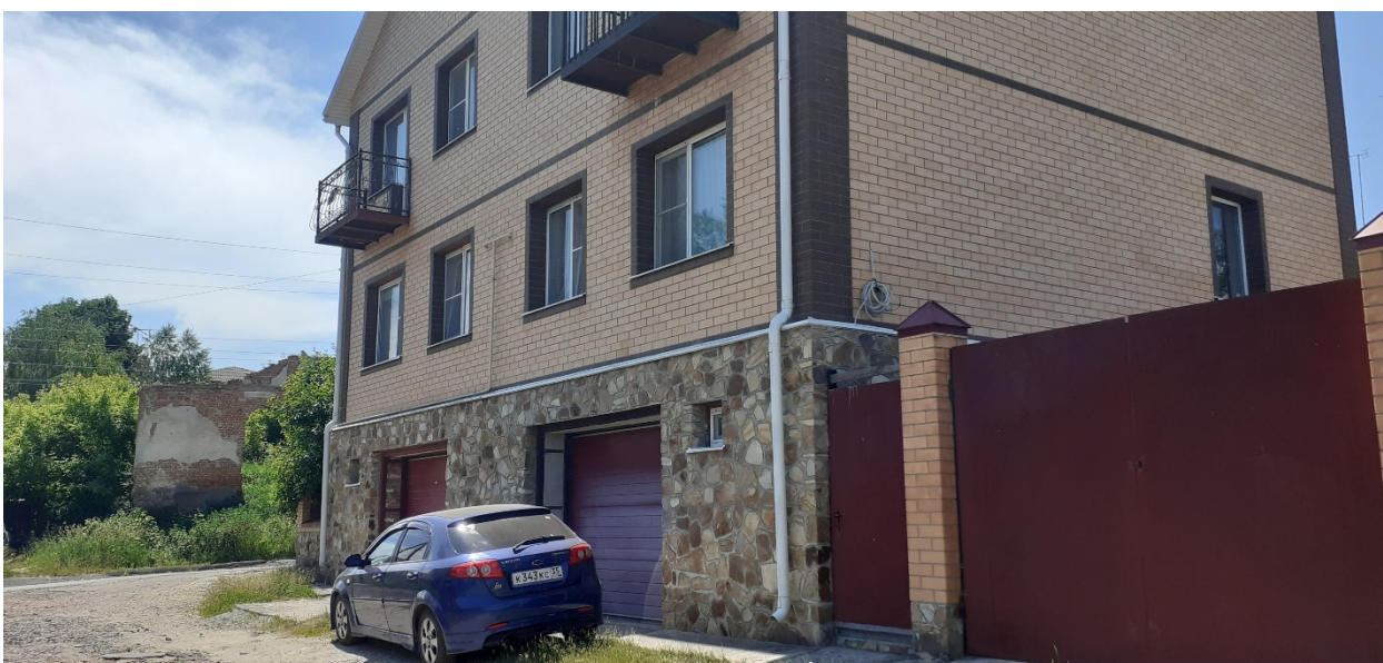
Фотография № 8. Вид с северо-востока на Объект.
