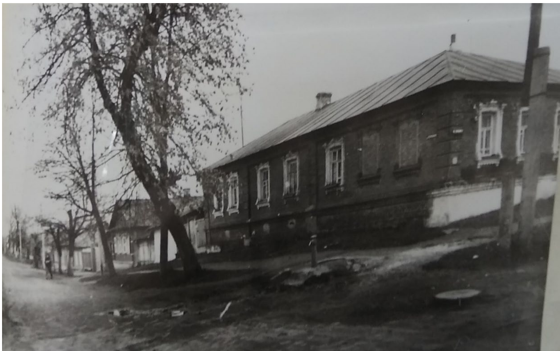
16. Дом по ул. Урицкого, 15.
