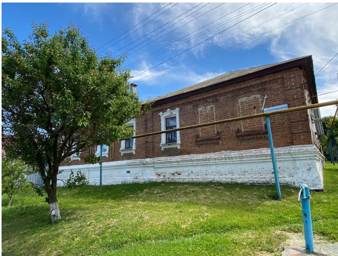
Фотография № 9. Вид с севера на Объект.
