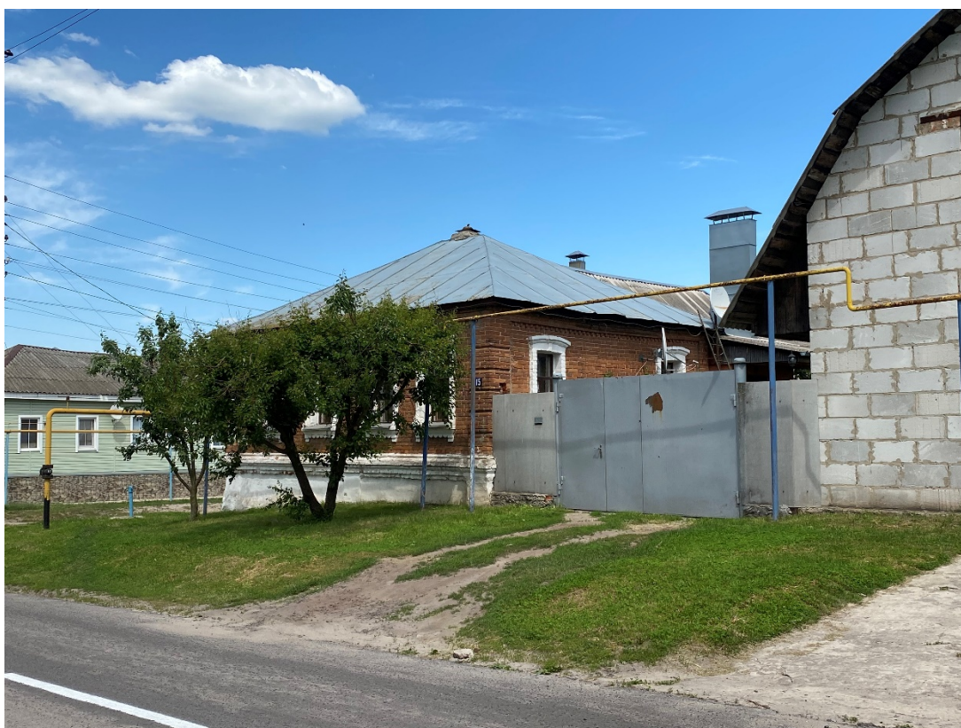
Фотография № 8. Вид с юго-запада на Объект.
