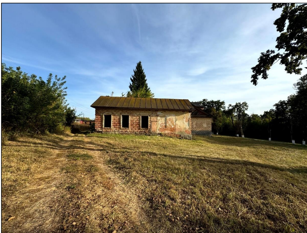
Т.Ф.8. Вид с севера на объект культурного наследия Дом управляющего
