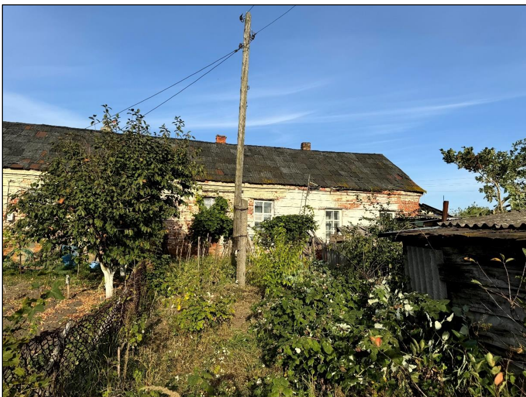
Т.Ф.22. Вид с запада на объект культурного наследия Здание конюшни
