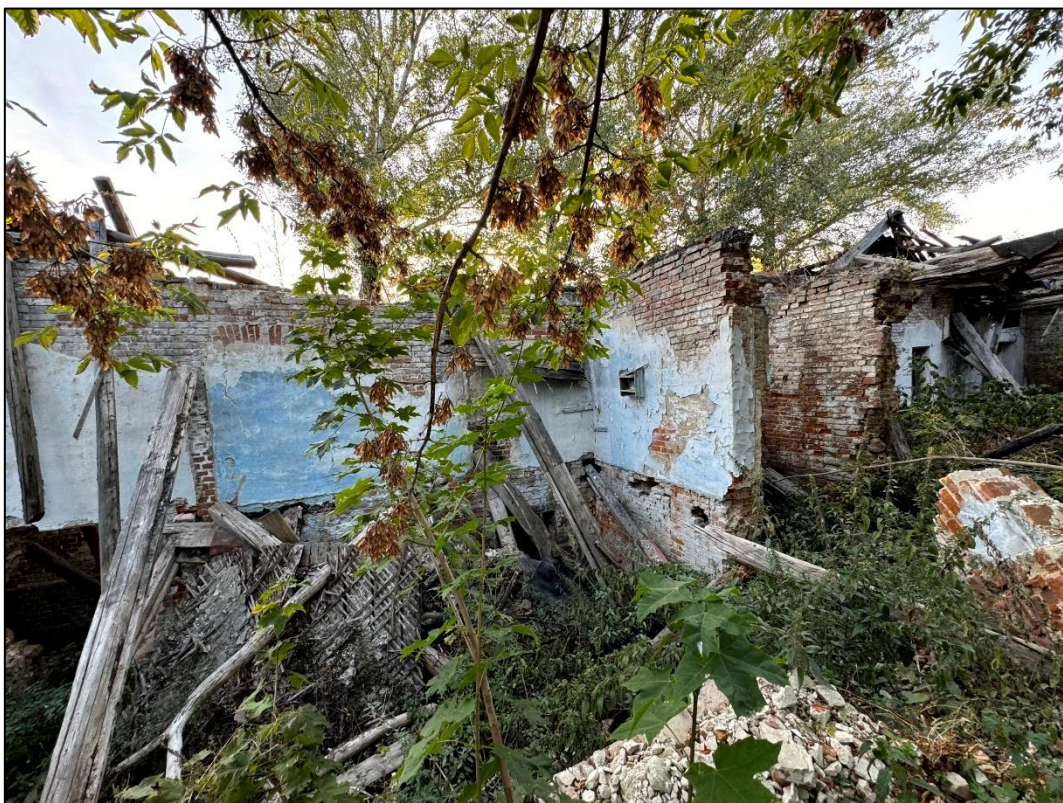
Т.Ф.45. Вид с севера на руины объекта культурного наследия Рабочие казармы
