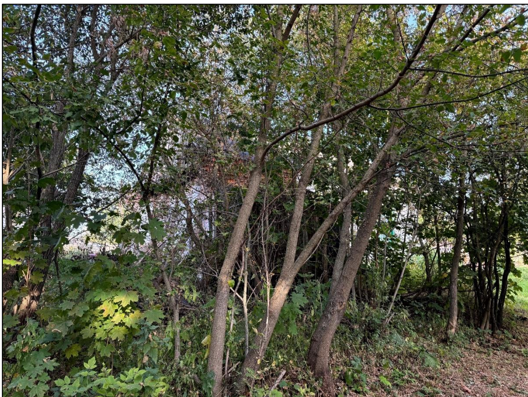
Т.Ф.39. Вид с северо-запада на руины объекта культурного наследия Рабочие казармы
