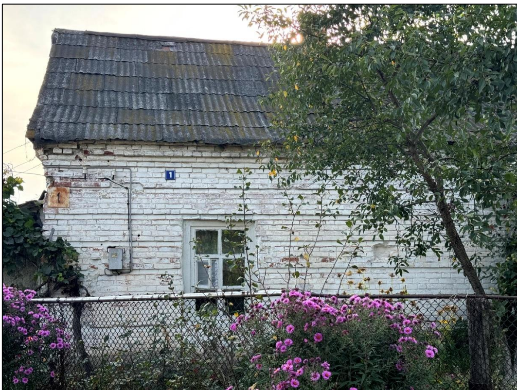
Т.Ф.27. Вид с востока на объект культурного наследия Здание конюшни
