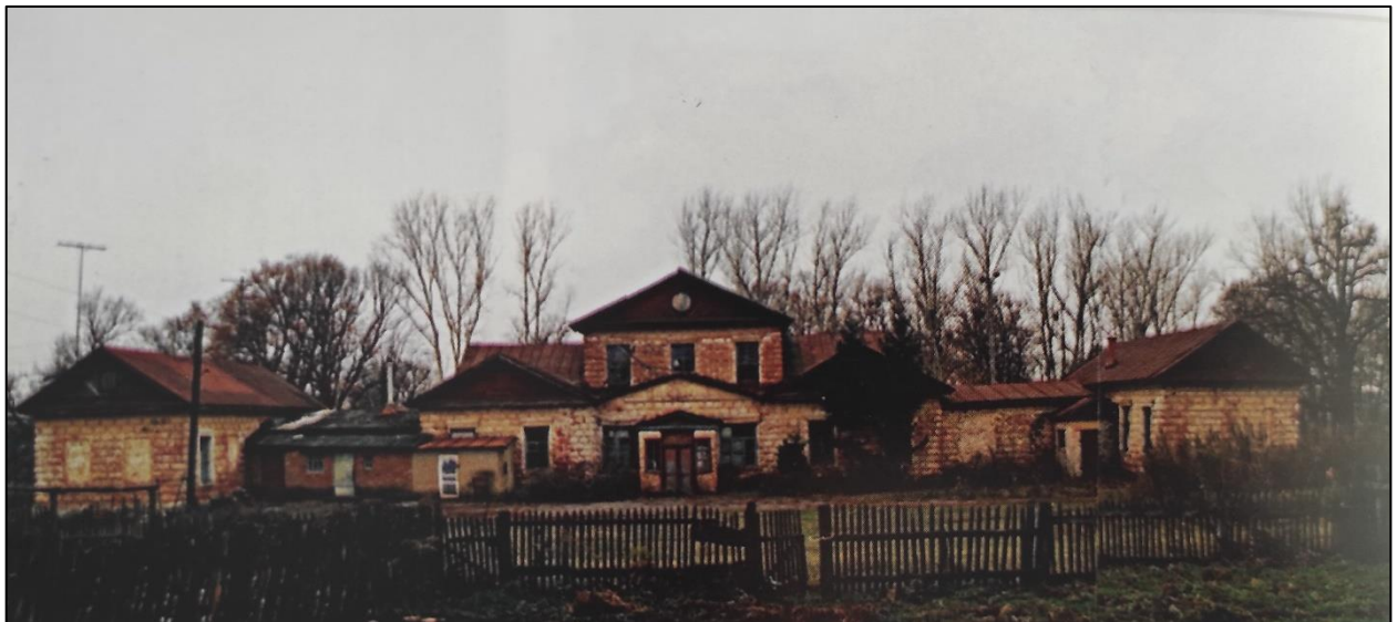
27. Дерюгино. Усадьба Великого князя Михаила Александровича (дом управляющего и флигель; входят в состав Объекта). Фото: Холодова Е.В.
