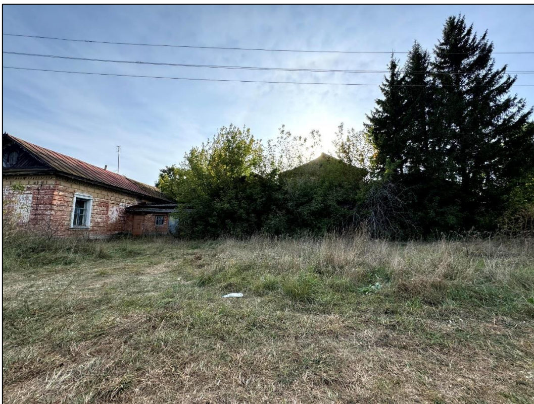
Т.Ф.15. Вид с северо-востока на объект культурного наследия Дом управляющего
