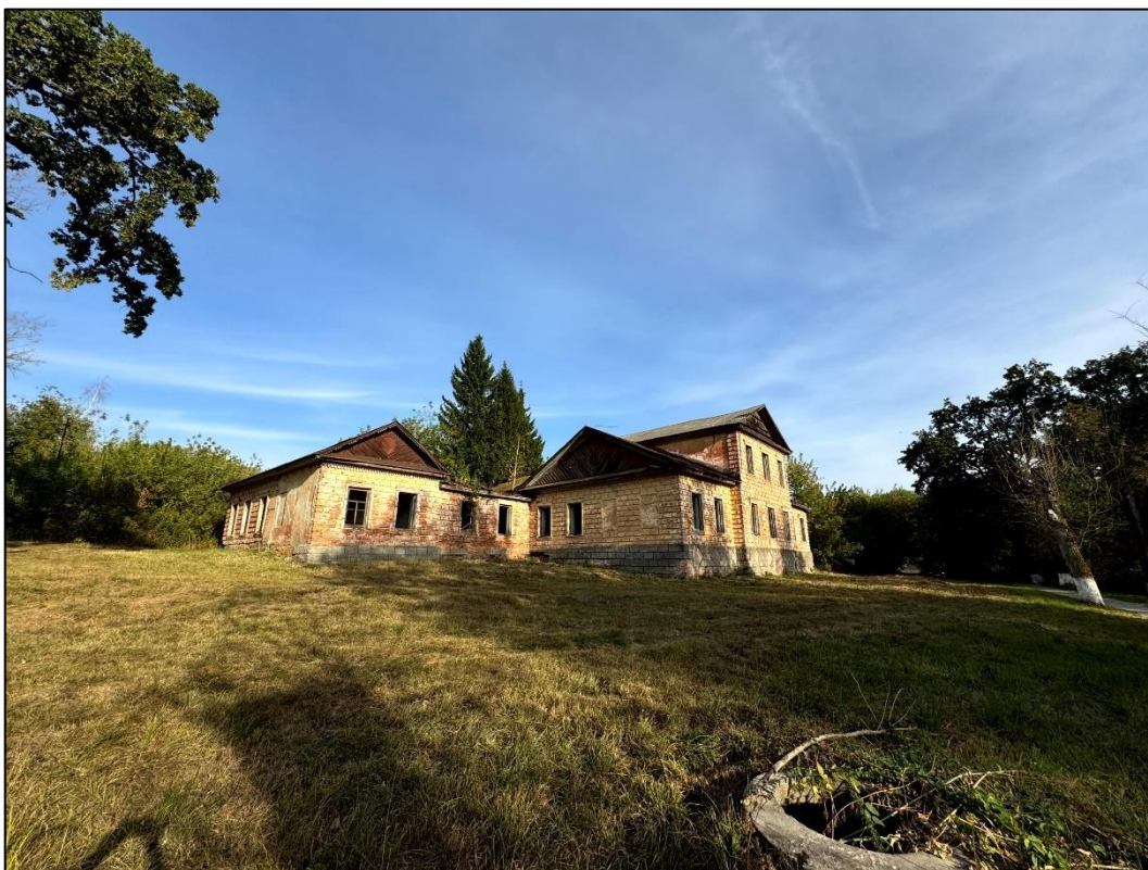
Т.Ф.5. Вид с северо-запада на объект культурного наследия Дом управляющего
