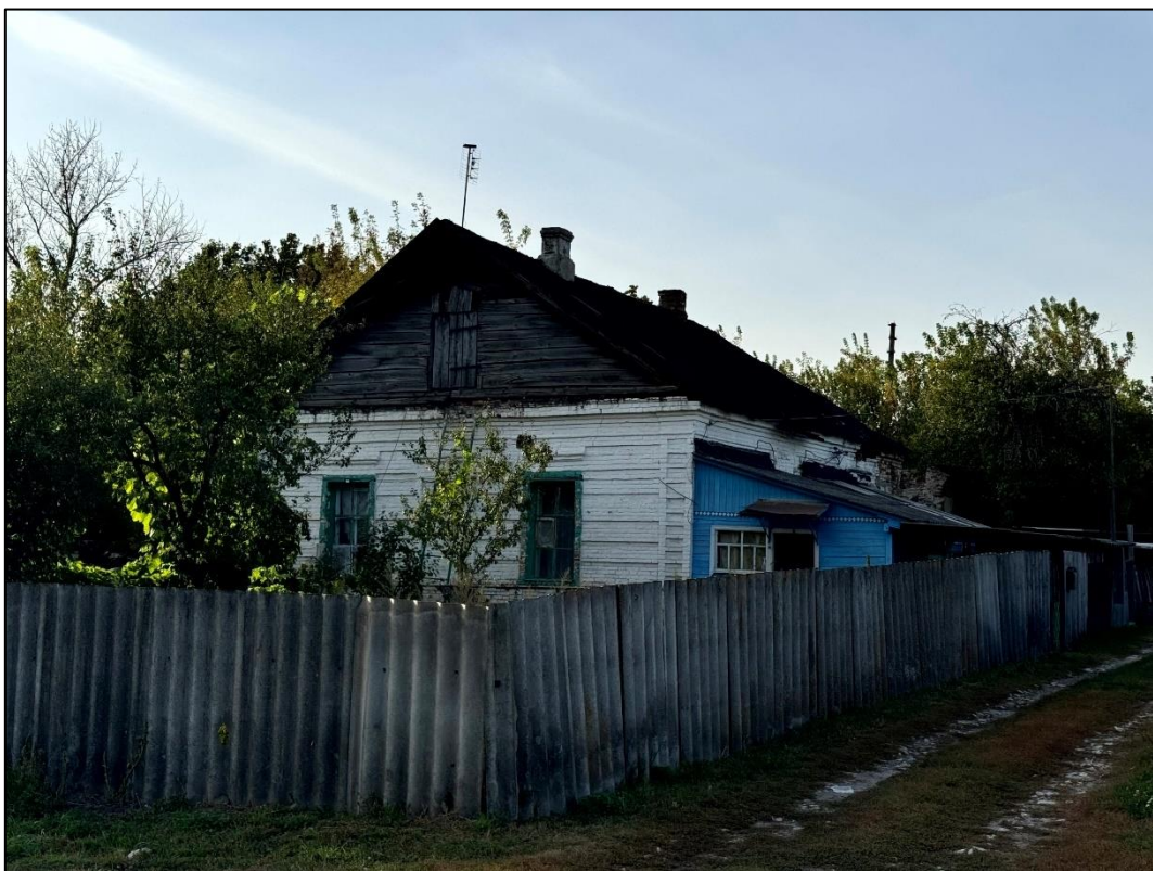
Т.Ф.33. Вид с юго-востока на объект культурного наследия «Флигель»
