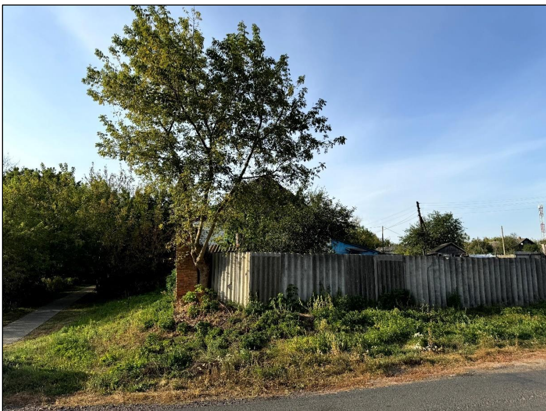
Т.Ф.34. Вид с юго-востока на объект культурного наследия Флигель
