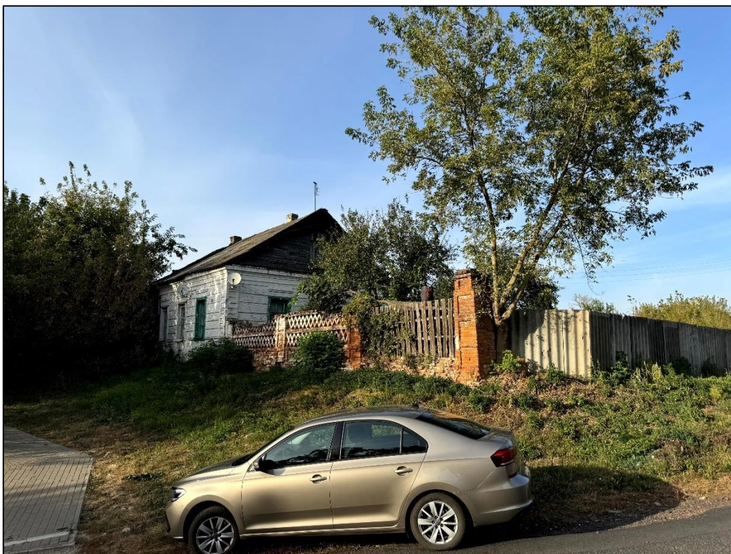
Т.Ф.35. Вид с юга на объект культурного наследия Флигель
