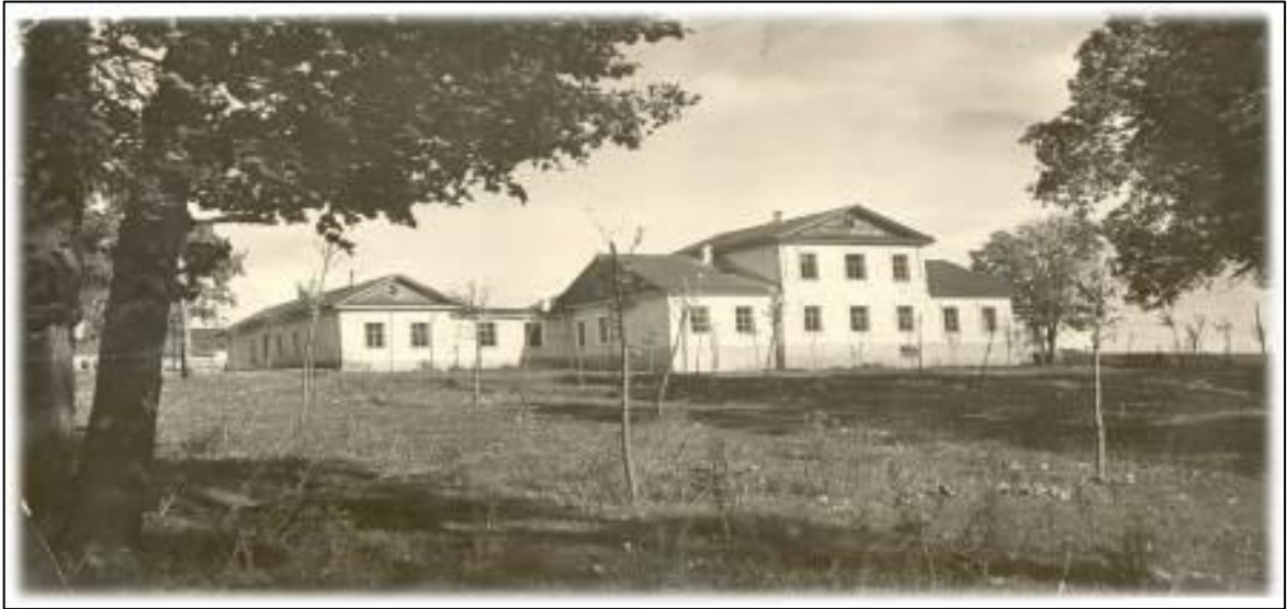
24. Вид на дом управляющего (входит в состав Объекта). Период создания: [XX в.].
