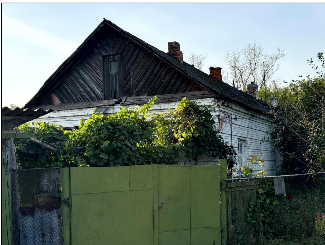
Т.Ф.30. Вид с юго-востока на объект культурного наследия Здание конюшни
