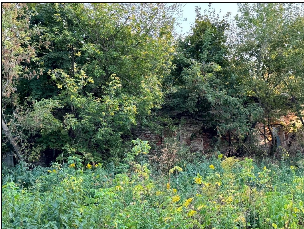
Т.Ф.41. Вид с северо-востока на руины объекта культурного наследия Рабочие казармы
