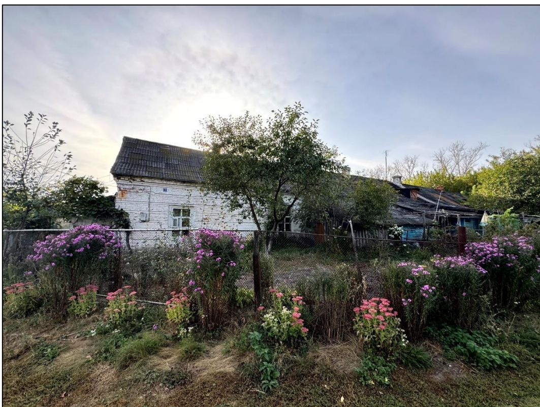
Т.Ф.26. Вид с востока на объект культурного наследия Здание конюшни
