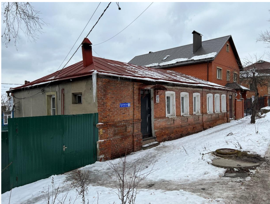
Фотография № 8. Вид с юго-востока на Объект.
