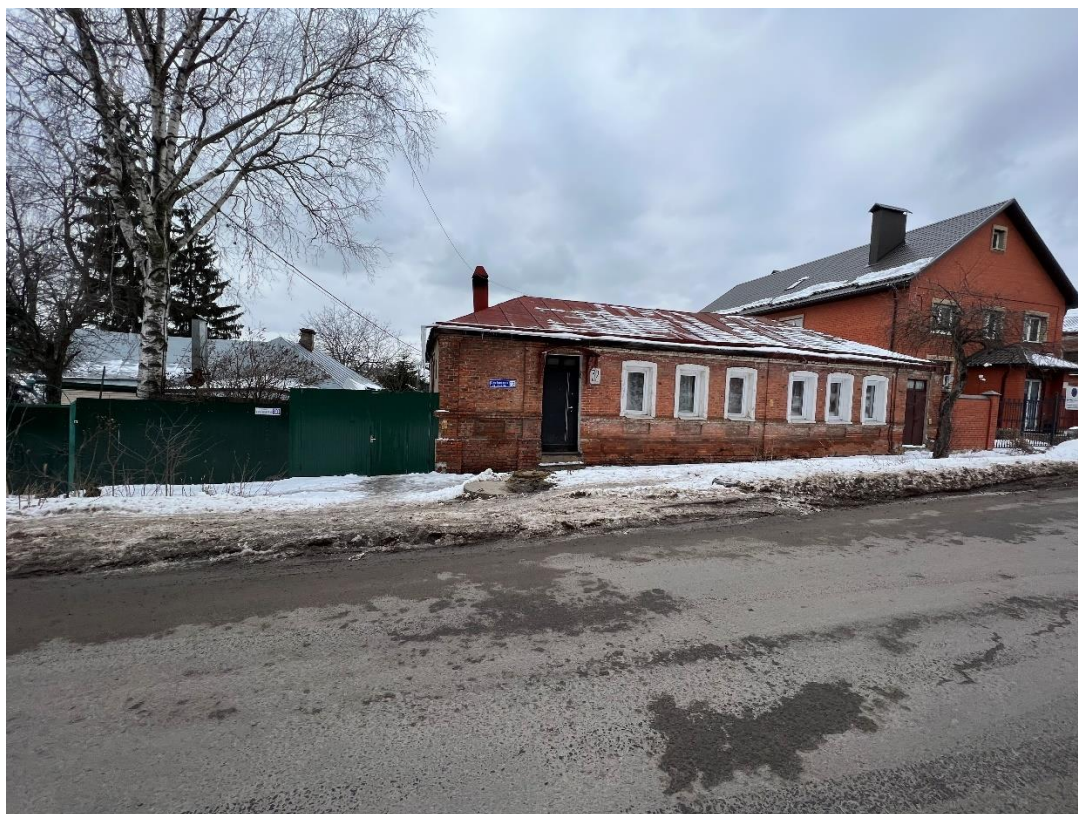
Фотография № 9. Вид с юго-востока на Объект.
