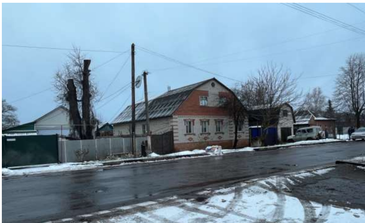
Т.ф. 1. Общий вид Объекта в контексте застройки ул. Комсомольской.
