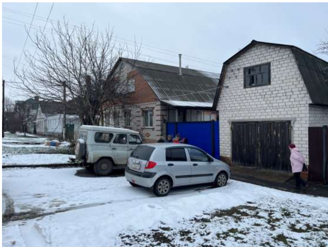
Т.ф. 4. Общий вид Объекта со стороны ул. Комсомольской
