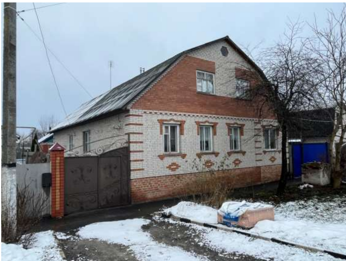
Т.ф. 3. Общий вид Объекта со стороны ул. Комсомольской.
