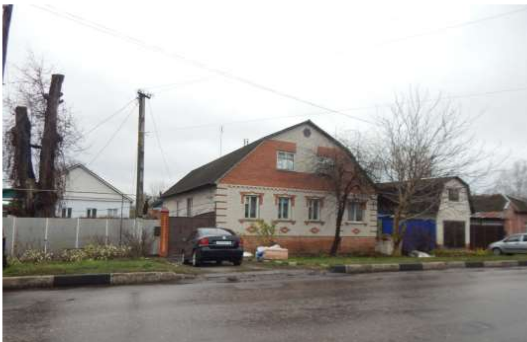
Т.ф. 1. Общий вид Объекта в контексте застройки ул. Комсомольской.
