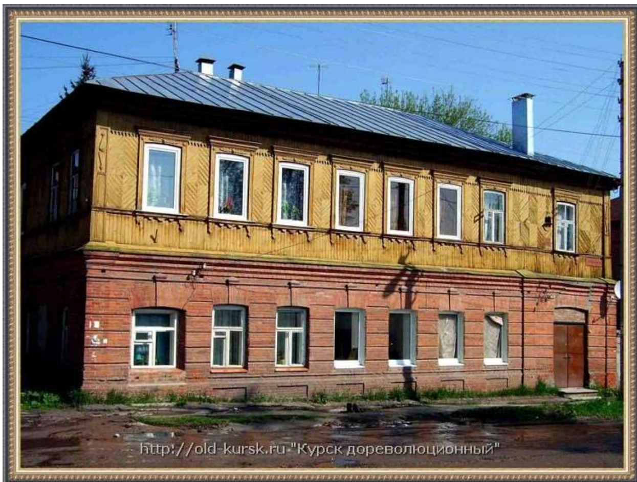
22. Дом наследников мещанина Ф.А. Качурина, ул. Большевиков, №17. Фотограф Ю.В. Озеров. Период создания: начало ХХI в. Источник: http://old-kursk.ru
