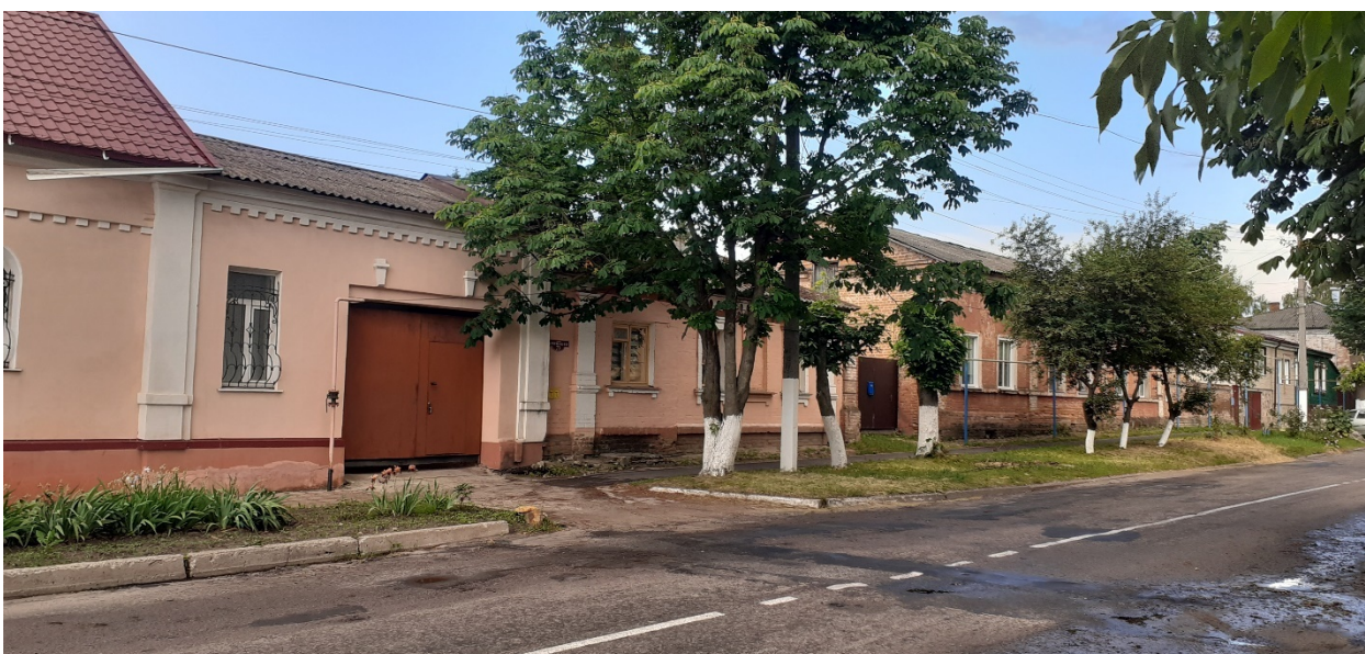
Фотография № 8. Вид с северо-запада на Объект.
