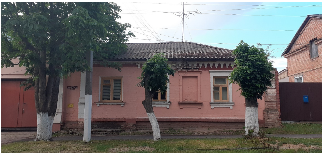
Фотография № 7. Вид с запада на Объект.
