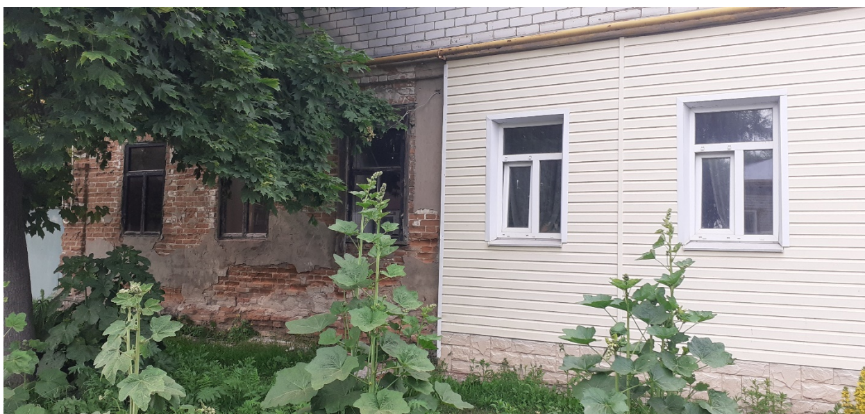
Фотография № 10. Вид с юга на Объект. Центральный фасад. Фрагмент.
