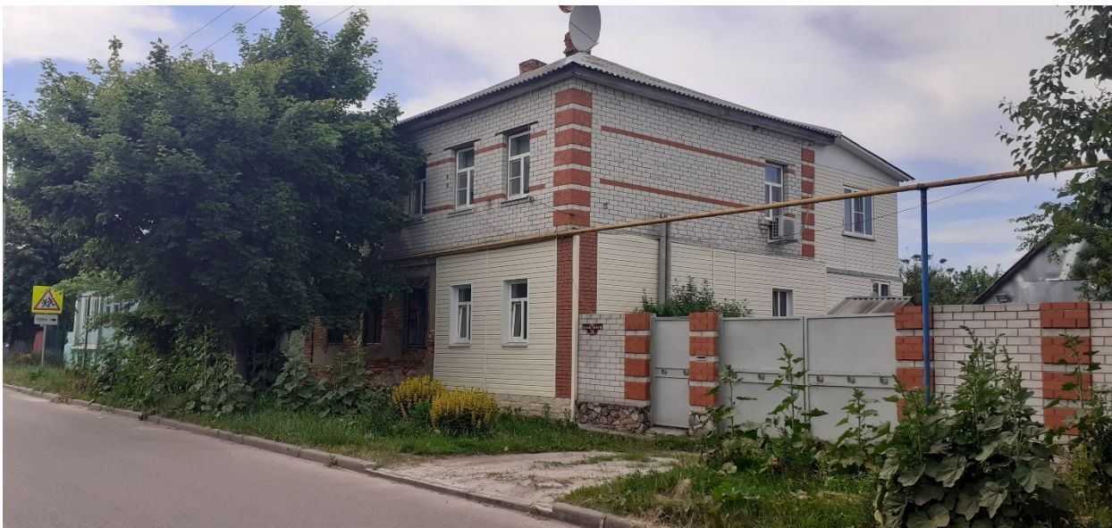
Фотография № 7. Вид с юго-востока на Объект.
