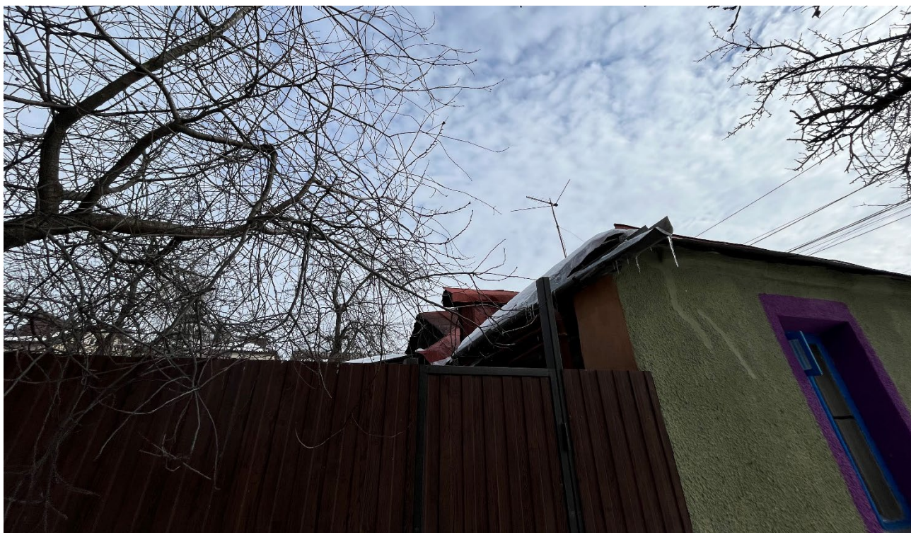
Т.ф. 9. Вид с запада на дворовый северо-западный фасад Объекта
