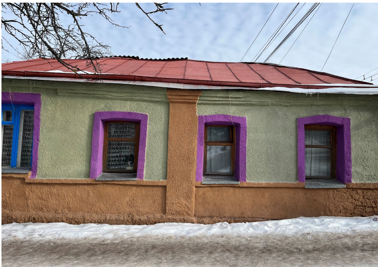
Т.ф. 6. Вид с юго-запада на главный фасад Объекта со стороны ул. Дружининской
