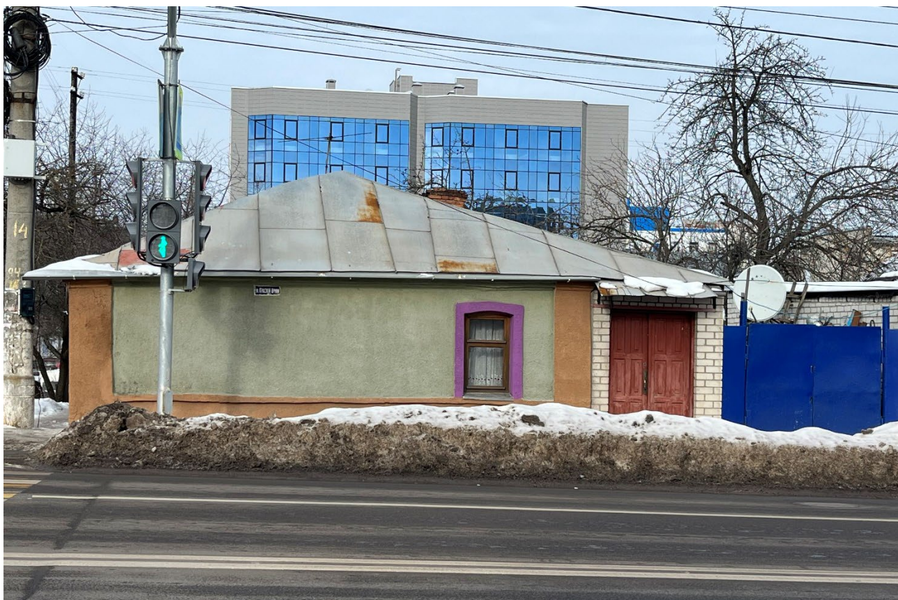
Т.ф. 2. Вид с юго-востока со стороны ул. Красной Армии на главный фасад Объекта
