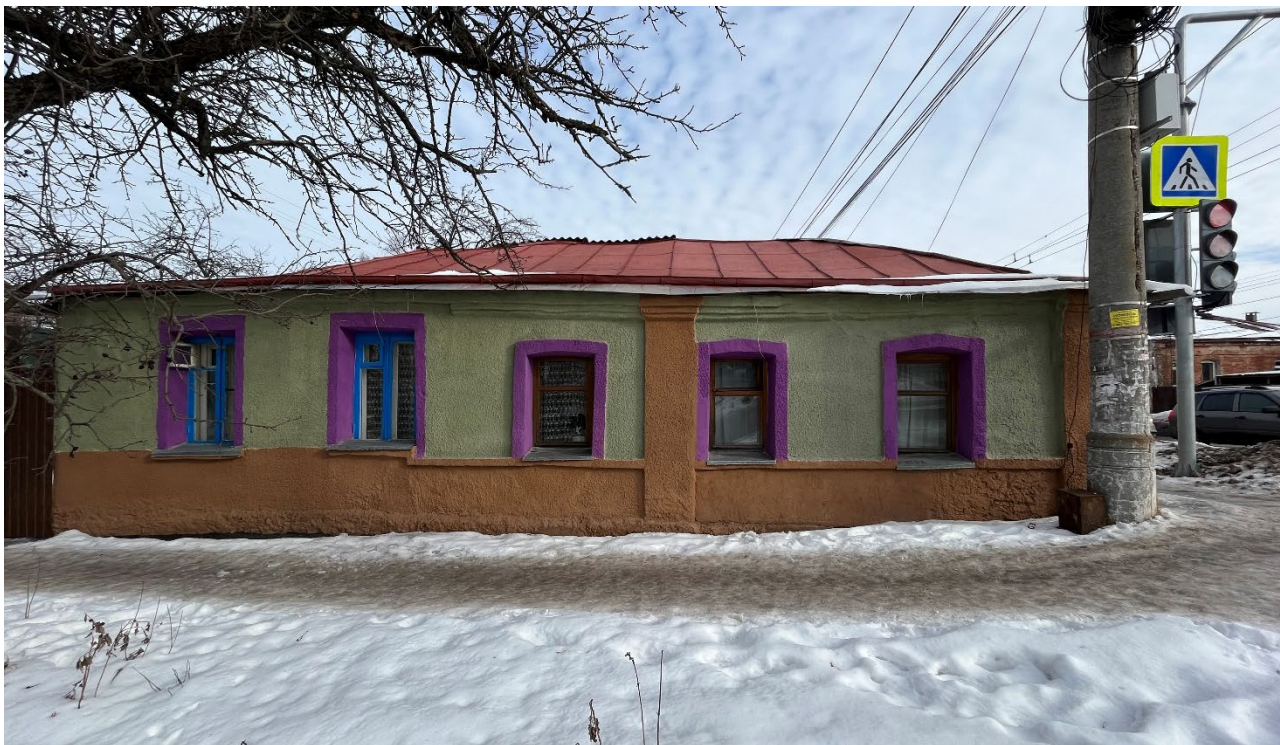
Т.ф. 5. Вид с юго-запада на главный фасад Объекта со стороны ул. Дружининской
