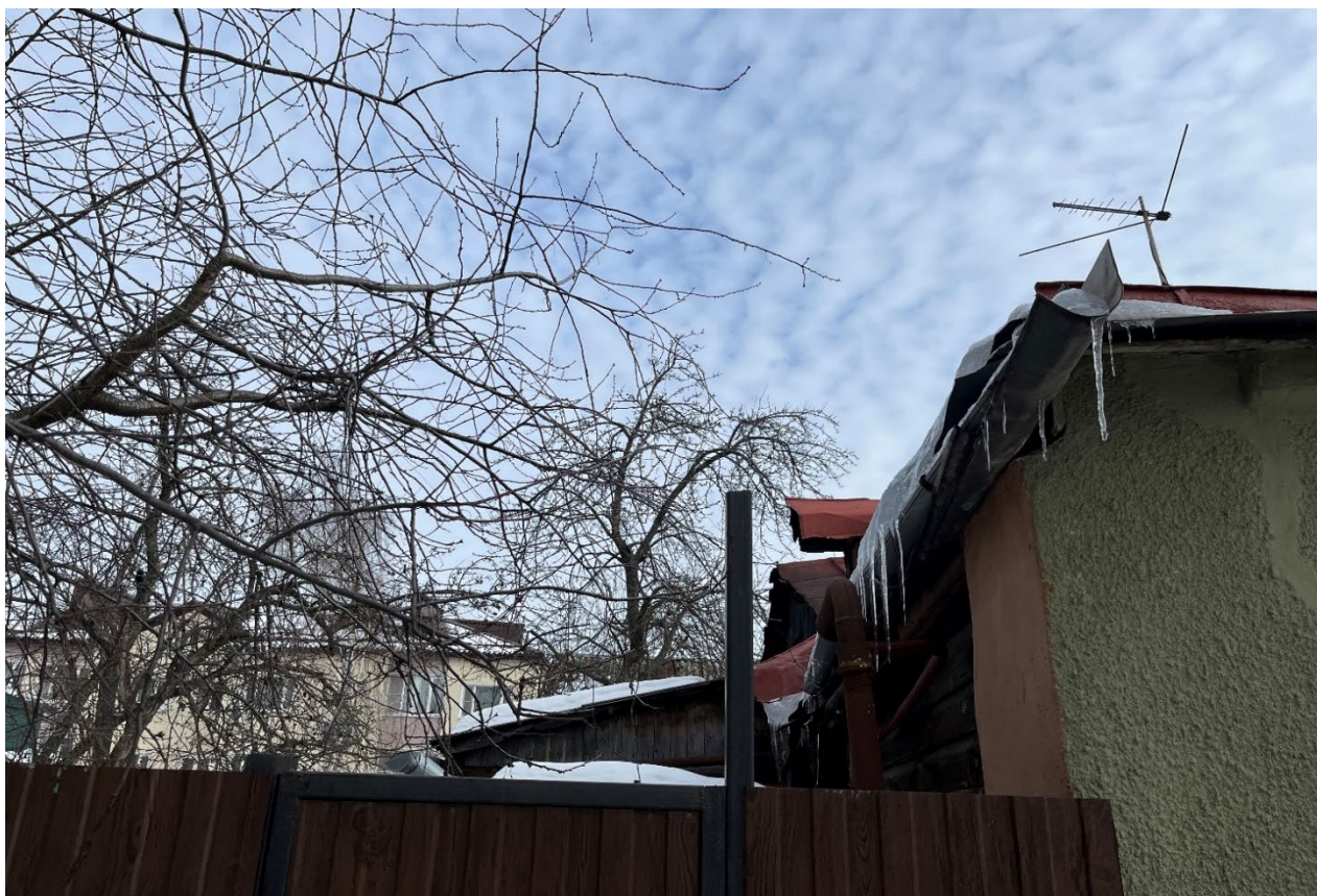
Т.ф. 11. Вид с запада на дворовый северо-западный фасад Объекта
