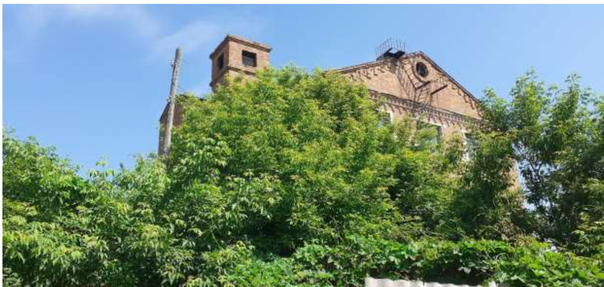
Фотография № 11. Вид с юго-запада на Объект. Южный фасад. Фрагмент.
