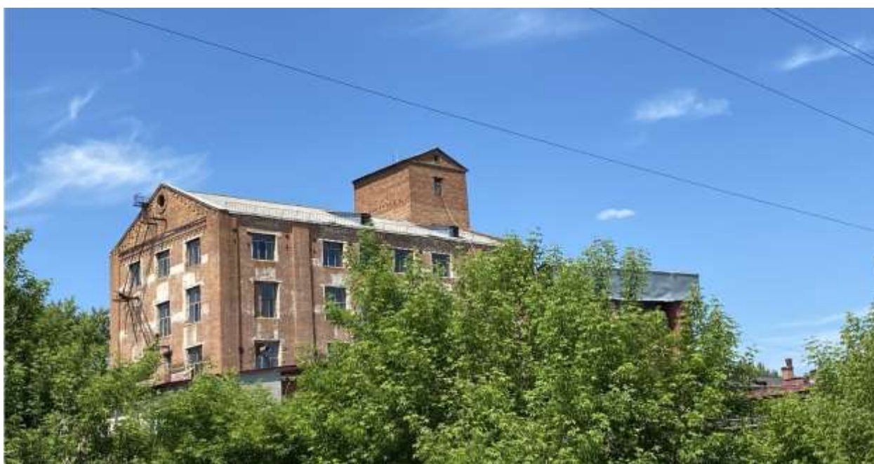
Фотография № 10. Вид с юго-востока на Объект.
