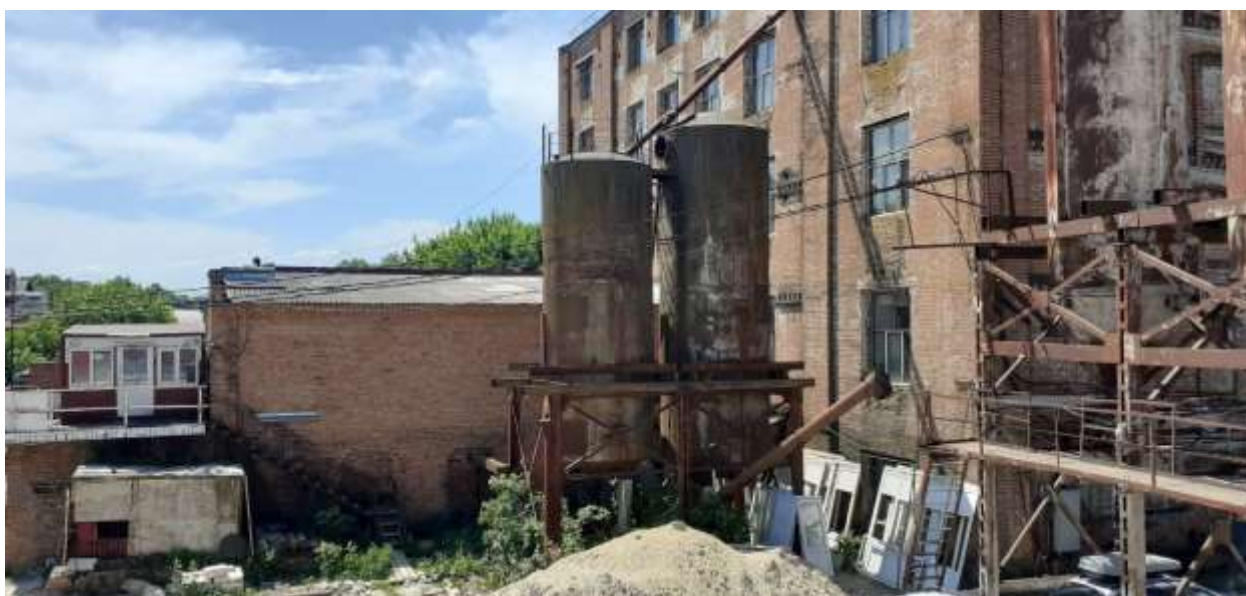
Фотография № 8. Вид с севера на Объект.
