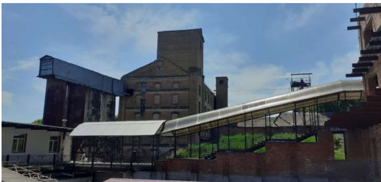
Фотография № 6. Вид с севера на Объект.
