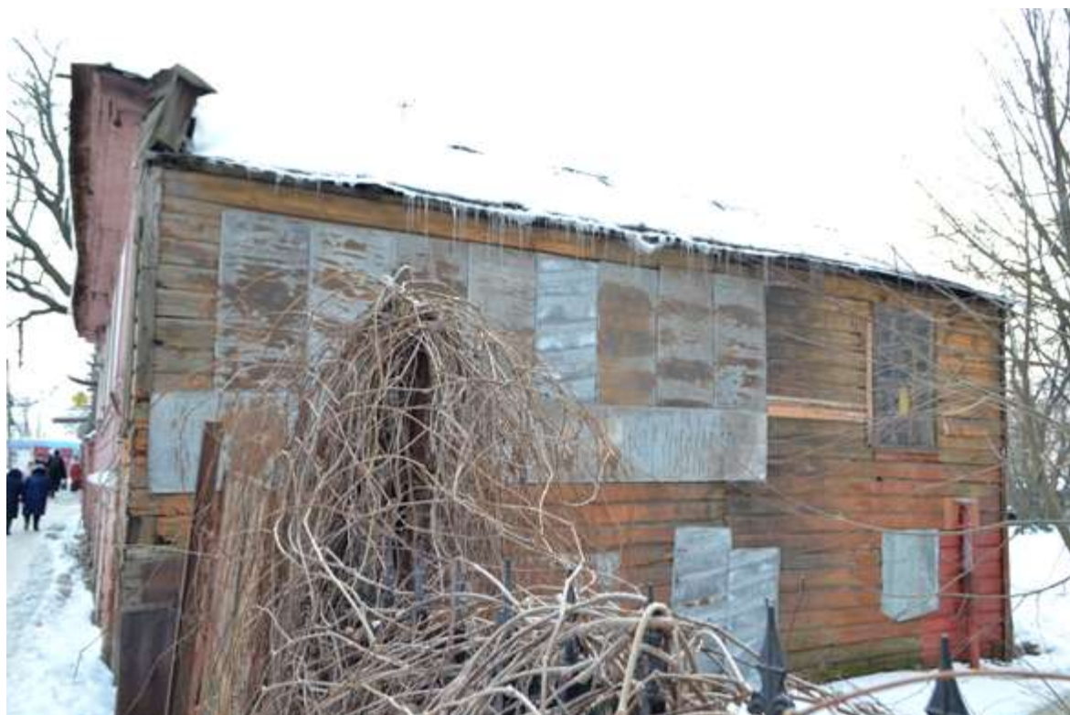
Т.ф. №6. Выявленный объект культурного наследия «Дом жилой», кон. XIX – нач. XX вв. (Курская область, г. Курск, ул. Садовая, д. 30). Западный фасад.
