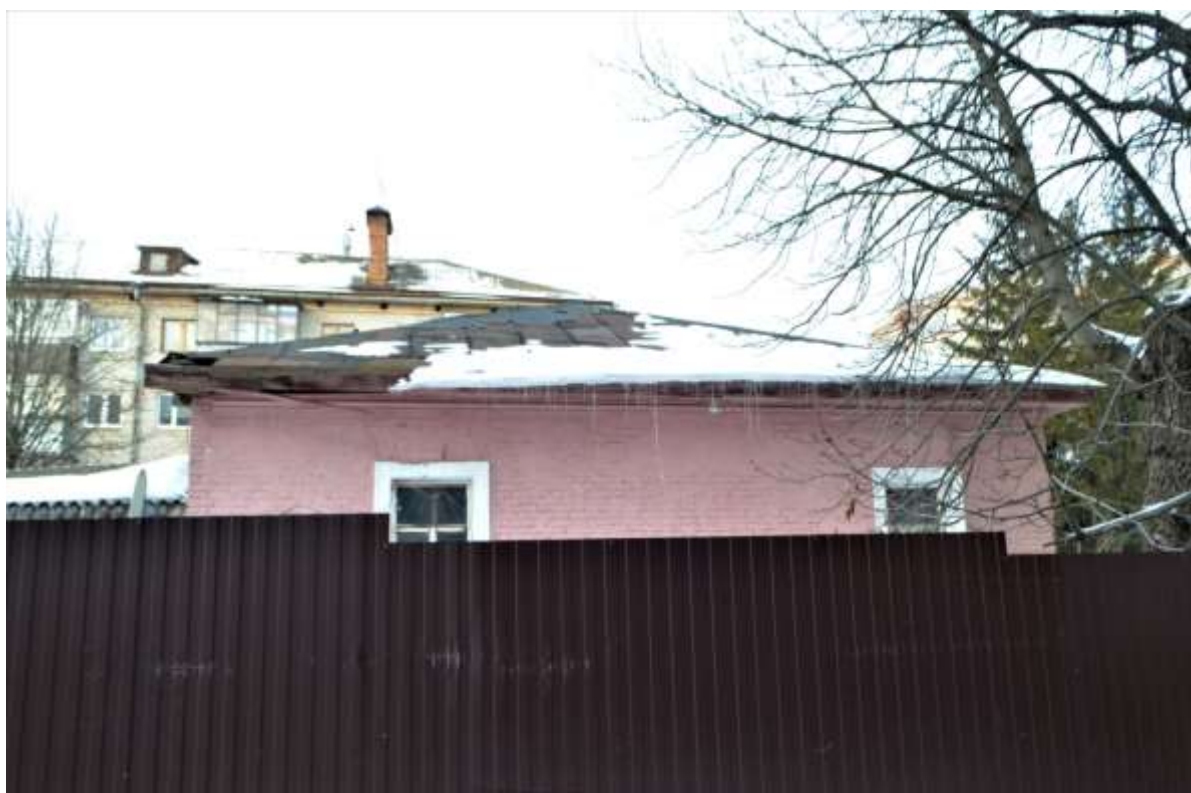
Т.ф. №4. Выявленный объект культурного наследия «Дом жилой», кон. XIX – нач. XX вв. (Курская область, г. Курск, ул. Садовая, д. 30). Восточный фасад. Фрагмент.
