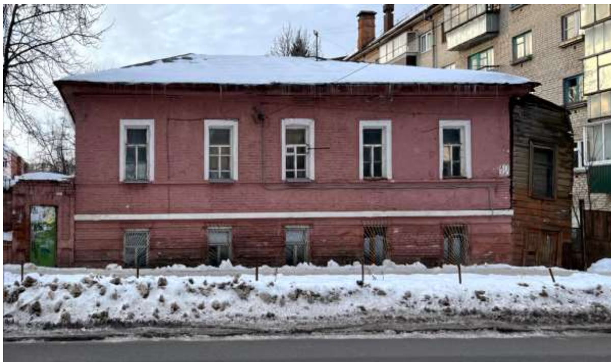
Т.ф. №3. Выявленный объект культурного наследия «Дом жилой», кон. XIX – нач. XX вв. (Курская область, г. Курск, ул. Садовая, д. 30). Северный фасад.
