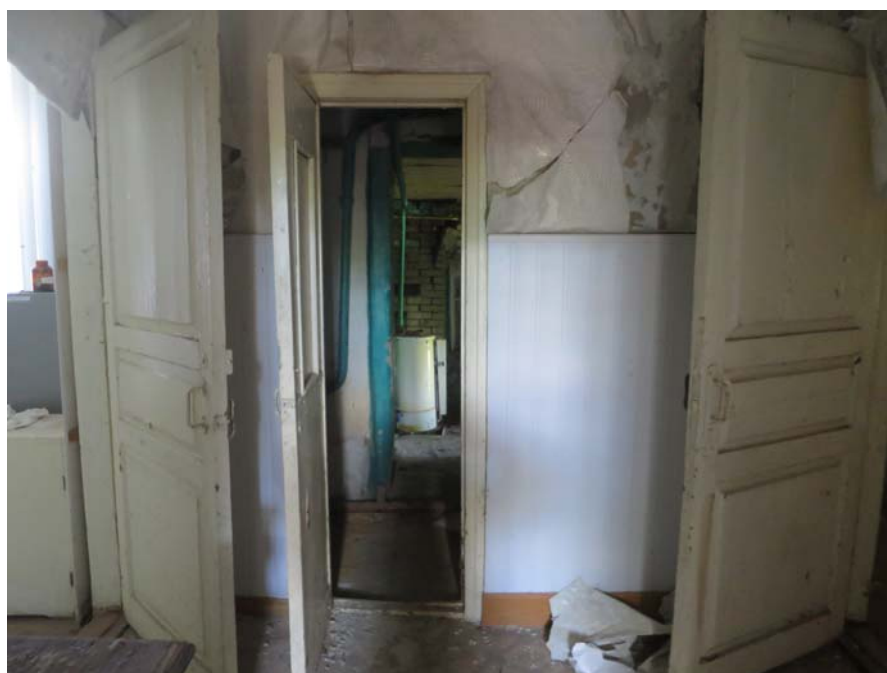
5. Характер коридора в центре здания.
