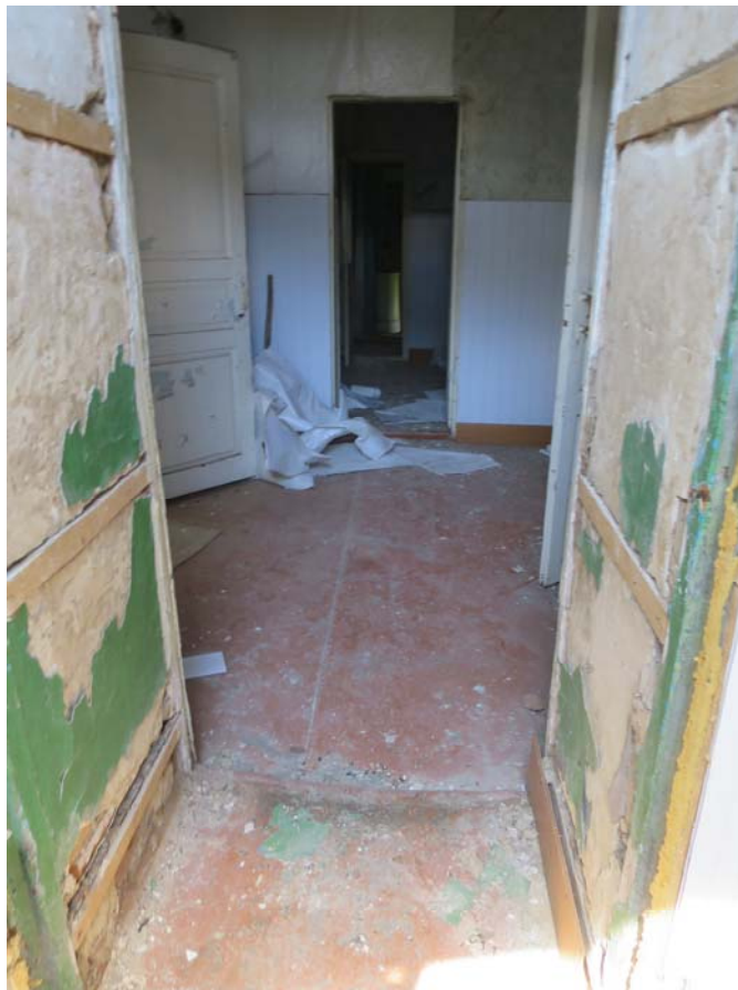
4. Характер коридора в центре здания.
