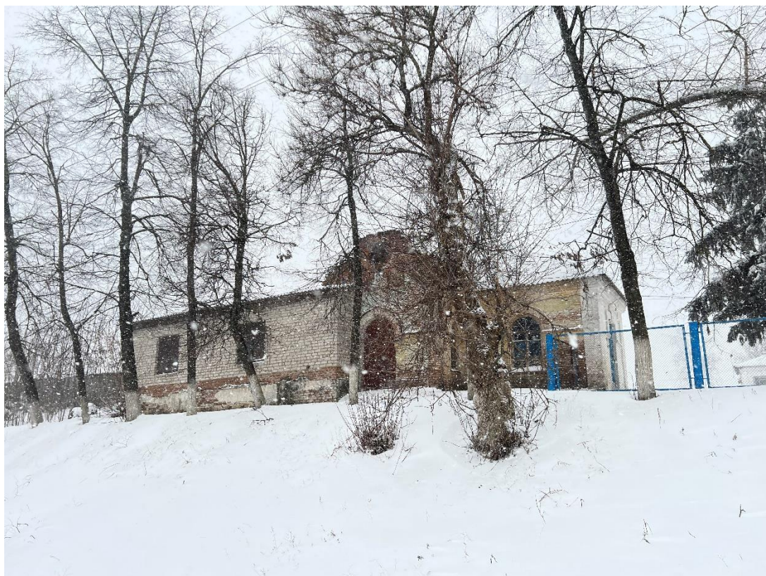
Фотография № 4. Вид с северо-востока на Объект.
