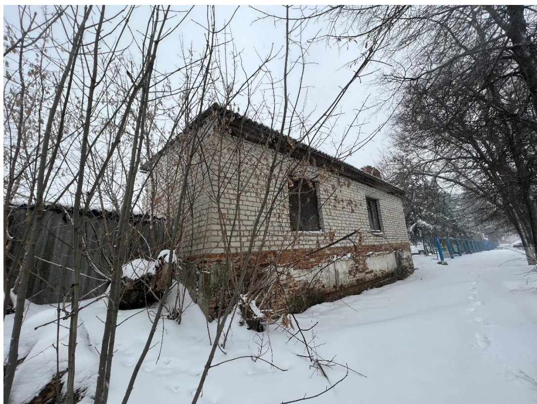
Фотография № 8. Вид с юго-востока на Объект.
