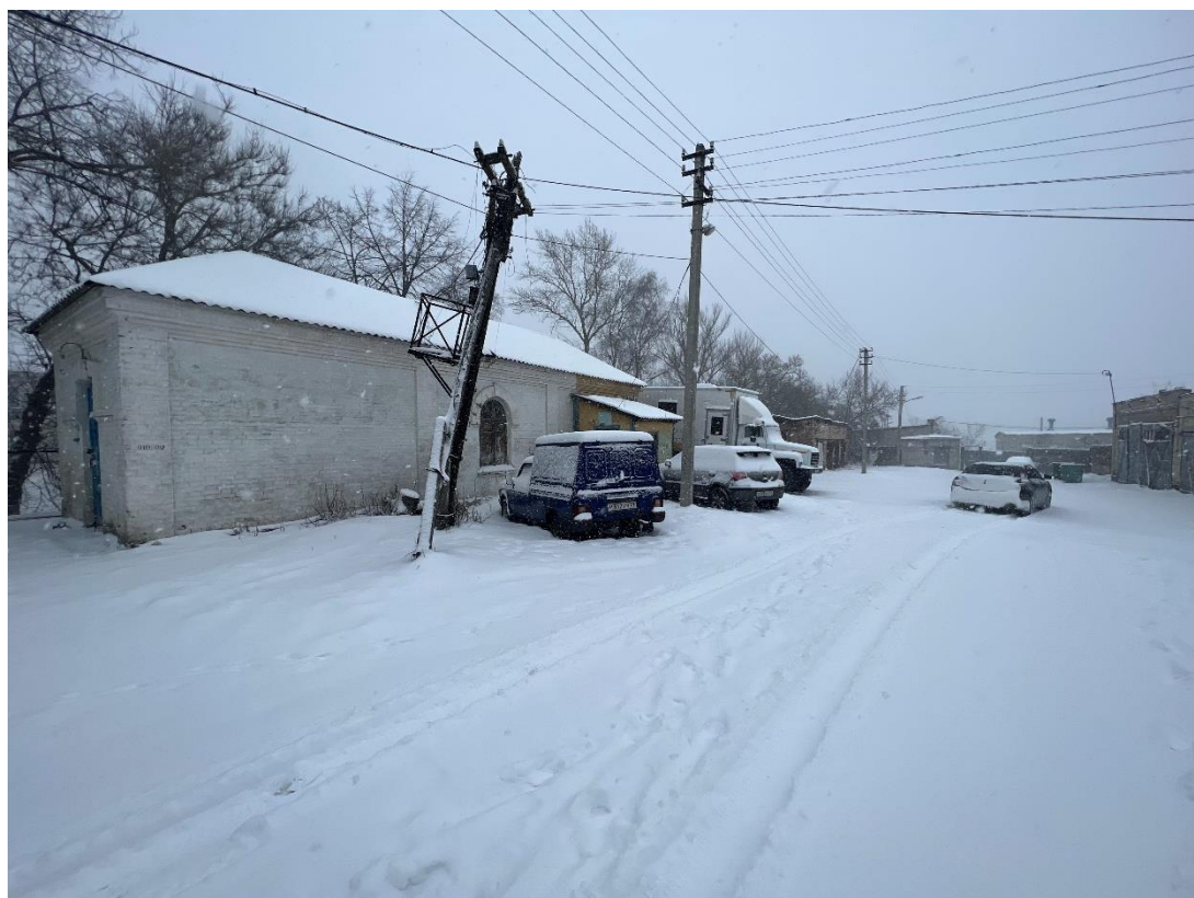
Фотография № 12. Вид с северо-запада на Объект.
