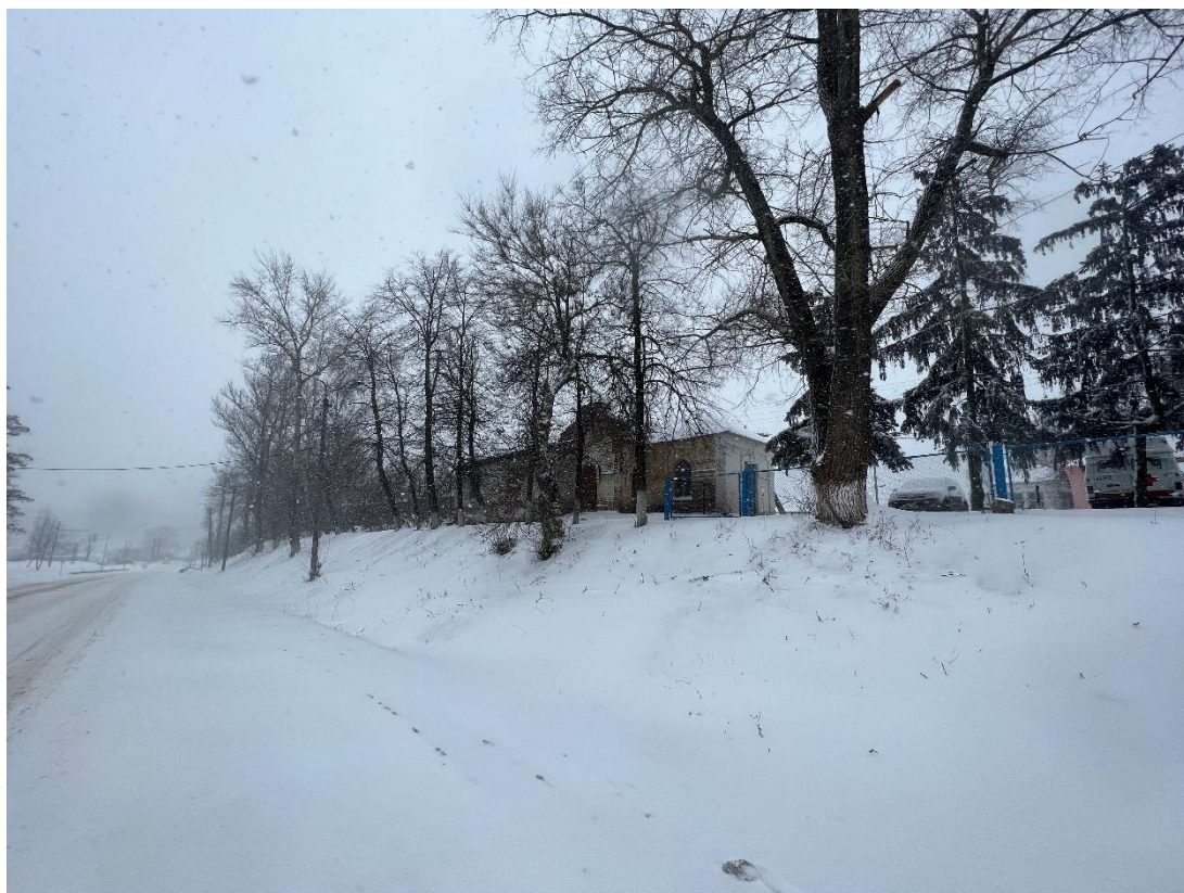
Фотография № 1. Вид с северо-востока на Объект.
