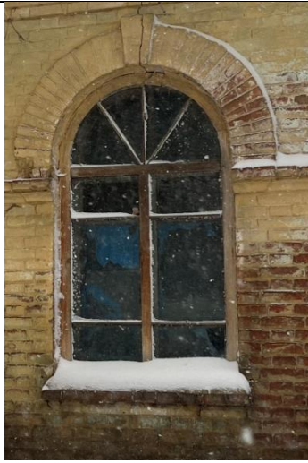
Оконное заполнение (восточный фасад)
