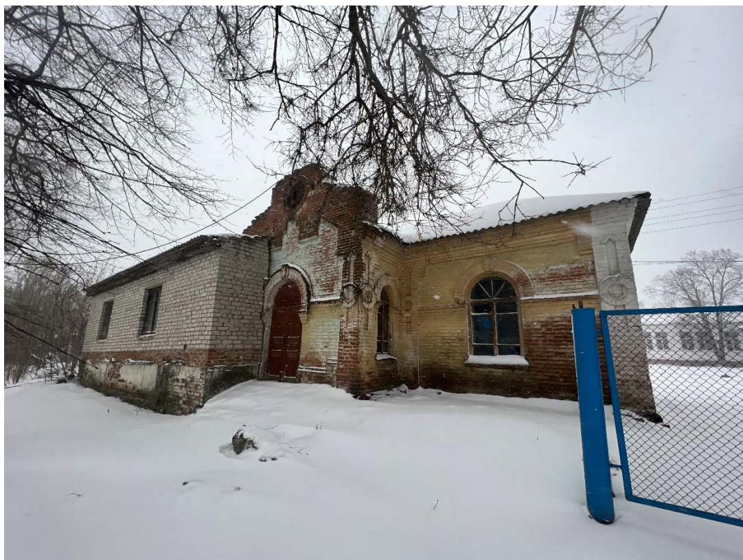
Фотография № 5. Вид с северо-востока на Объект.
