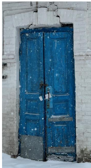
Оконное заполнение (северный фасад)
