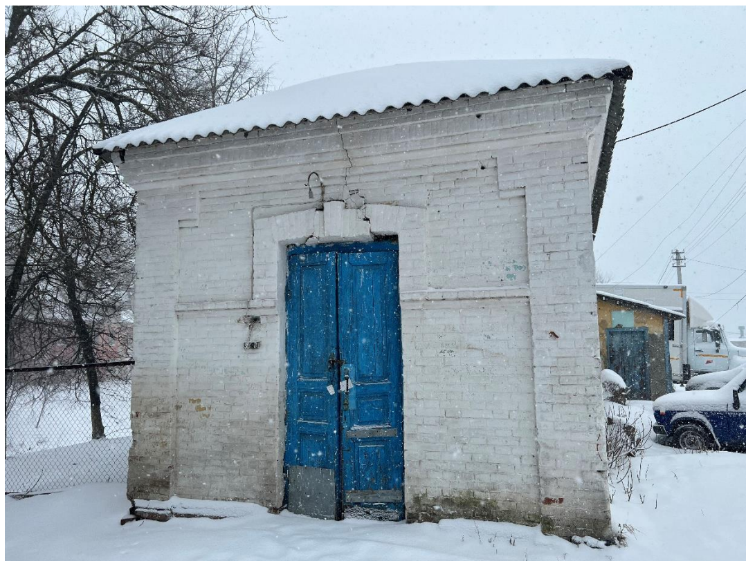
Фотография № 14. Вид с северо-запада на Объект.
