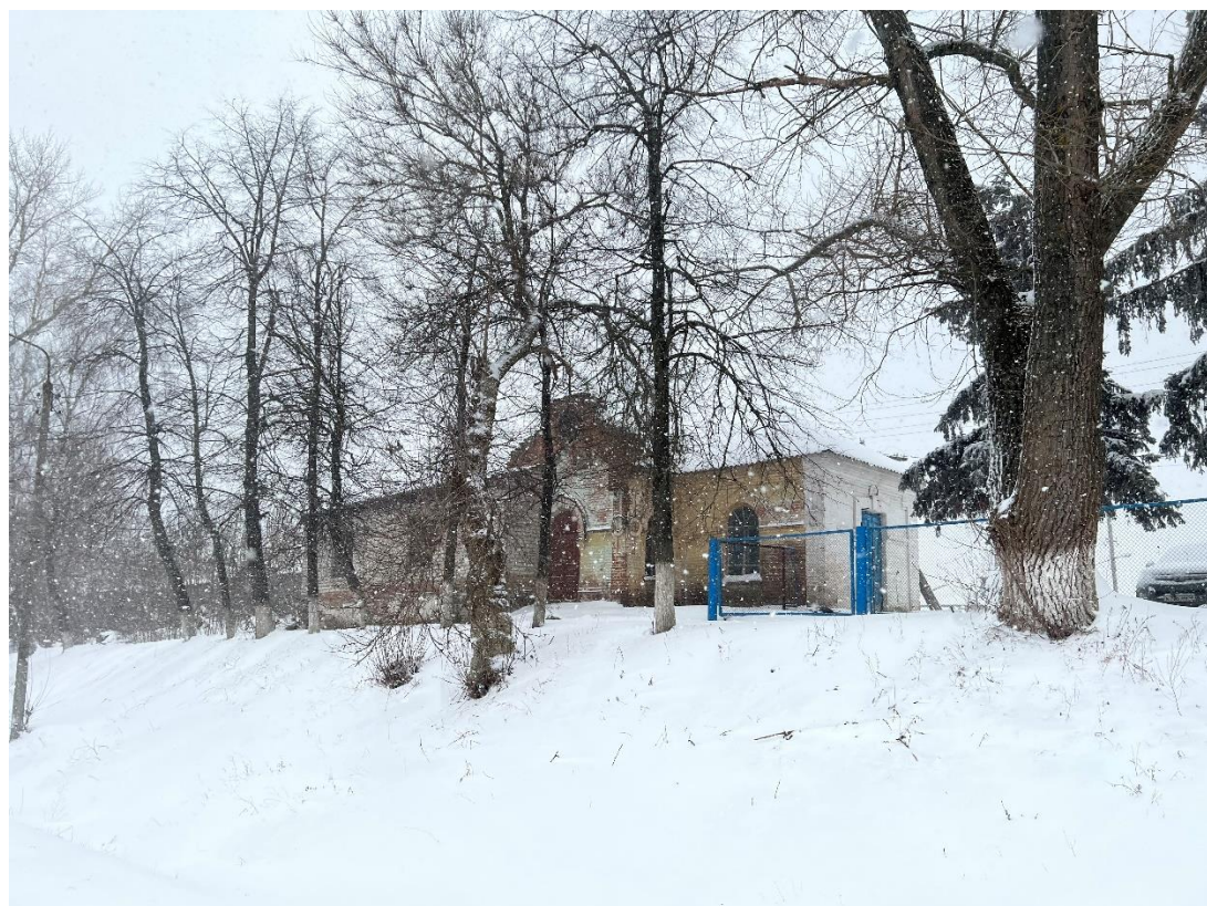
Фотография № 2. Вид с северо-востока на Объект.
