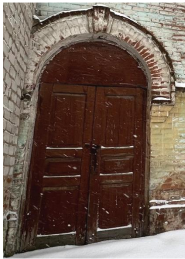
Дверное заполнение (восточный фасад)
