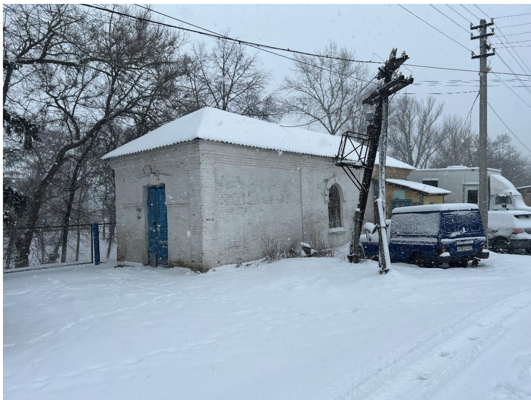
Фотография № 13. Вид с северо-запада на Объект.
