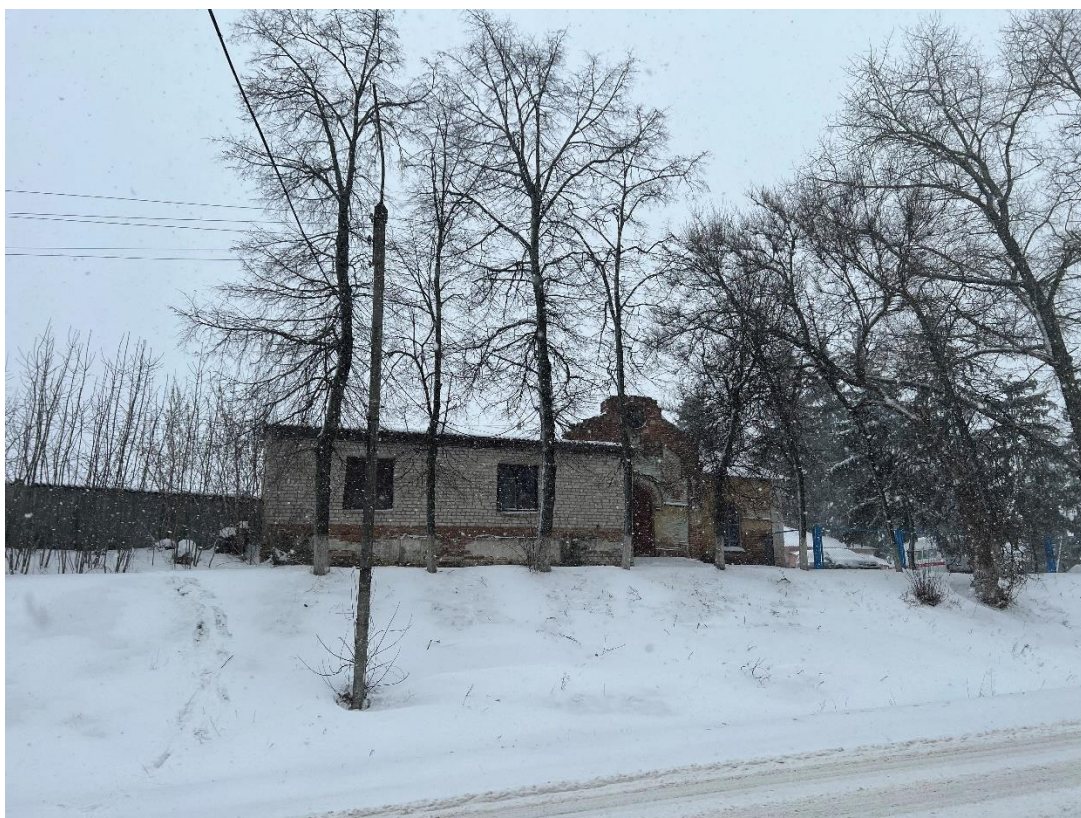
Фотография № 6. Вид с востока на Объект.
