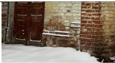
Цоколь. Восточный фасад
