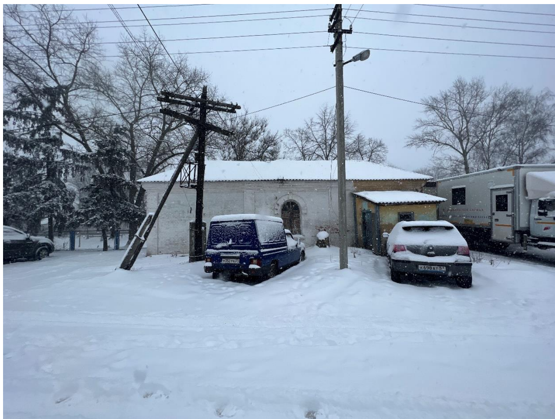
Фотография № 11. Вид с запада на Объект.
