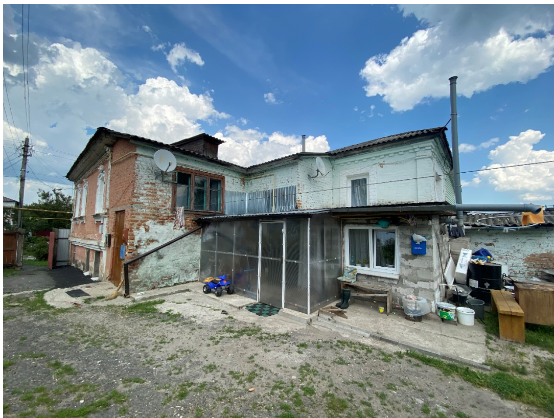
Фотография № 5. Вид с юго-запада на Объект.
