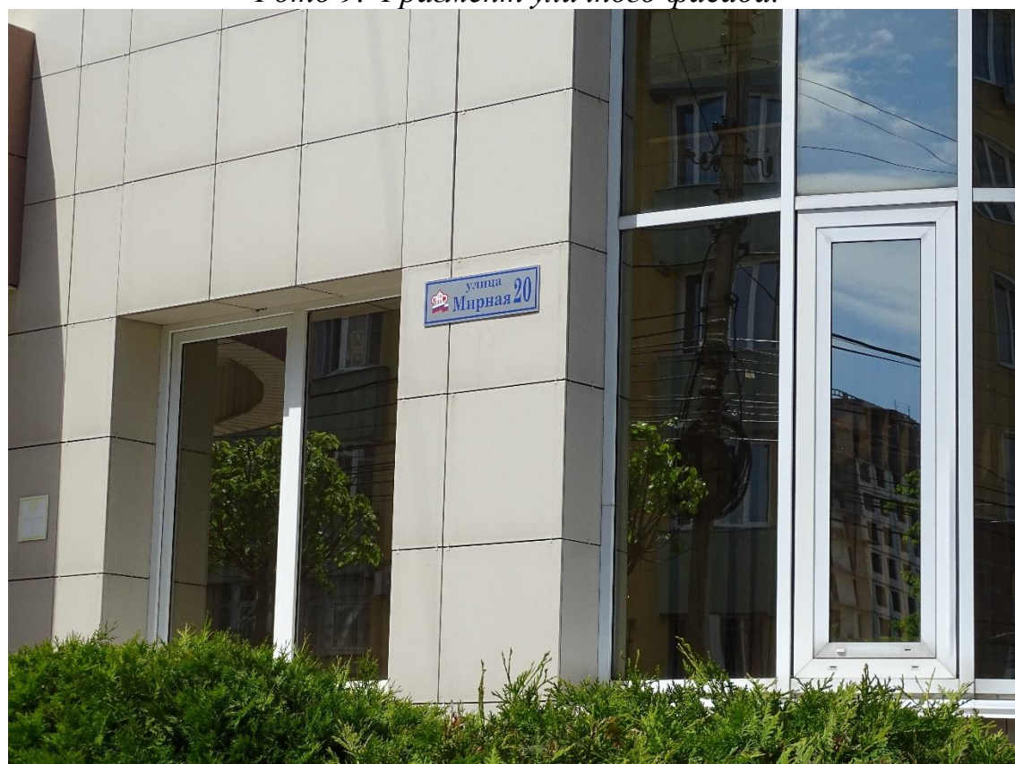
Фото 10. Фрагмент уличного фасада.
