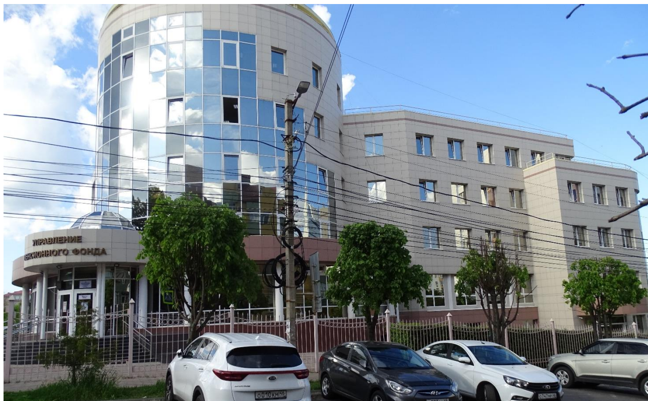
Фото 5. Южный фасад здания.
