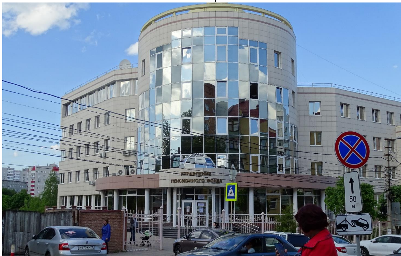
Фото 6. Западный фасад здания.
