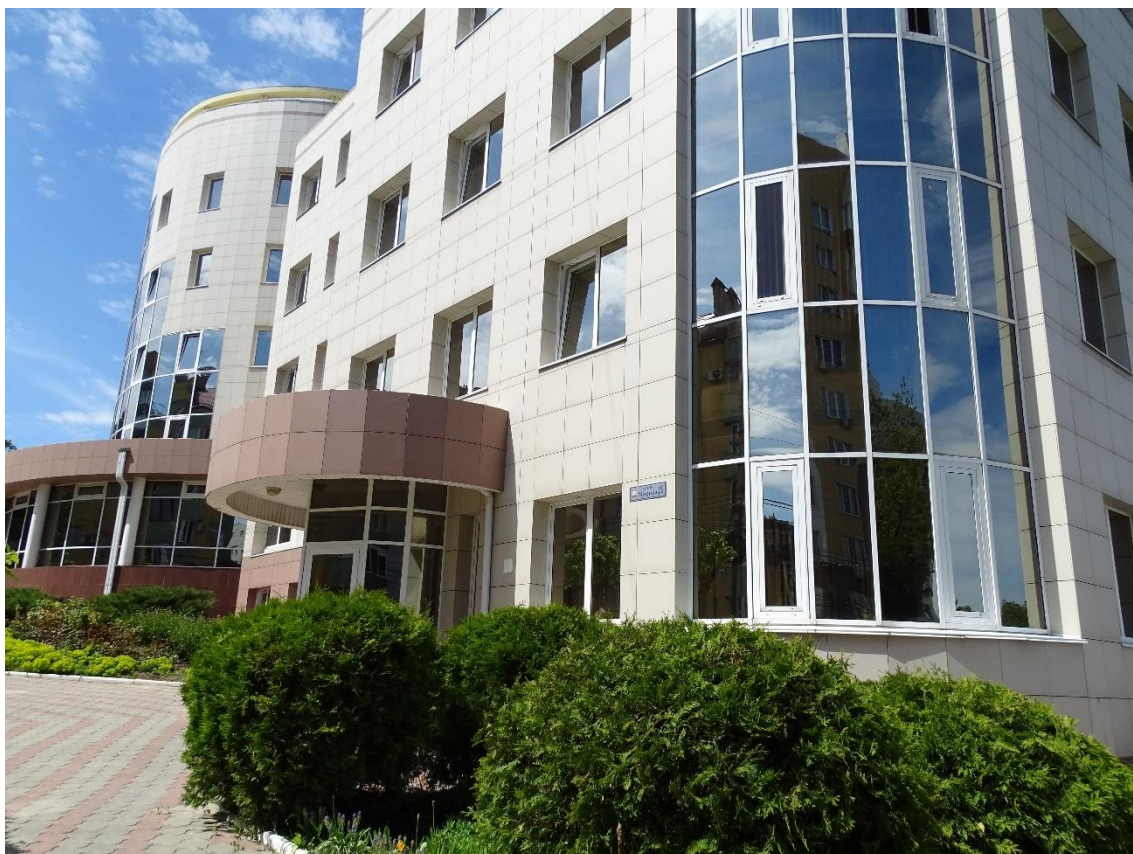
Фото 9. Фрагмент уличного фасада.
