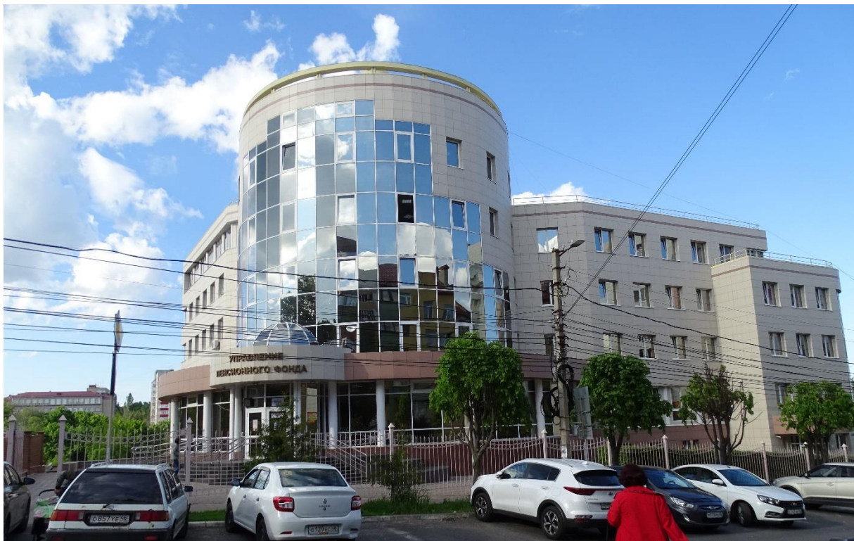
Фото 1. Главный фасад. Общий вид
