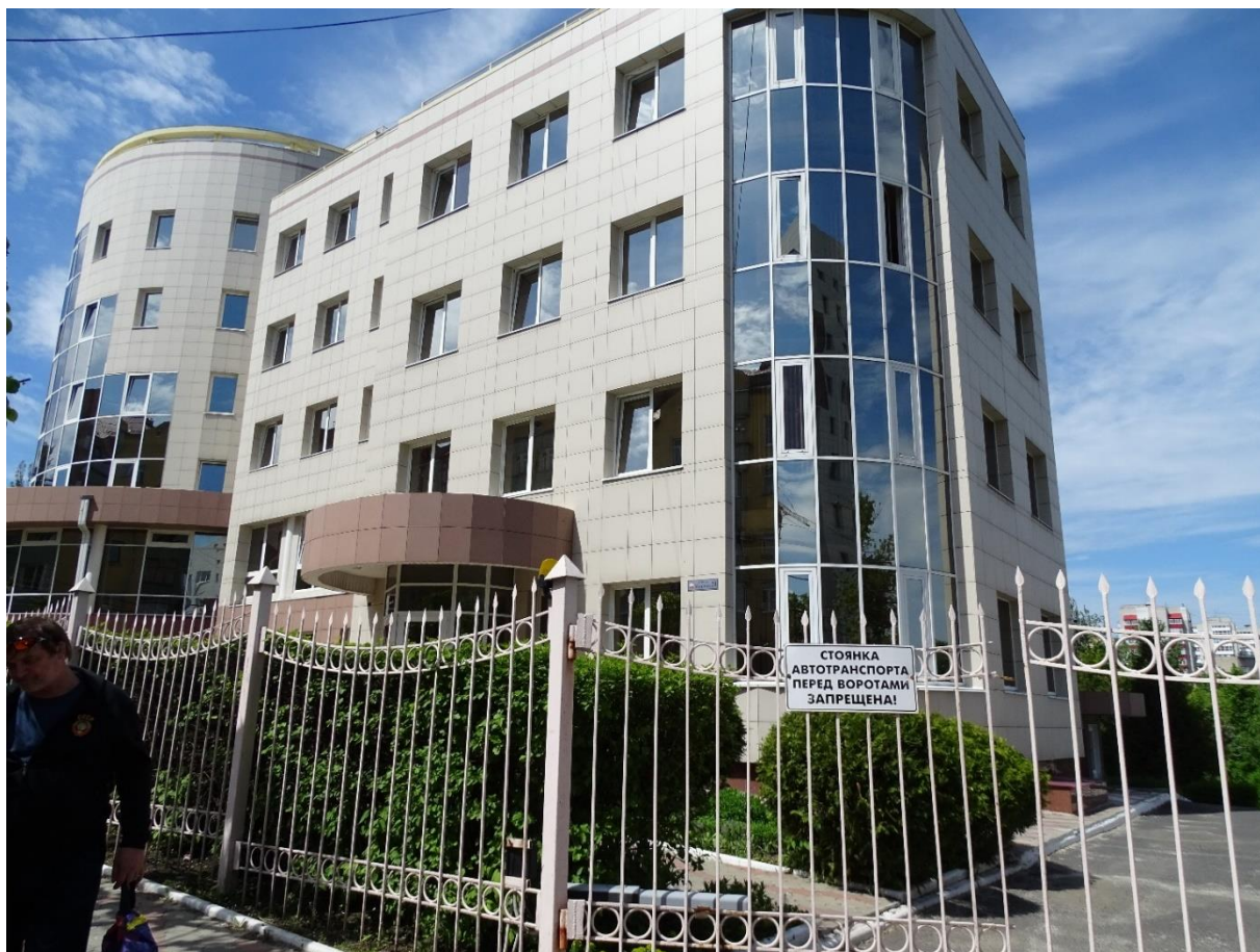
Фото 7. Фрагмент восточного фасада.
