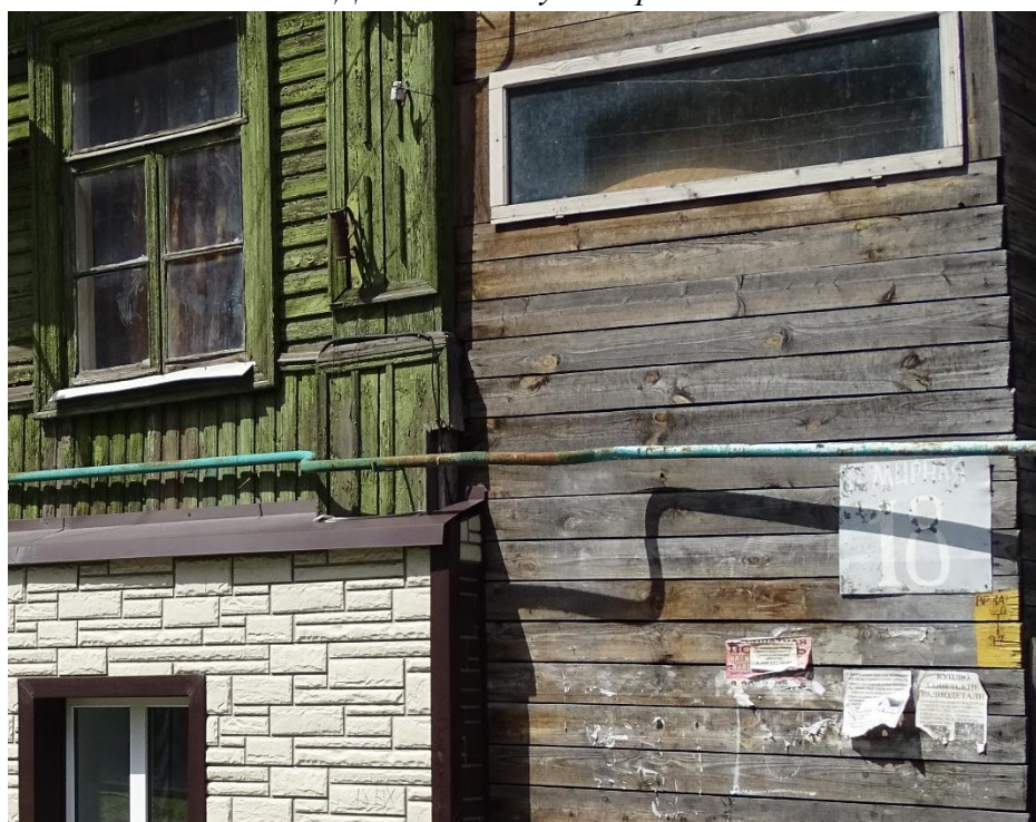
Местоположение таблички с номером на фасаде здания.
