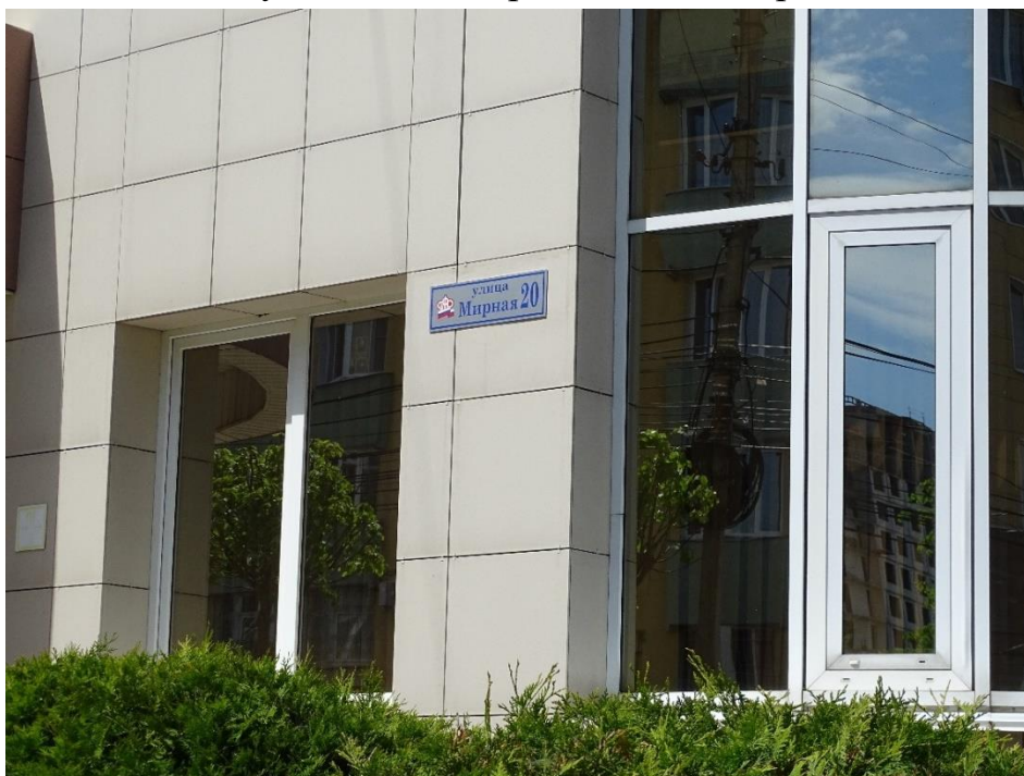
Адресная табличка на фасаде здания.
