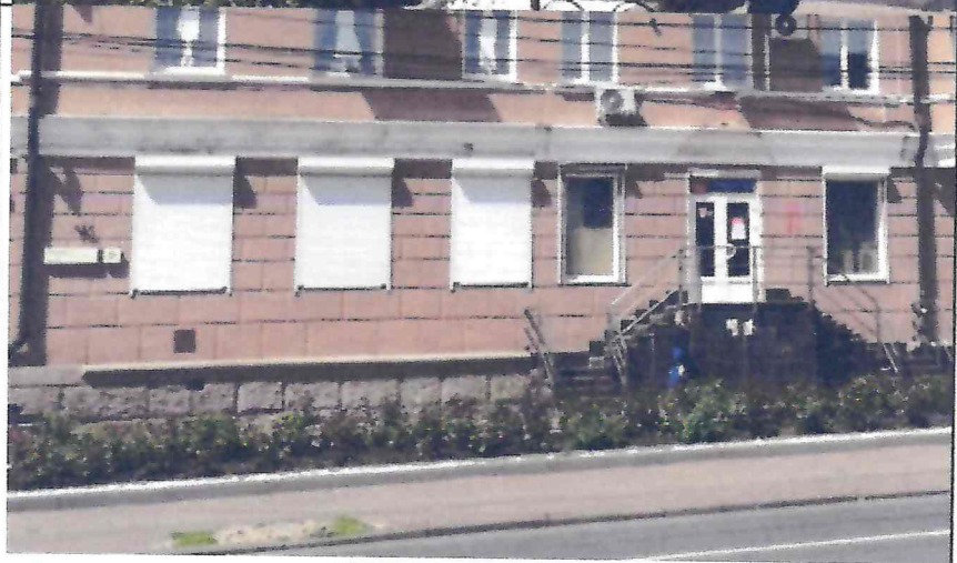
Окна первого этажа
