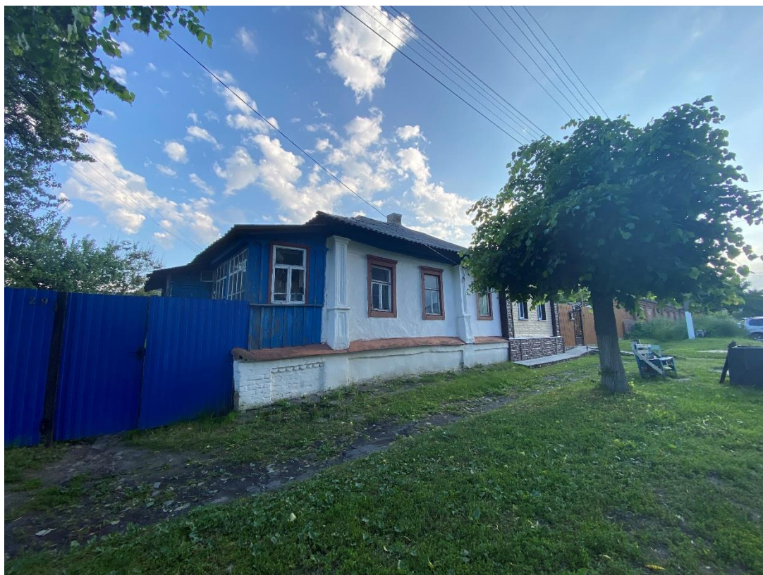
Фотография № 5. Вид с северо-востока на Объект.
