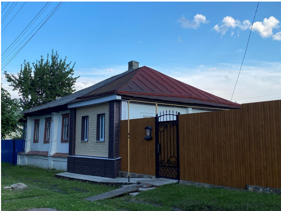
Фотография № 8. Вид с северо-запада на Объект.
