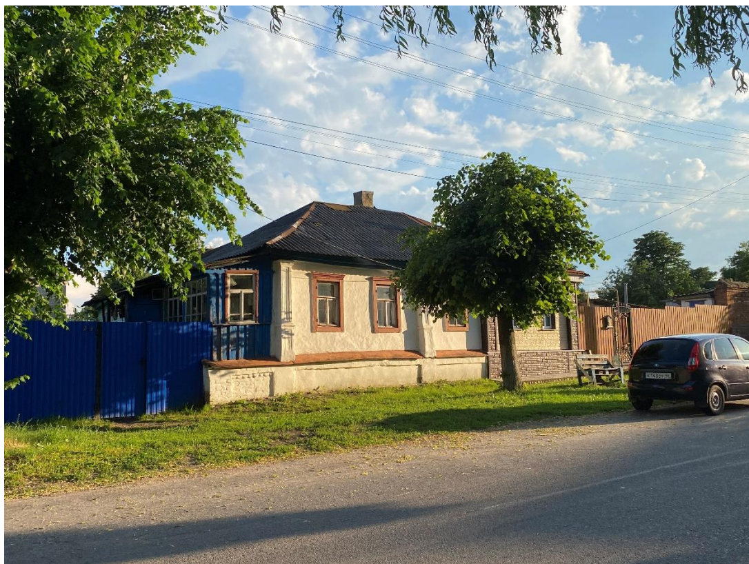
Фотография № 3. Вид с северо-востока на Объект.
