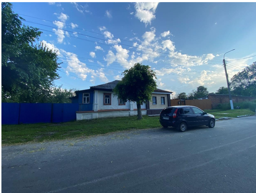
Фотография № 6. Вид с северо-востока на Объект.
