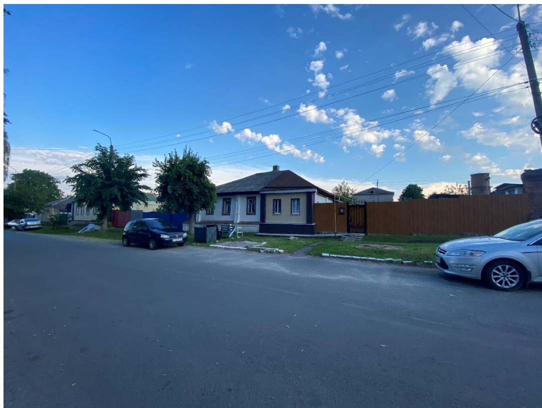
Фотография № 10. Вид с северо-запада на Объект.
