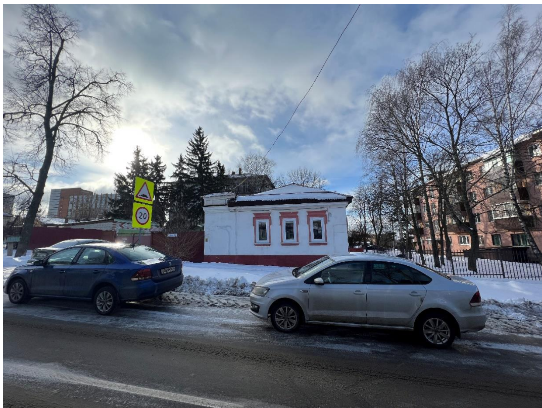
Фотография № 5. Вид с севера на Объект.
