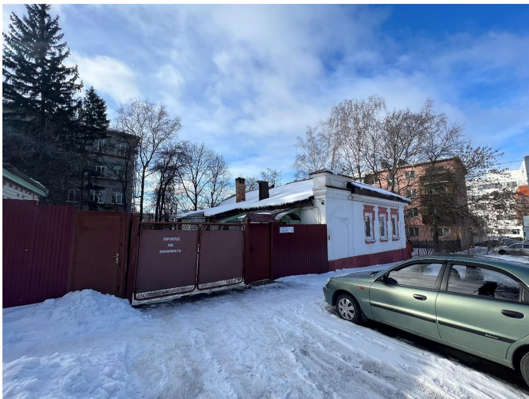
Фотография № 2. Вид с северо-востока на Объект.
