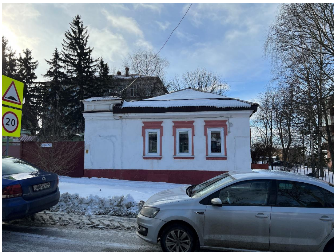
Фотография № 4. Вид с севера на Объект.
