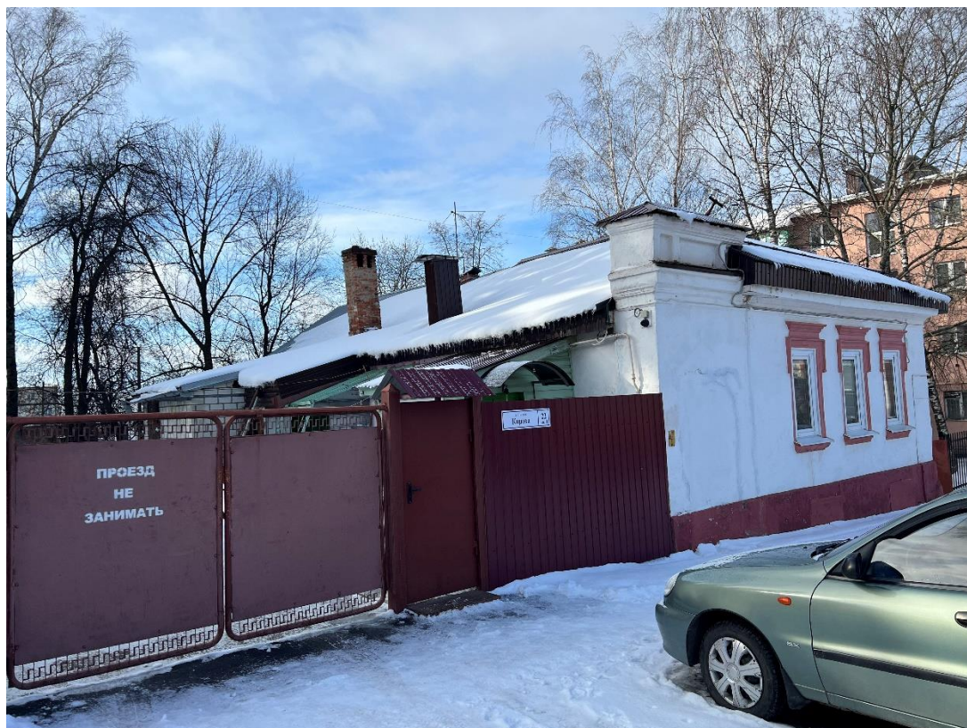
Фотография № 3. Вид с северо-востока на Объект.
