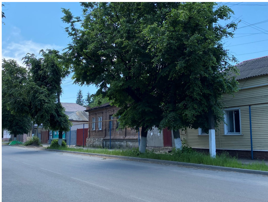
Фотография № 10. Вид с северо-востока на Объект.
