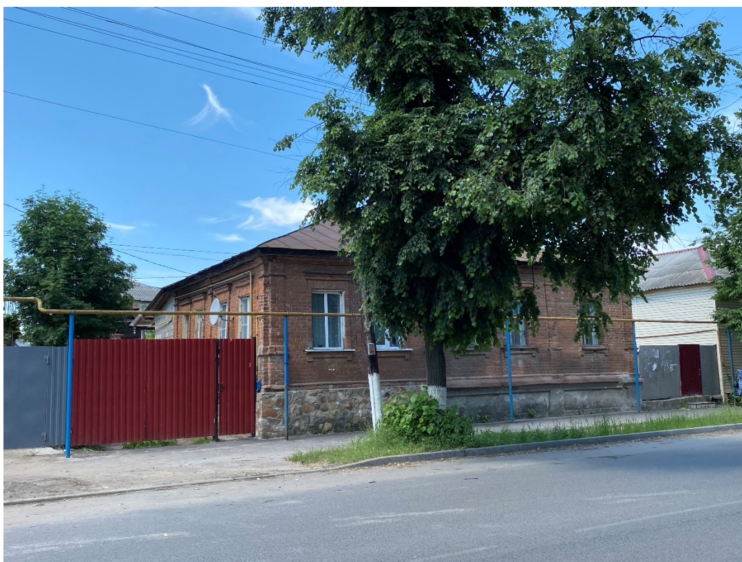
Фотография № 4. Вид с юго-востока на Объект.
