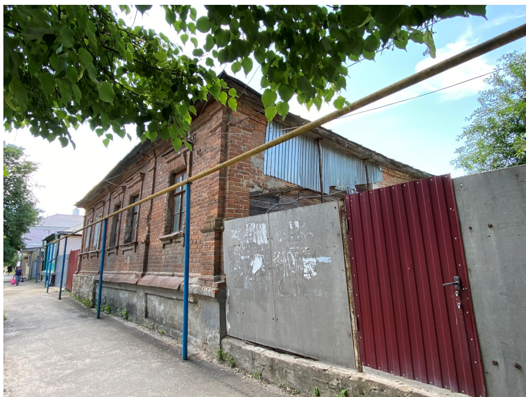
Фотография № 8. Вид с северо-востока на Объект.
