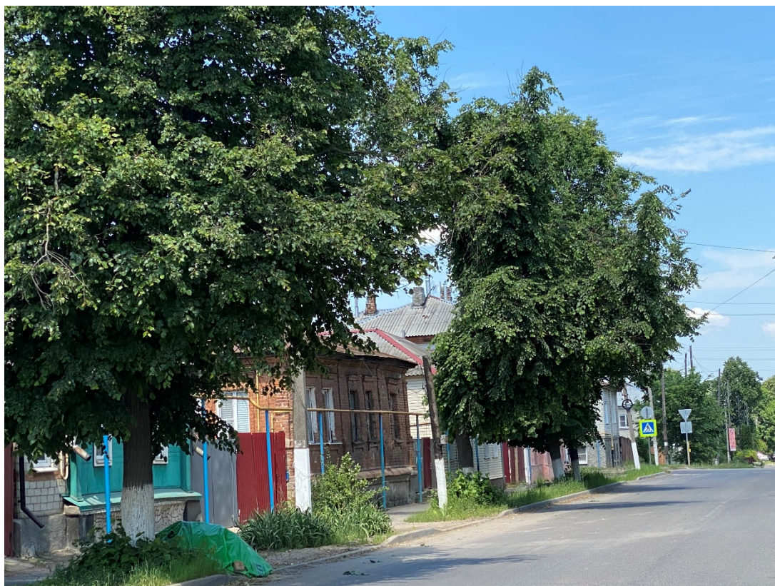
Фотография № 2. Вид с юго-востока на Объект.
