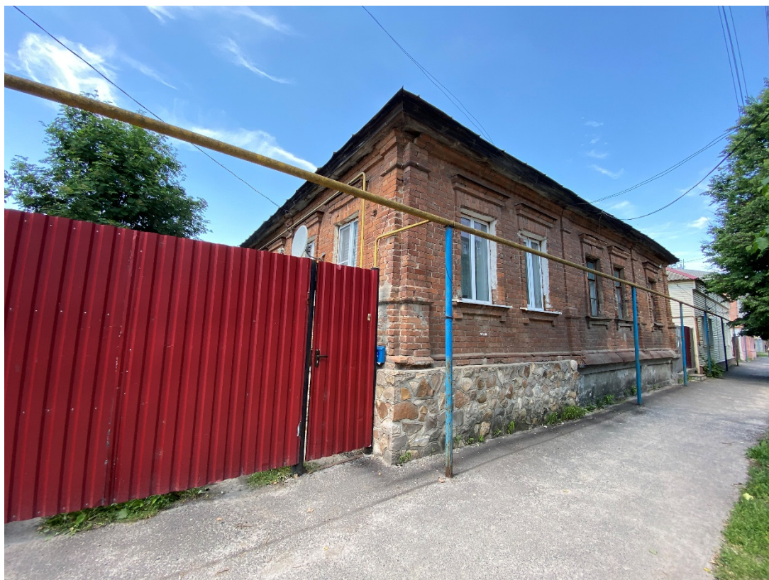
Фотография № 5. Вид с юго-востока на Объект.
