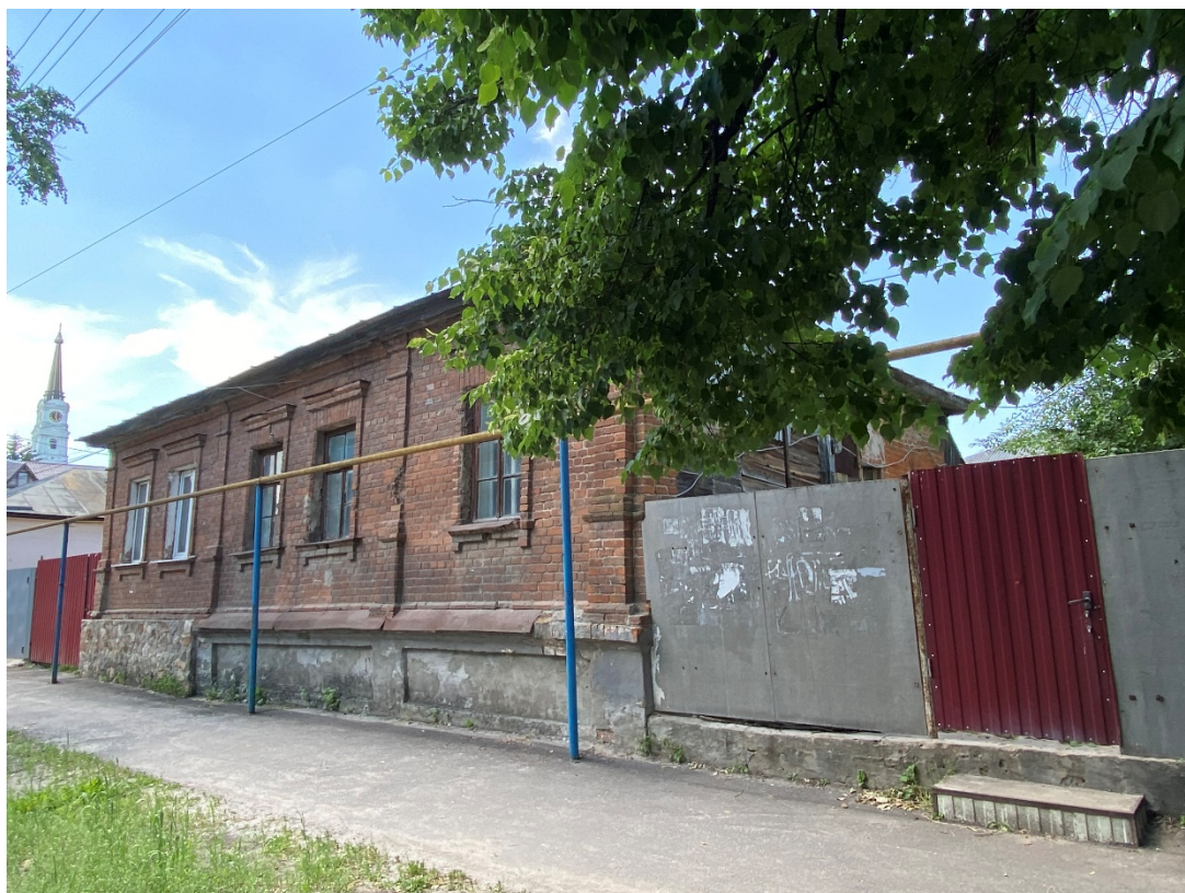
Фотография № 9. Вид с северо-востока на Объект.
