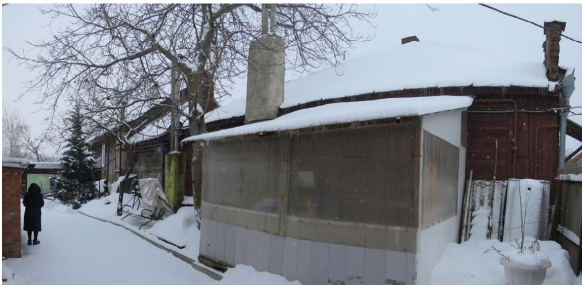
13. Вид с севера со двора
