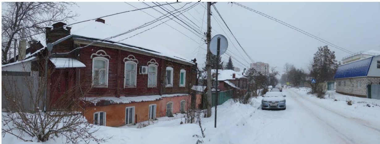
5. Вид с востока со двора
