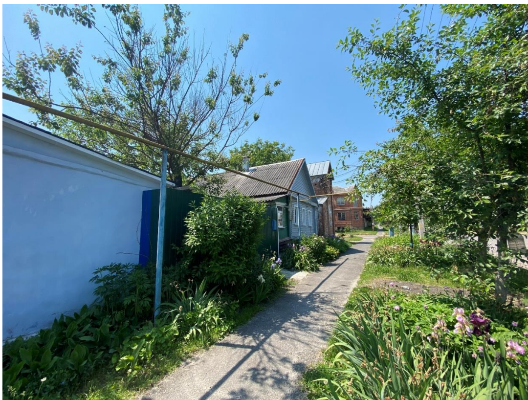
Фотография № 1. Вид с северо-востока на здание по адресу ул. Куйбышева, д.45.
