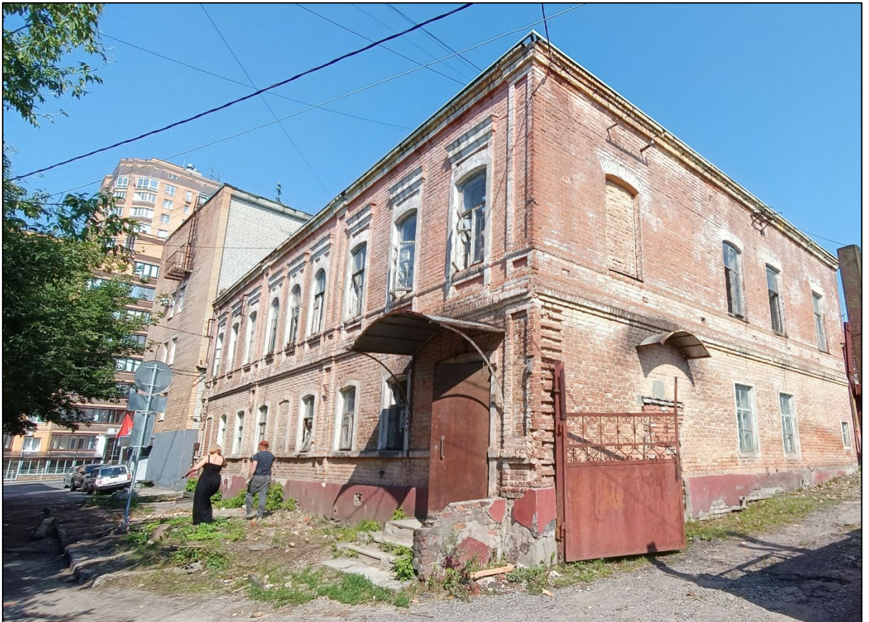
Фото 2. Общий вид на объект.
