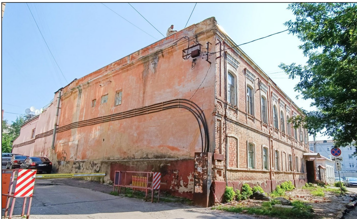
Фото 1. Общий вид на объект.
