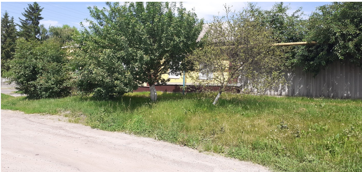
Фотография № 9. Вид с юго-запада на Объект.
