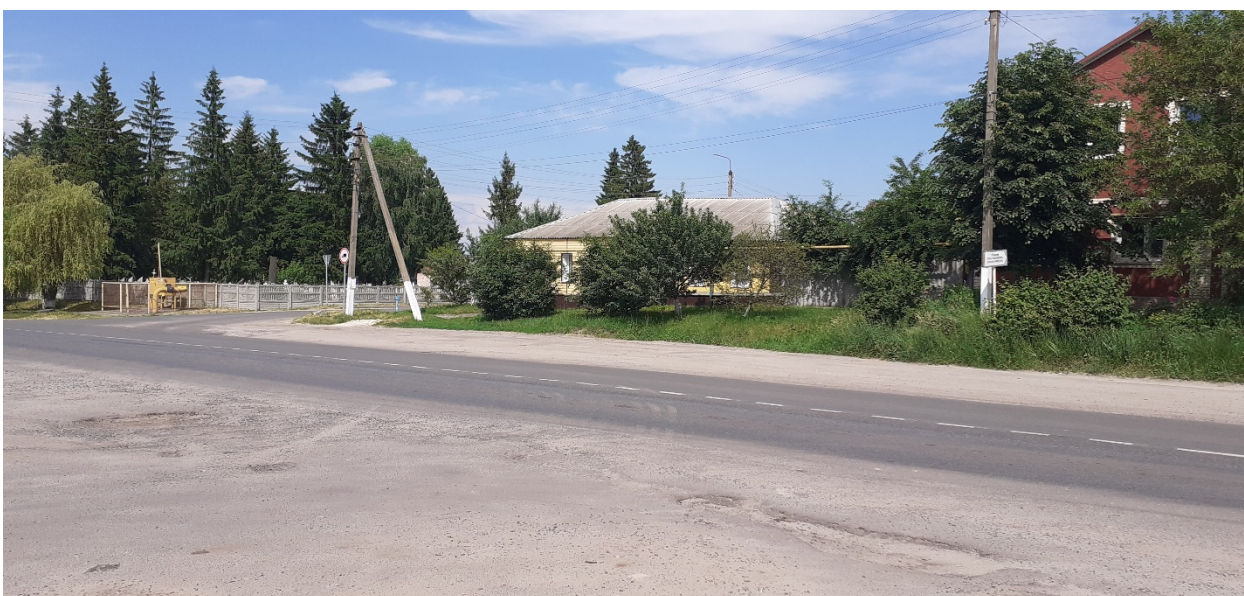
Фотография № 10. Вид с юго-запада на Объект.
