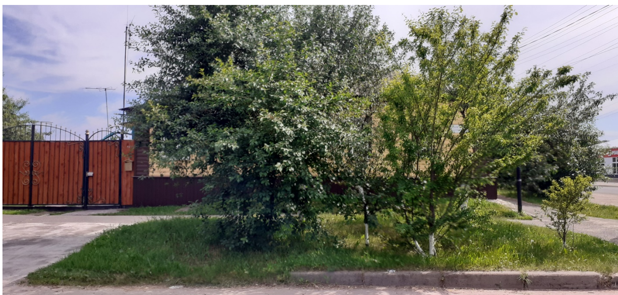
Фотография № 2. Вид с севера на Объект.
