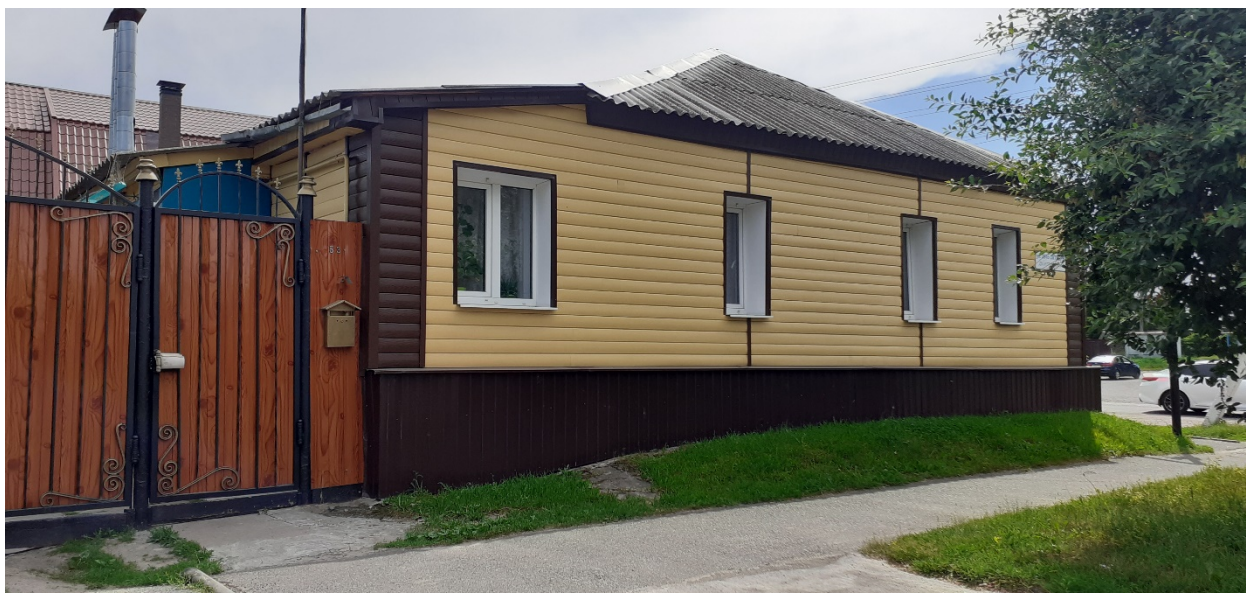
Фотография № 1. Вид с северо-востока на Объект.
