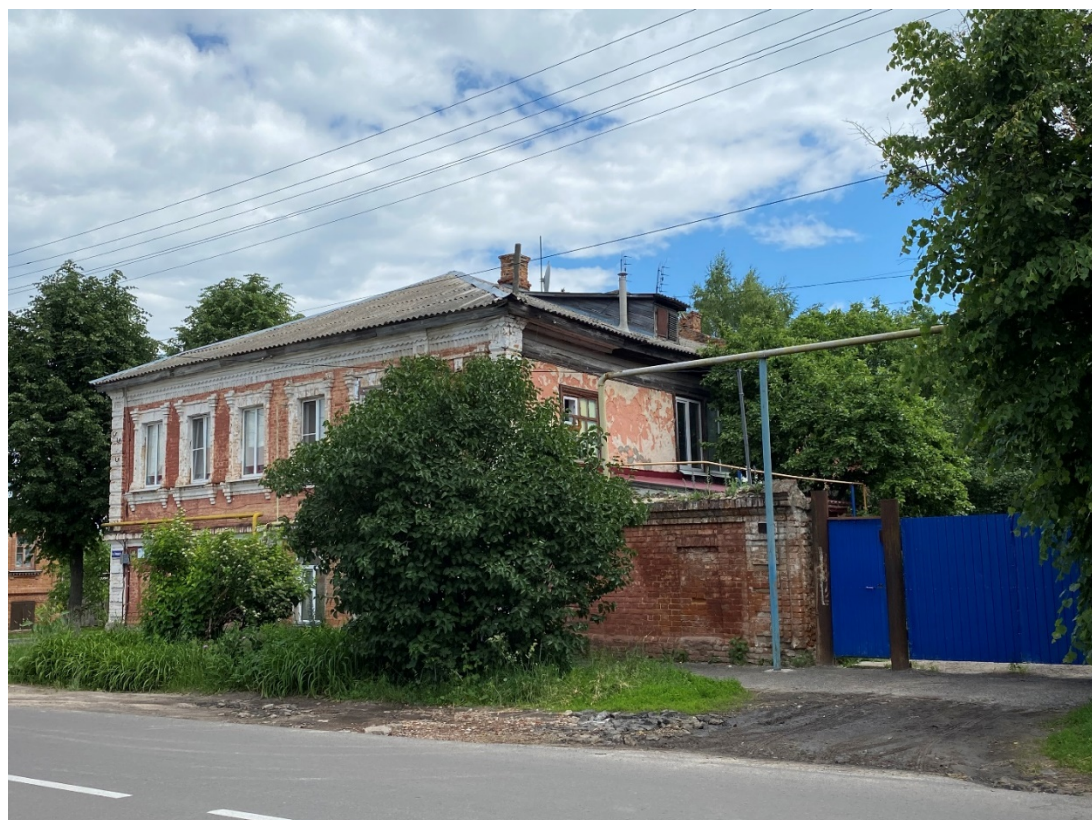
Фотография № 10. Вид с юго-запада на Объект.
