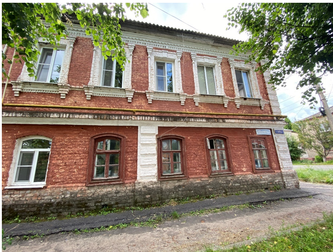
Фотография № 4. Вид с севера на Объект.
