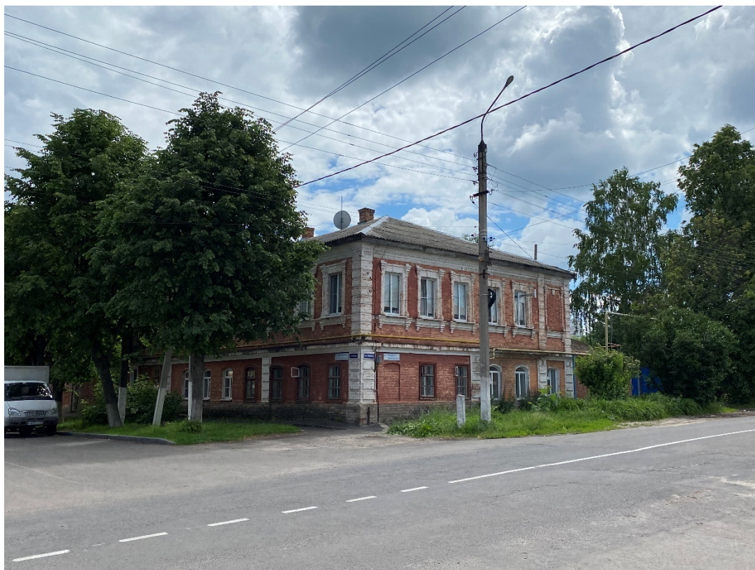
Фотография Объекта. Вид с юго-запада на Объект. 23.05.2022 г. Автор: Е.М. Федосеева
