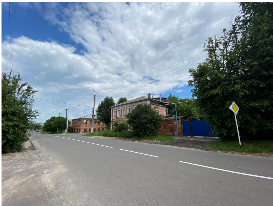
Фотография № 11. Вид с юго-запада на Объект.
