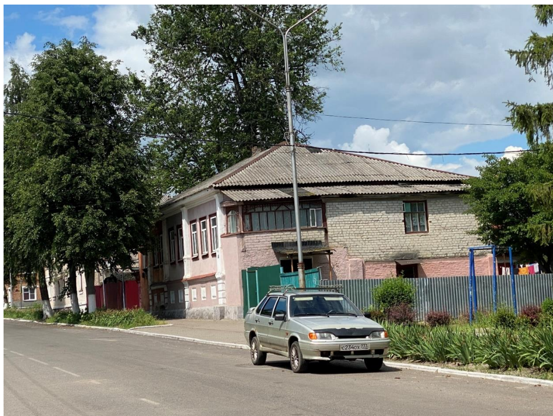
Фотография № 2. Вид с юго-востока на Объект.
