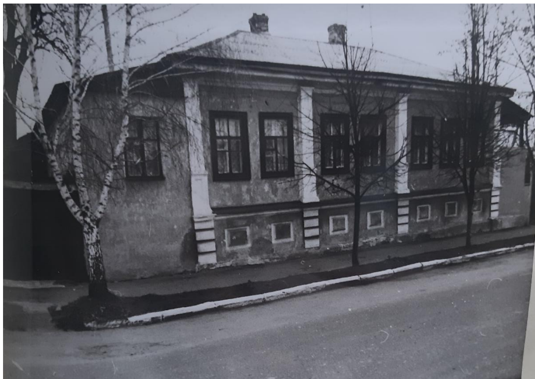
18. Дом по ул. Свердлова, 18.
