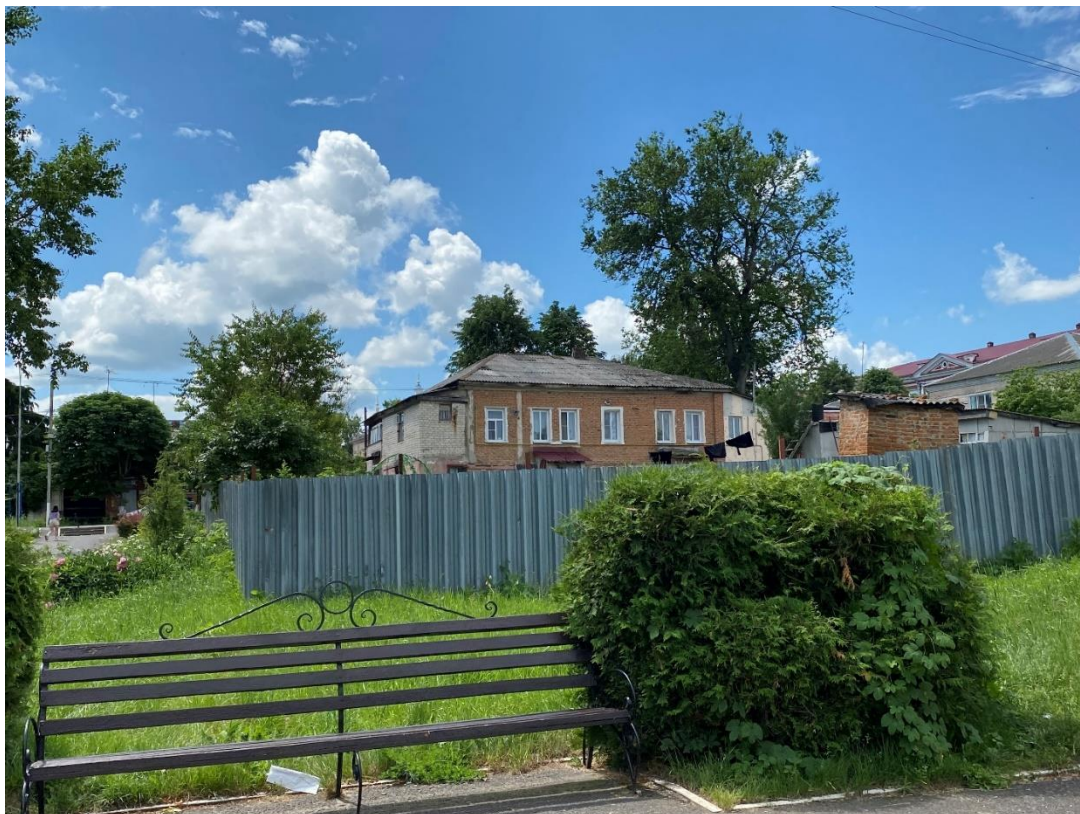
Фотография № 5. Вид с северо-востока на Объект.
