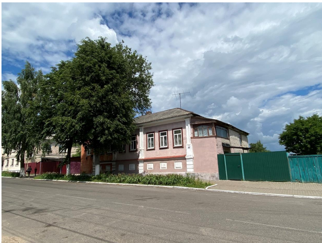
Фотография № 6. Вид с юго-востока на Объект.
