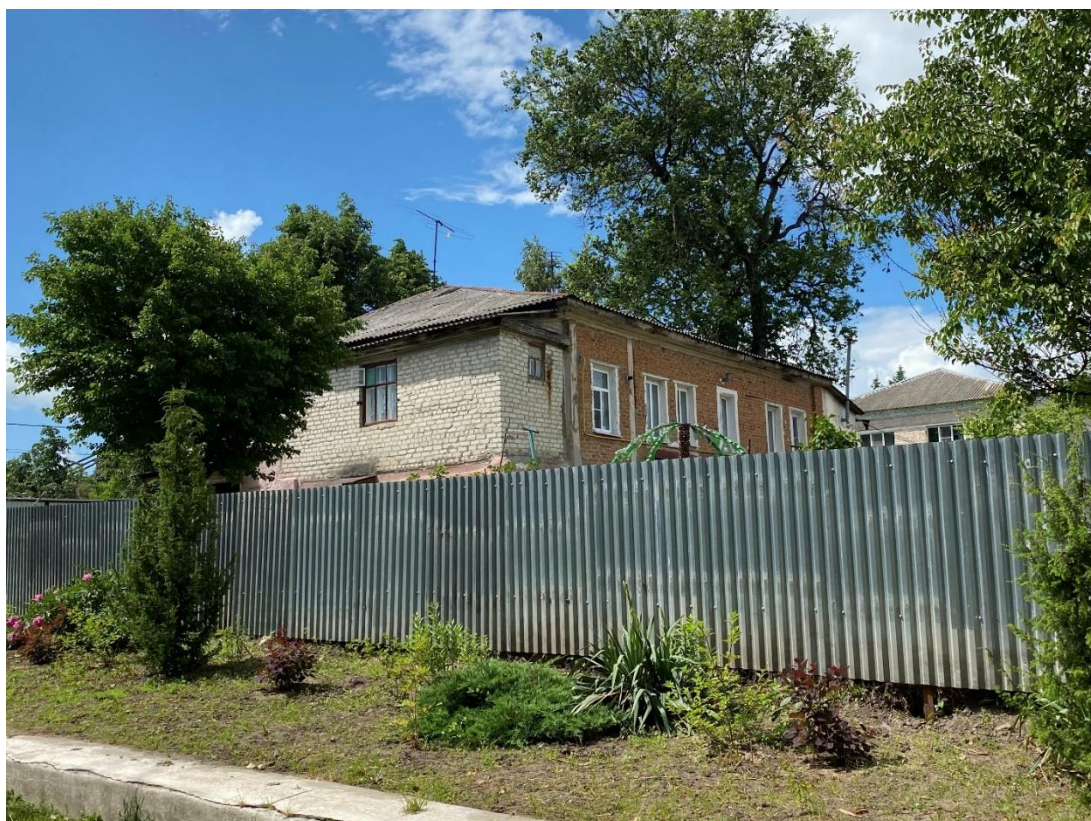
Фотография № 4. Вид с северо-востока на Объект.
