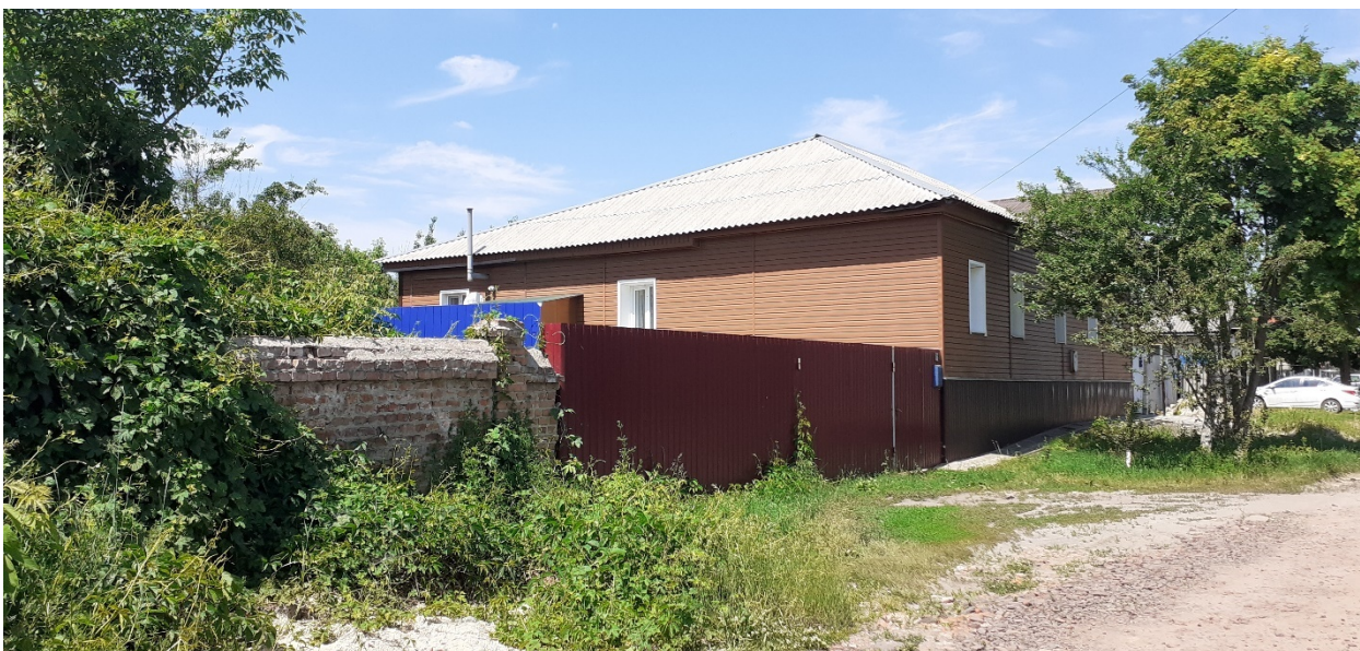
Фотография № 2. Вид с юго-востока на Объект.
