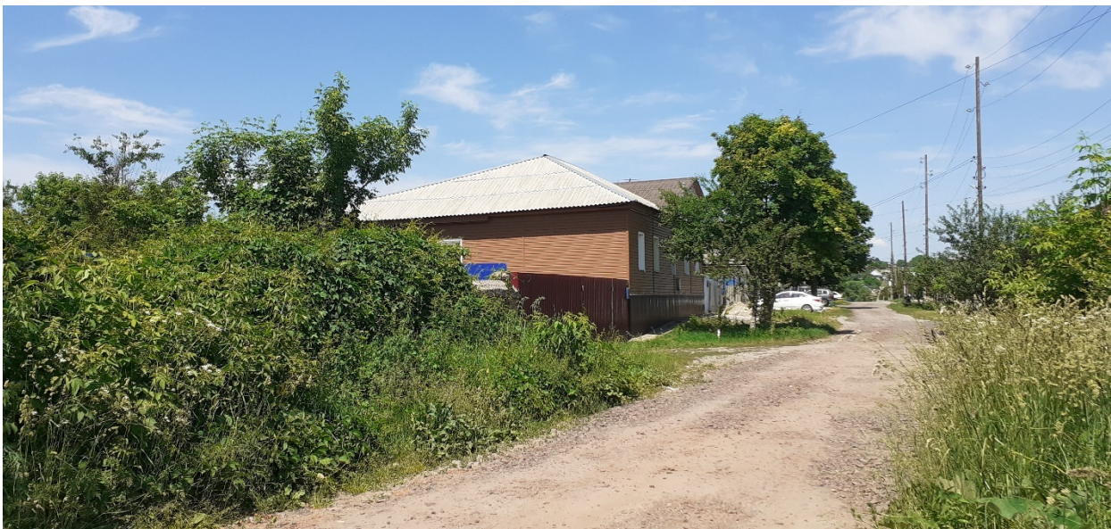
Фотография № 1. Вид с юго-востока на Объект.
