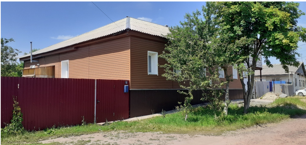
Фотография № 3. Вид с юго-востока на Объект.
