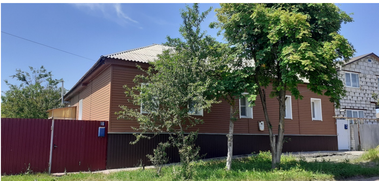
Фотография № 4. Вид с юго-востока на Объект.
