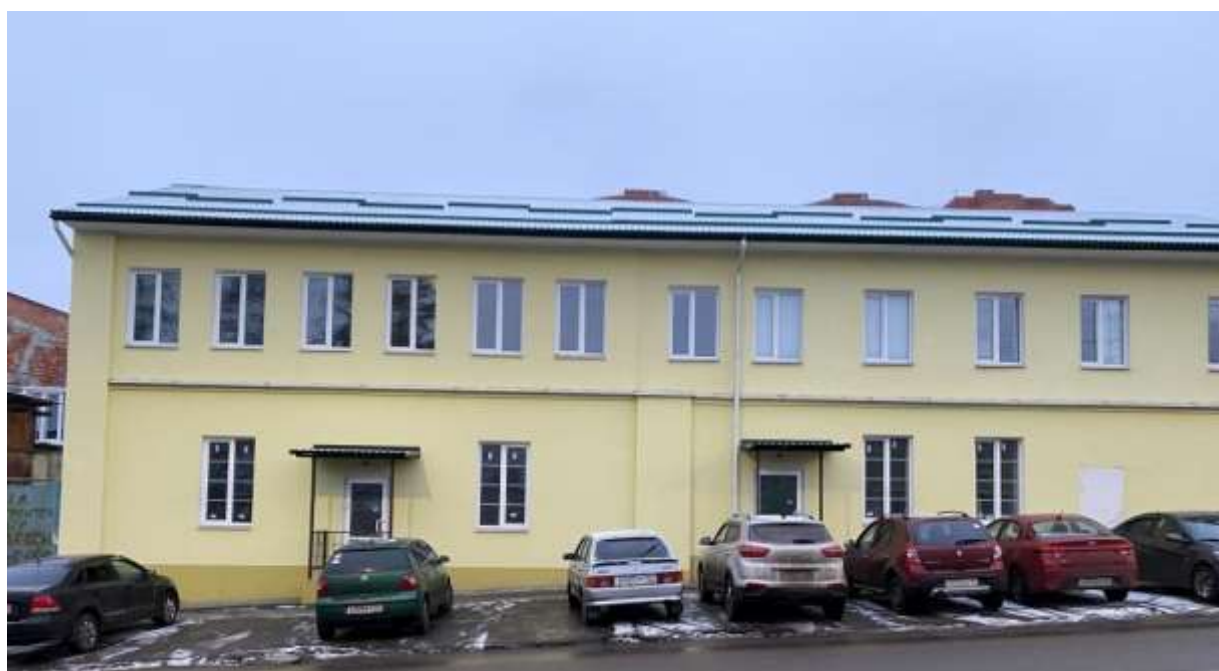
Выявленный объект культурного наследия «Дом жилой, кон. XIX – нач. XX вв.» по адресу: г. Курск, ул. Большевиков, 42 А. Современный вид главного фасада с ул. Большевиков. Фото Т.С.Старцевой, февраль, 2022 год.
