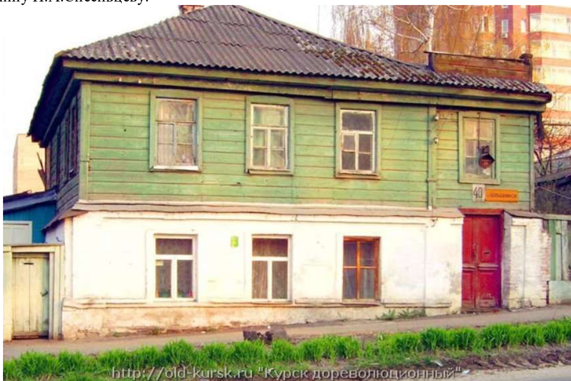
Дом надворного советника А.М.Федорова по адресу: г.Курск, ул. Большевиков, 40. С сайта http://old-kursk.ru/strit/strit.html Курск дореволюционный. Адресный список домовладельцев г. Курска составлен по адресному календарю 1916 года иллюстрирован современными фотографиями сохранившихся построек Ю.В.Озерова, Акварелям И.И. Ликоренко и др. источникам.
