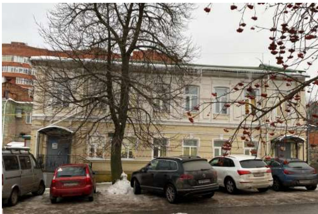
Здание по адресу: г.Курск, ул. Большевиков, дом 42. Выявленный объект культурного наследия. Фото Т.С.Старцевой, февраль, 2022 года
