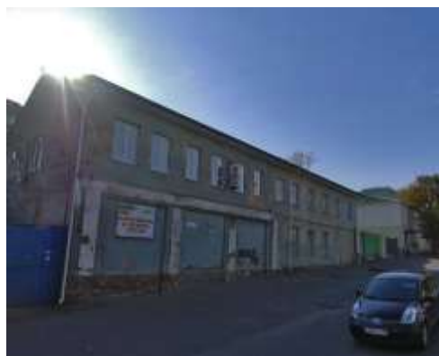
Выявленный объект культурного наследия «Дом жилой, кон. XIX – нач. XX вв.» по адресу: г. Курск, ул. Большевиков, 42 А. Вид главного фасада до реконструкции 2019 года. Фото из Перечня выявленных объектов культурного наследия, расположенных на территории Курской области (по состоянию на 06.09.2021 года)
