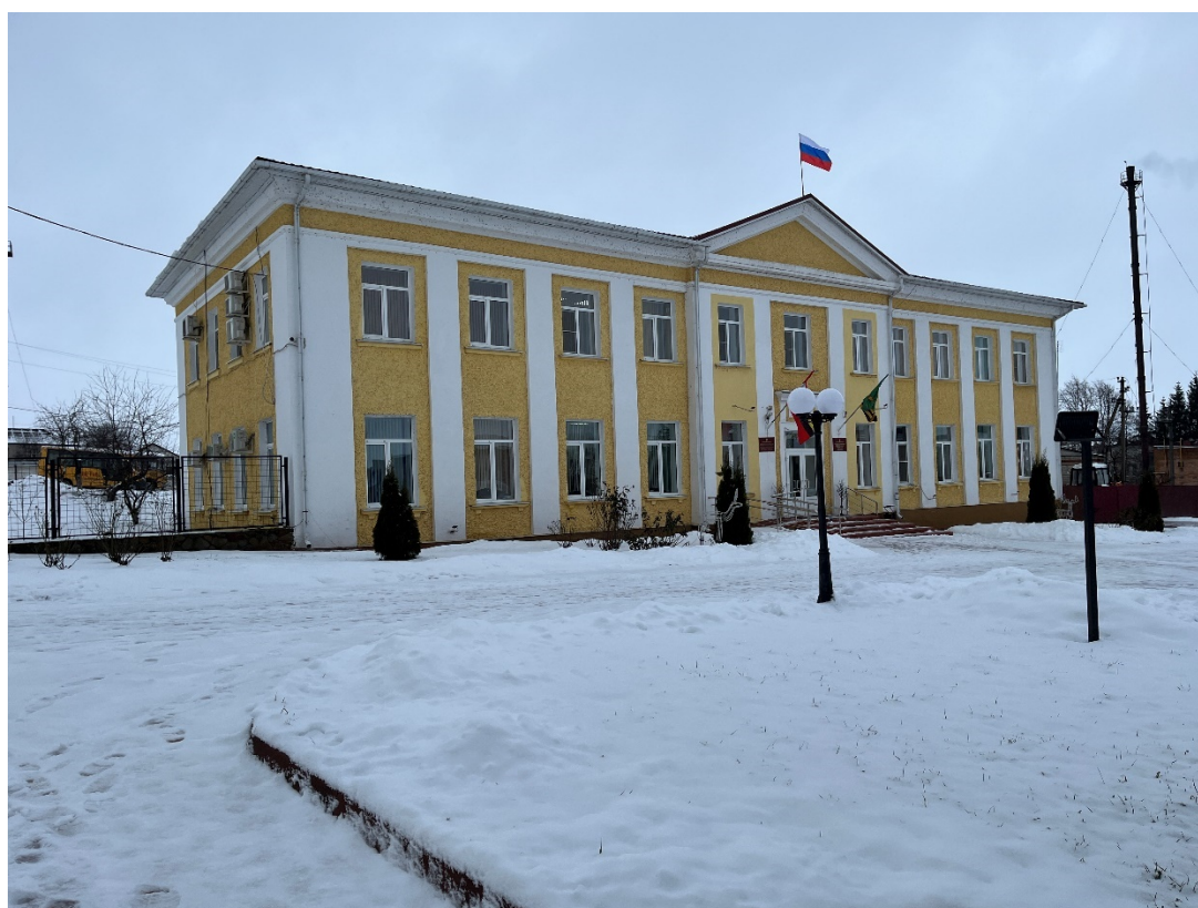
Фотография № 4. Вид с юго-востока на Объект.
