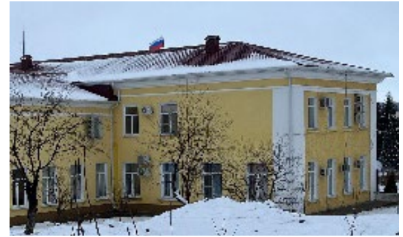
композиция дворового фасада
