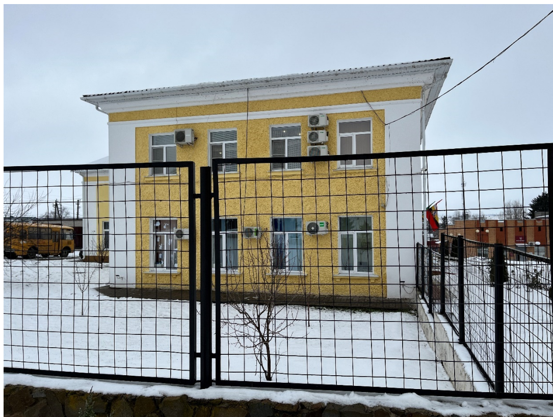
Фотография № 6. Вид с юга на Объект.
