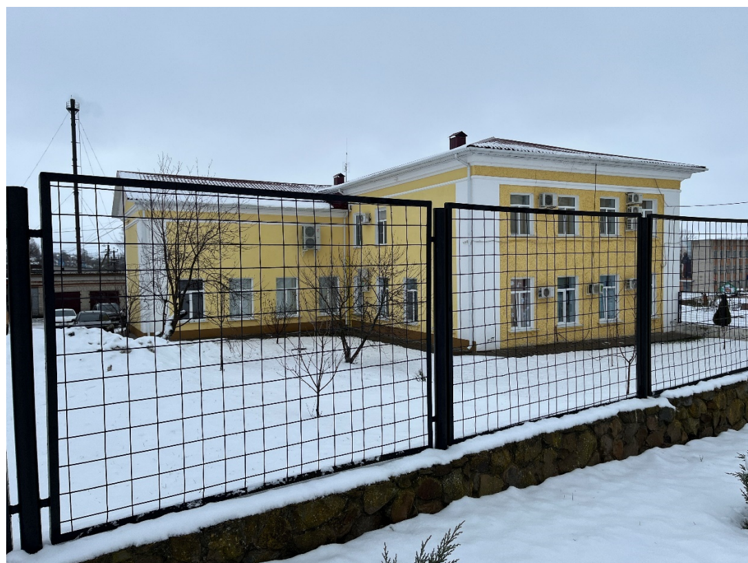
Фотография № 8. Вид с юго-запада на Объект.
