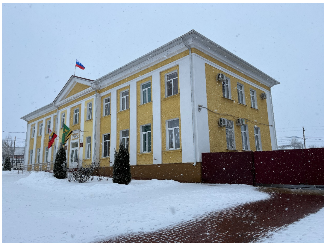
Фотография № 14. Вид с северо-востока на Объект.
