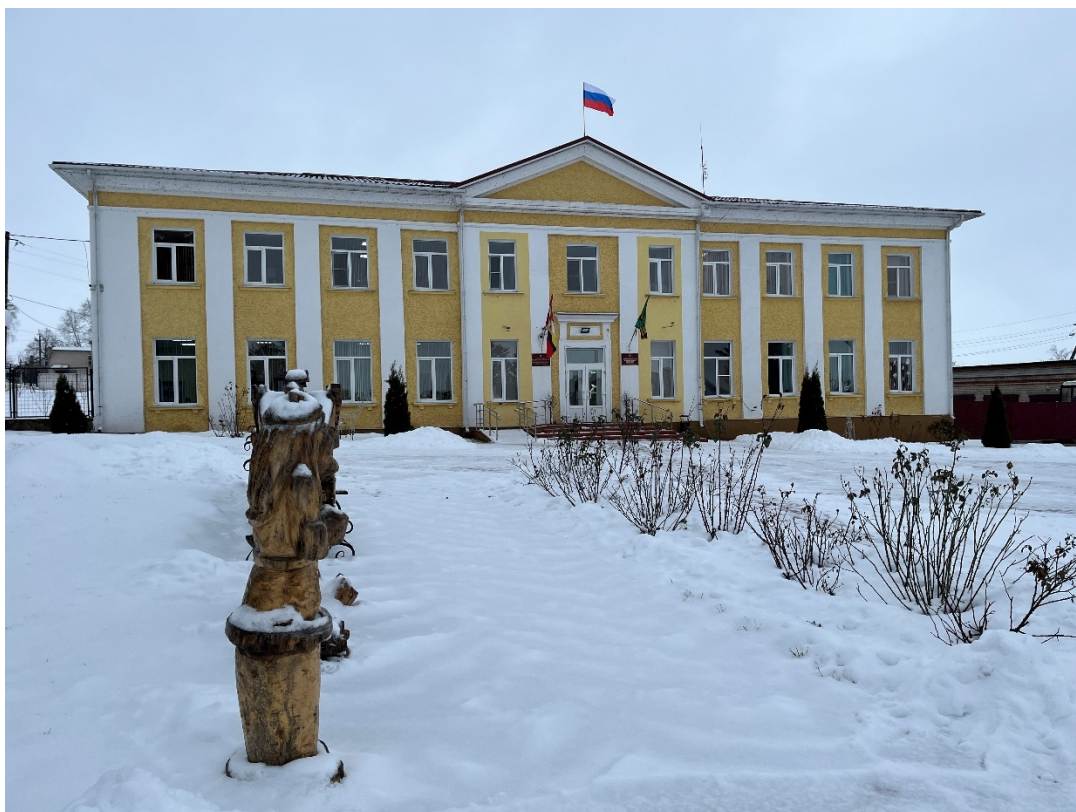
Фотография № 3. Вид с востока на Объект.
