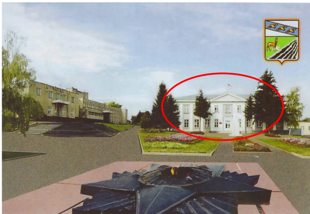
19. Центр поселка Медвенка. Вид на здание Объекта.
