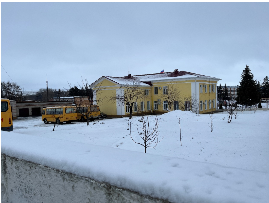
Фотография № 9. Вид с юго-запада на Объект.
