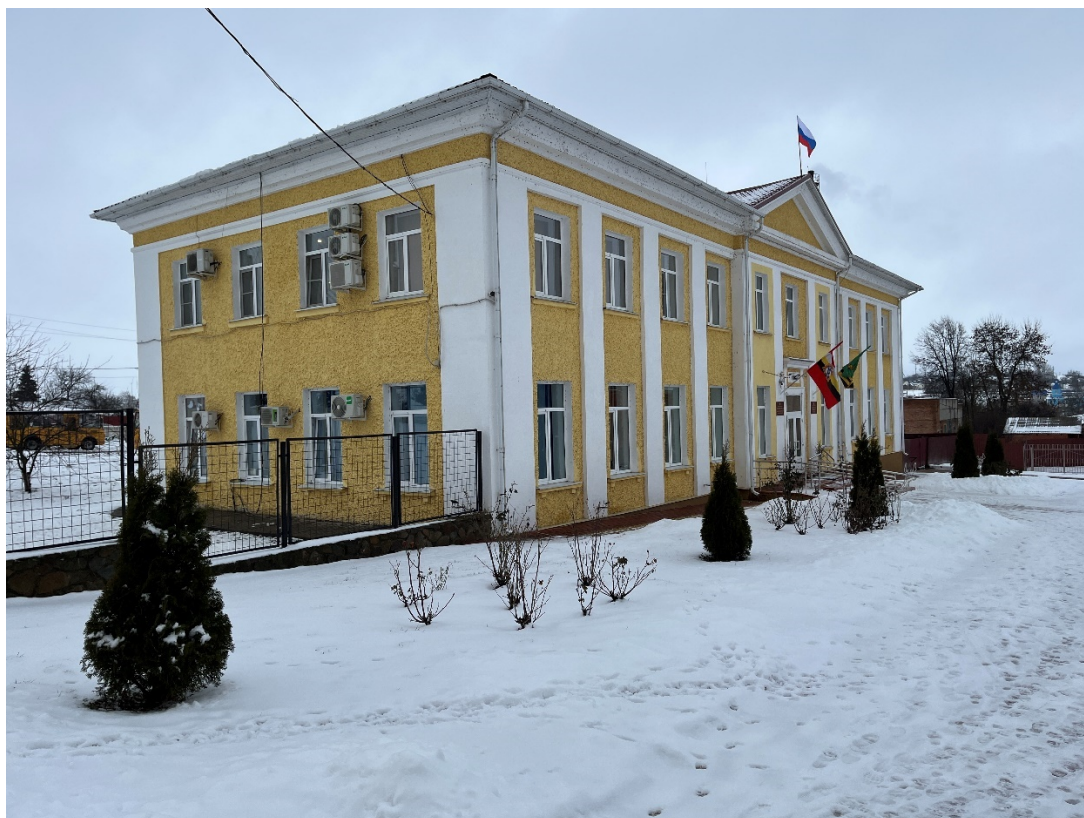
Фотография № 5. Вид с юго-востока на Объект.
