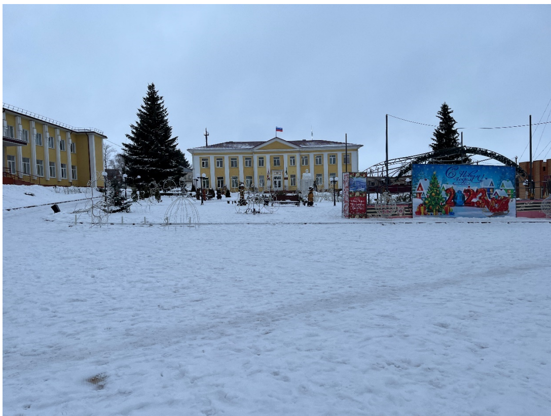
Фотография № 1. Вид с востока на Объект.
