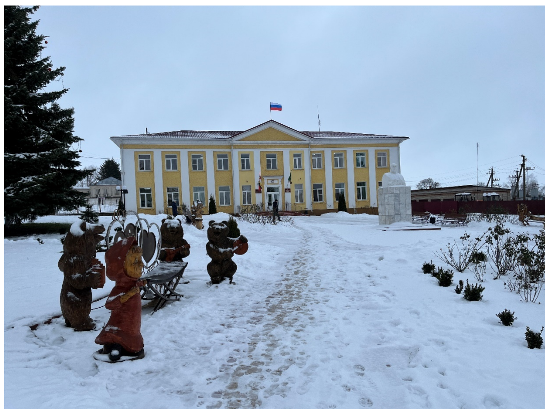
Фотография № 2. Вид с востока на Объект.
