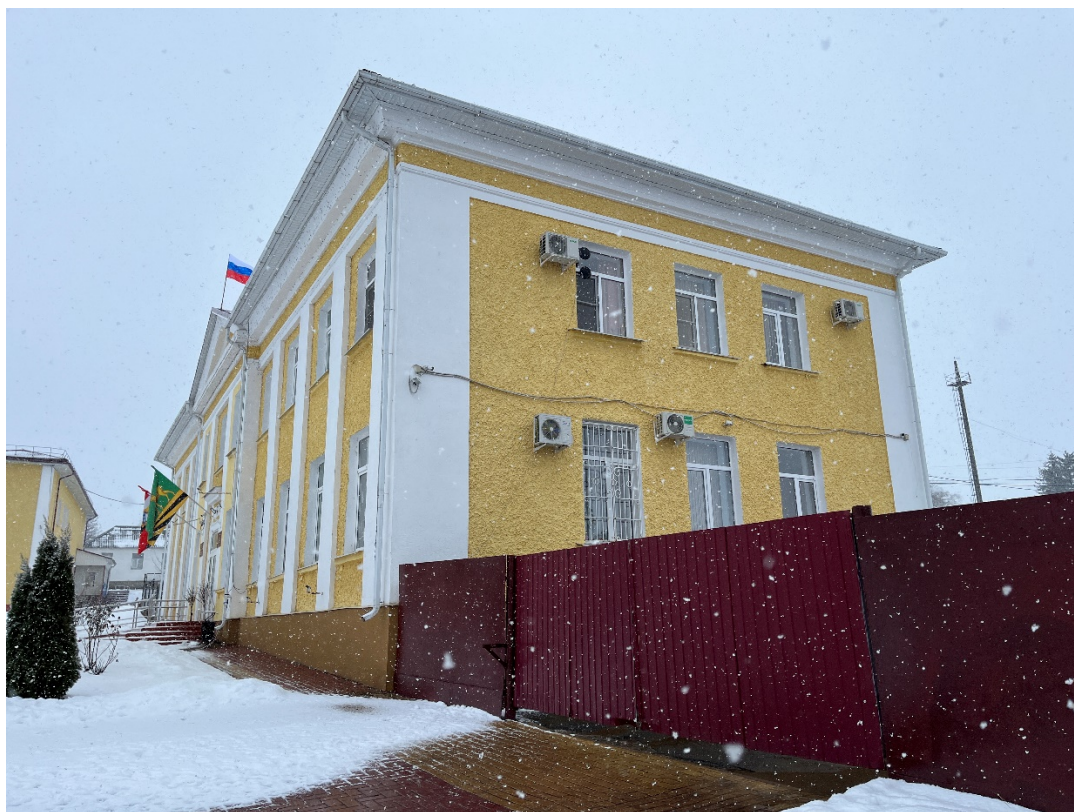
Фотография № 13. Вид с северо-востока на Объект.
