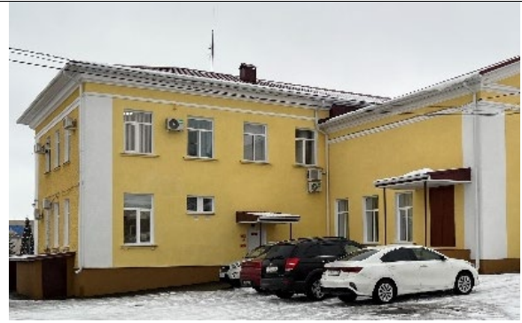
композиция дворового фасада
