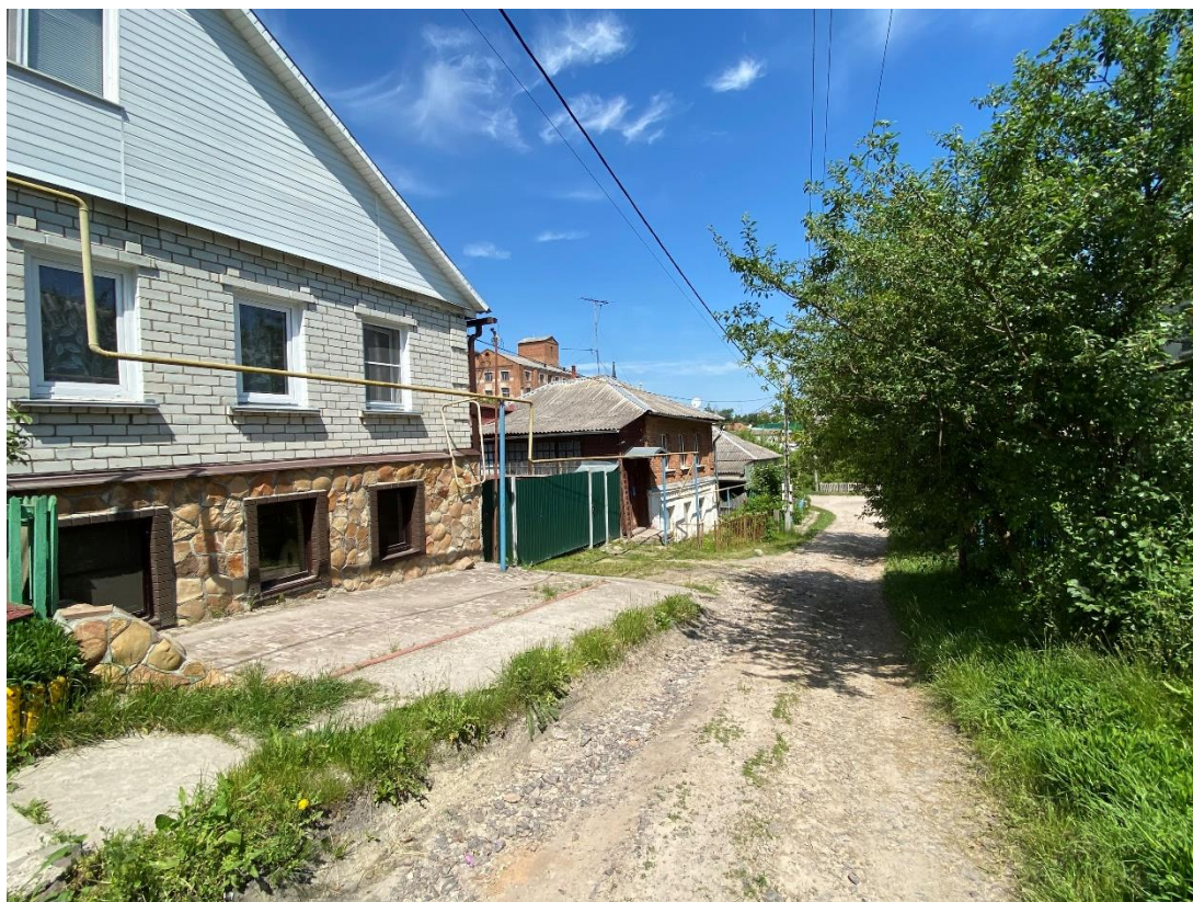
Фотография № 9. Вид с юго-востока на Объект.
