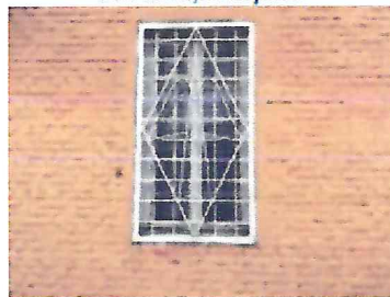
Оконный проем северного фасада
