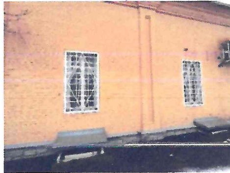
Световые проемы подвала, лопатка
