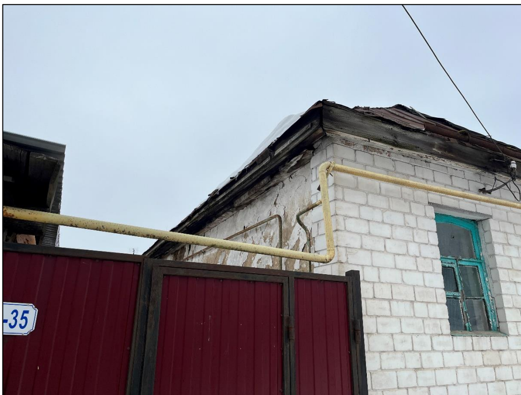
Т.ф.9. Вид на фрагмент Объекта с запада
