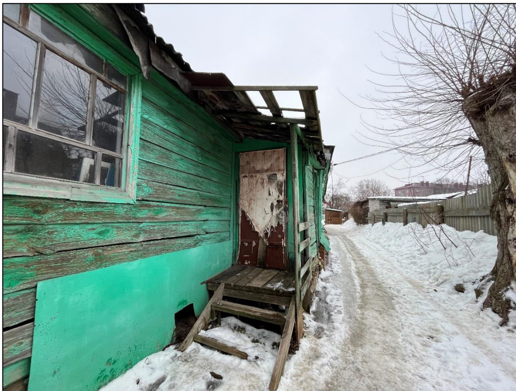
Т.ф.11. Общий вид на Объект с юго-запада
