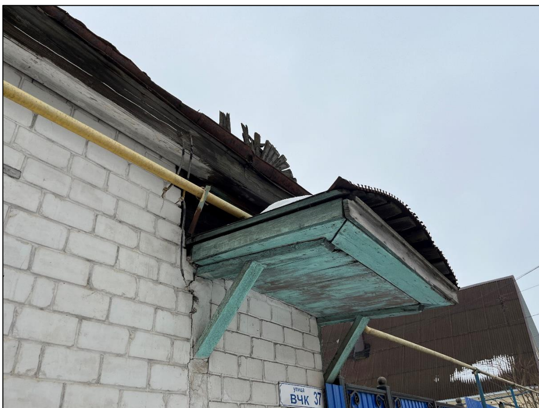
Т.ф.6. Вид на фрагмент Объекта с запада
