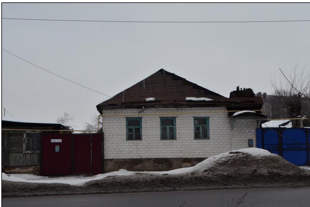
Т.ф.1. Общий вид на Объект с юго-запада
