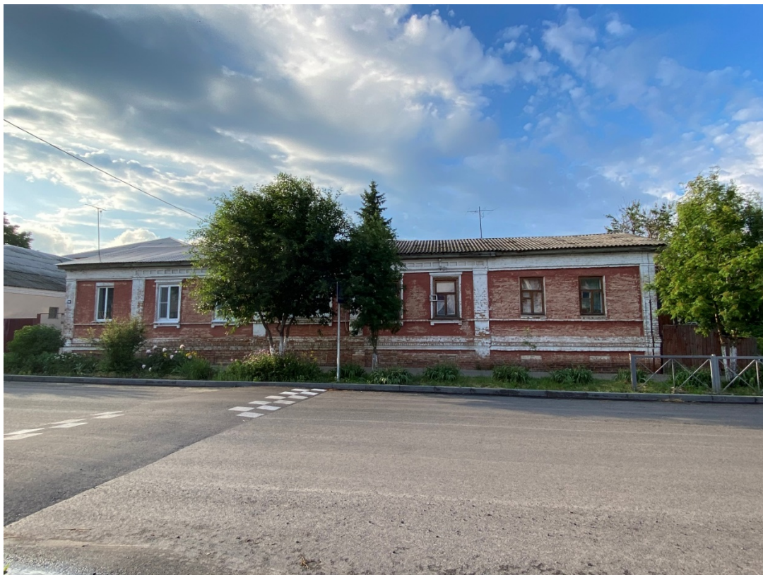
Фотография № 7. Вид с юга на Объект.
