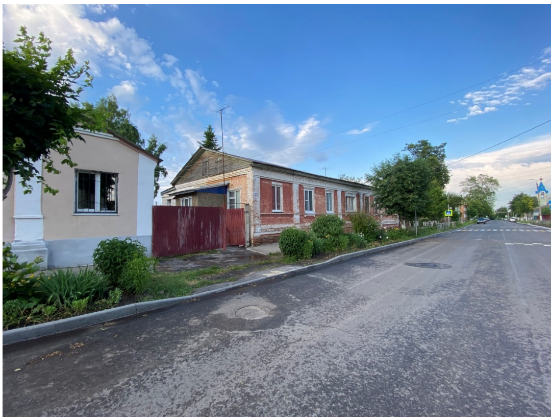
Фотография № 10. Вид с юго-запада на Объект.
