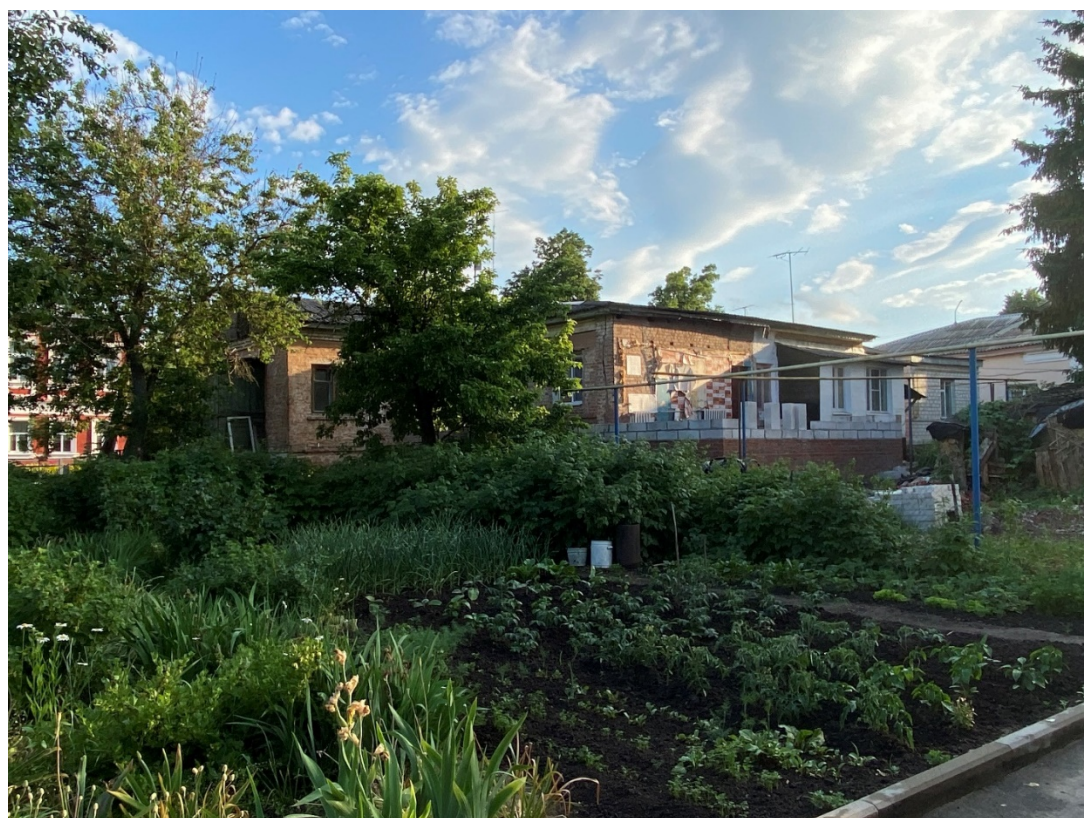
Фотография № 4. Вид с северо-востока на Объект.
