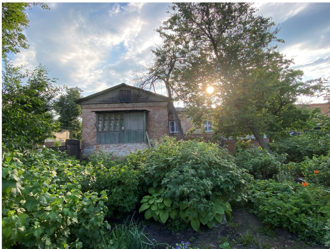
Фотография № 3. Вид с востока на Объект.
