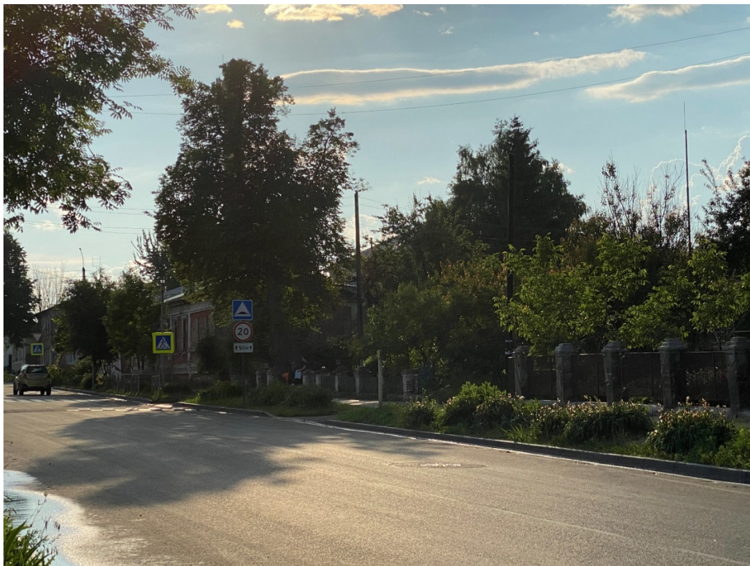
Фотография № 1. Вид с юго-востока на Объект.
