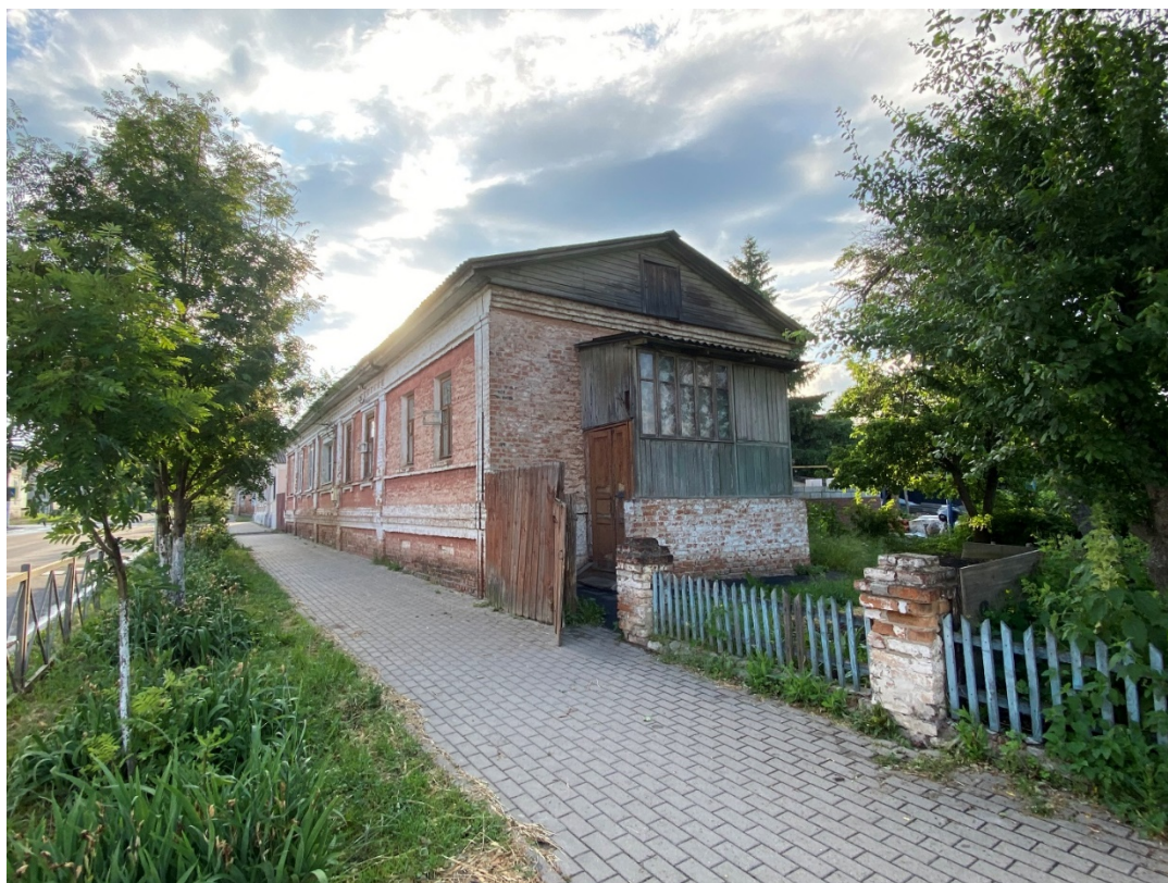
Фотография № 5. Вид с юго-востока на Объект.
