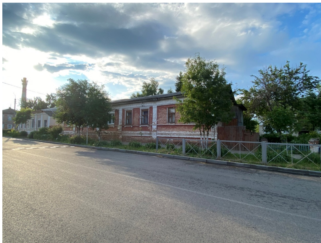
Фотография № 6. Вид с юго-востока на Объект.
