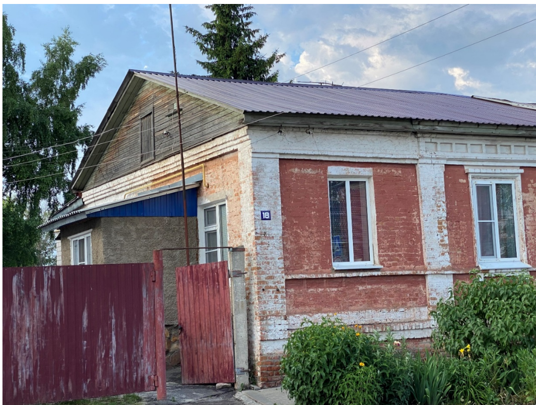
Фотография № 9. Вид с юго-запада на Объект.
