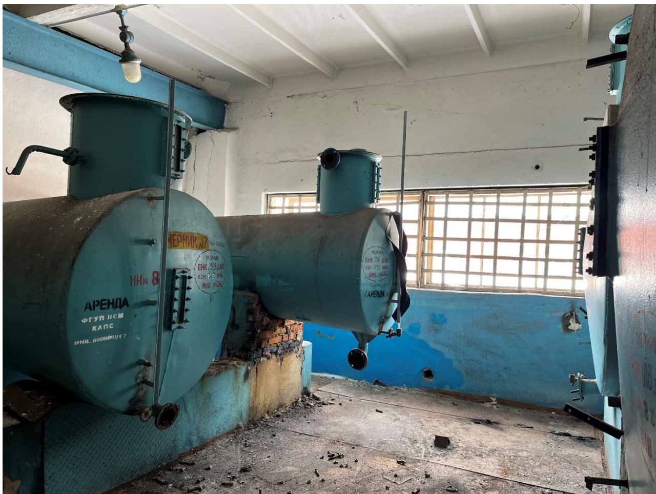
Т.ф. 13. Вид внутреннего помещения Объекта
