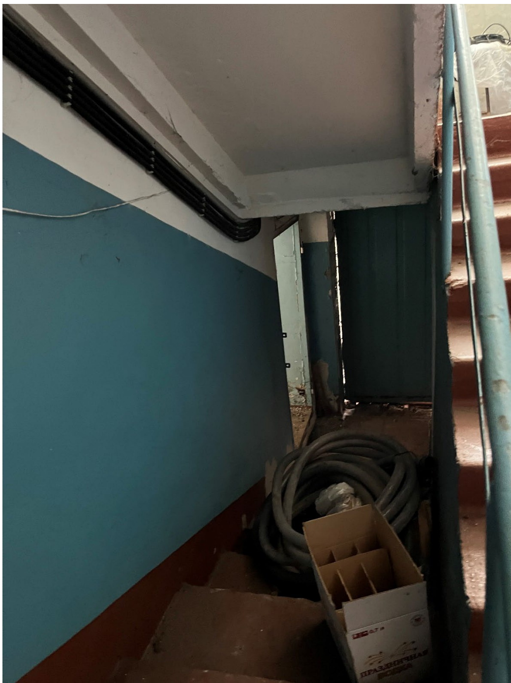
Т.ф. 14. Вид внутреннего помещения Объекта
