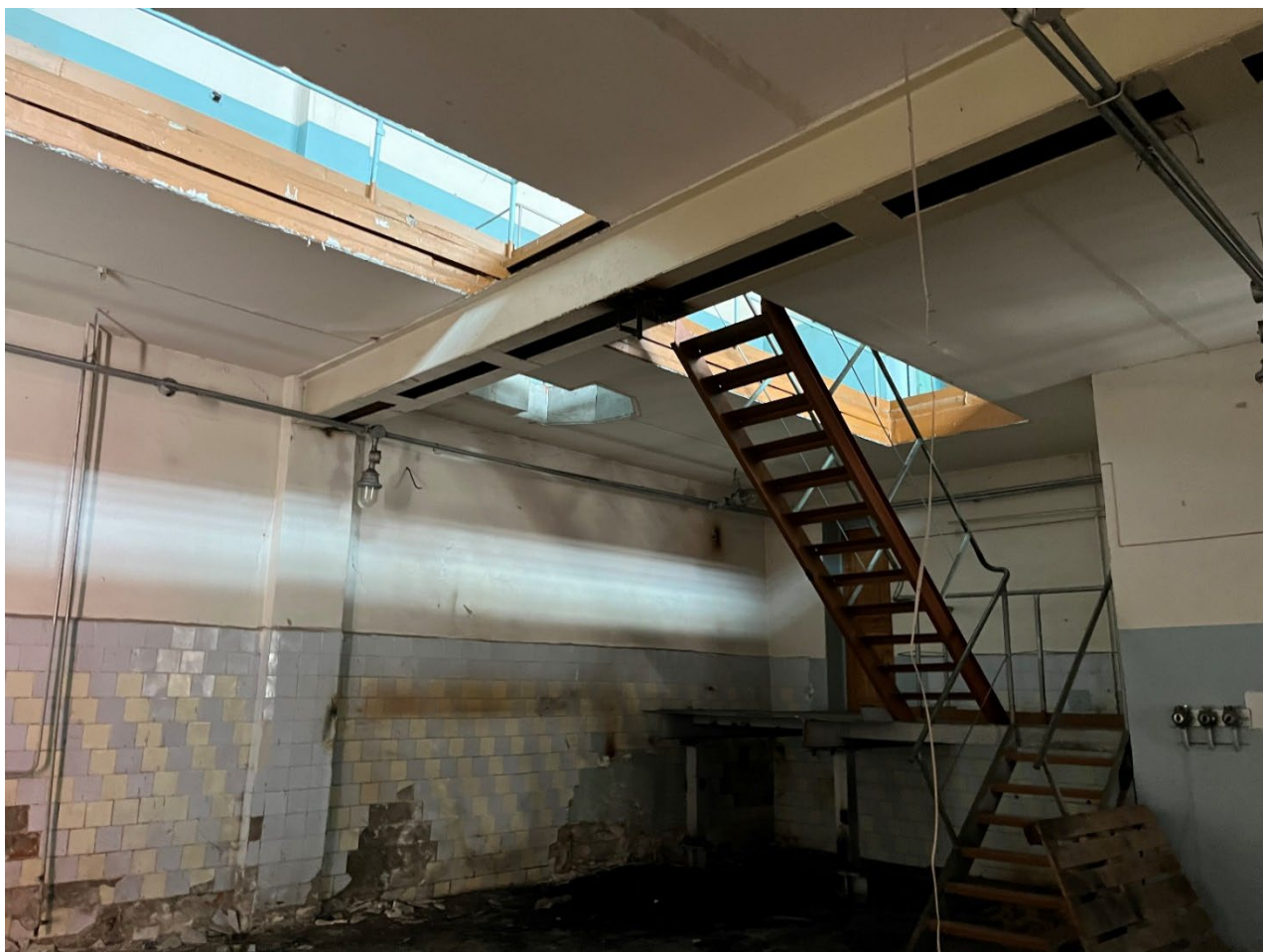
Т.ф. 10. Вид внутреннего помещения Объекта
