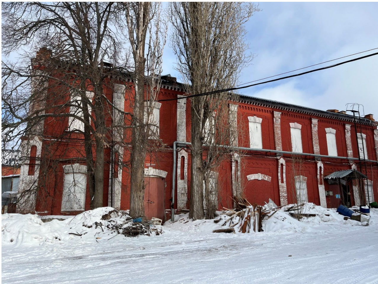
Т.ф. 4. Общий вид на Объект
