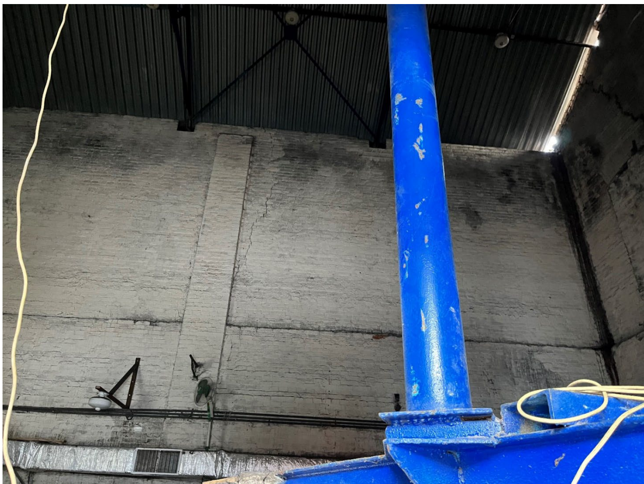
Т.ф. 8. Вид внутреннего помещения Объекта
