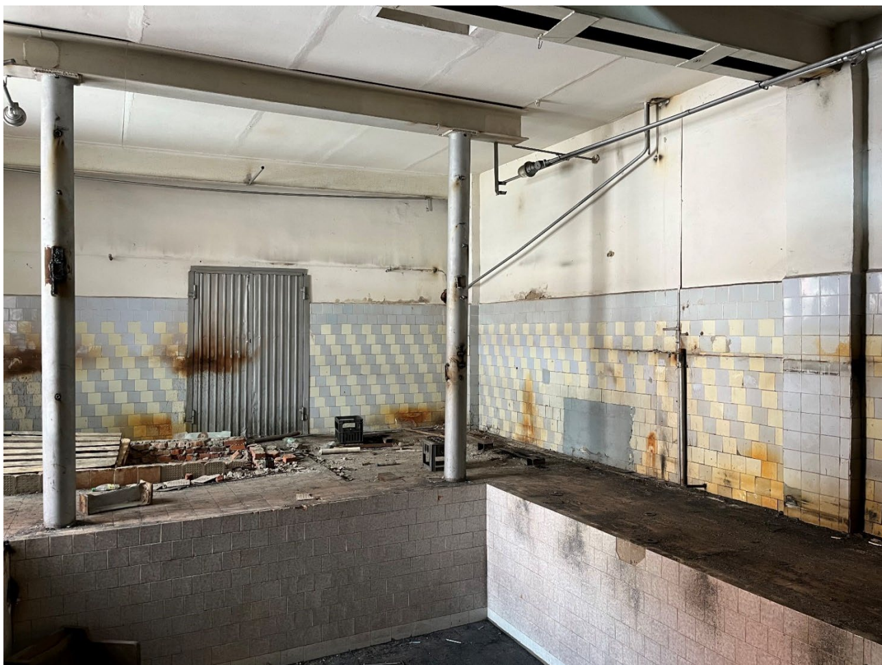
Т.ф. 11. Вид внутреннего помещения Объекта
