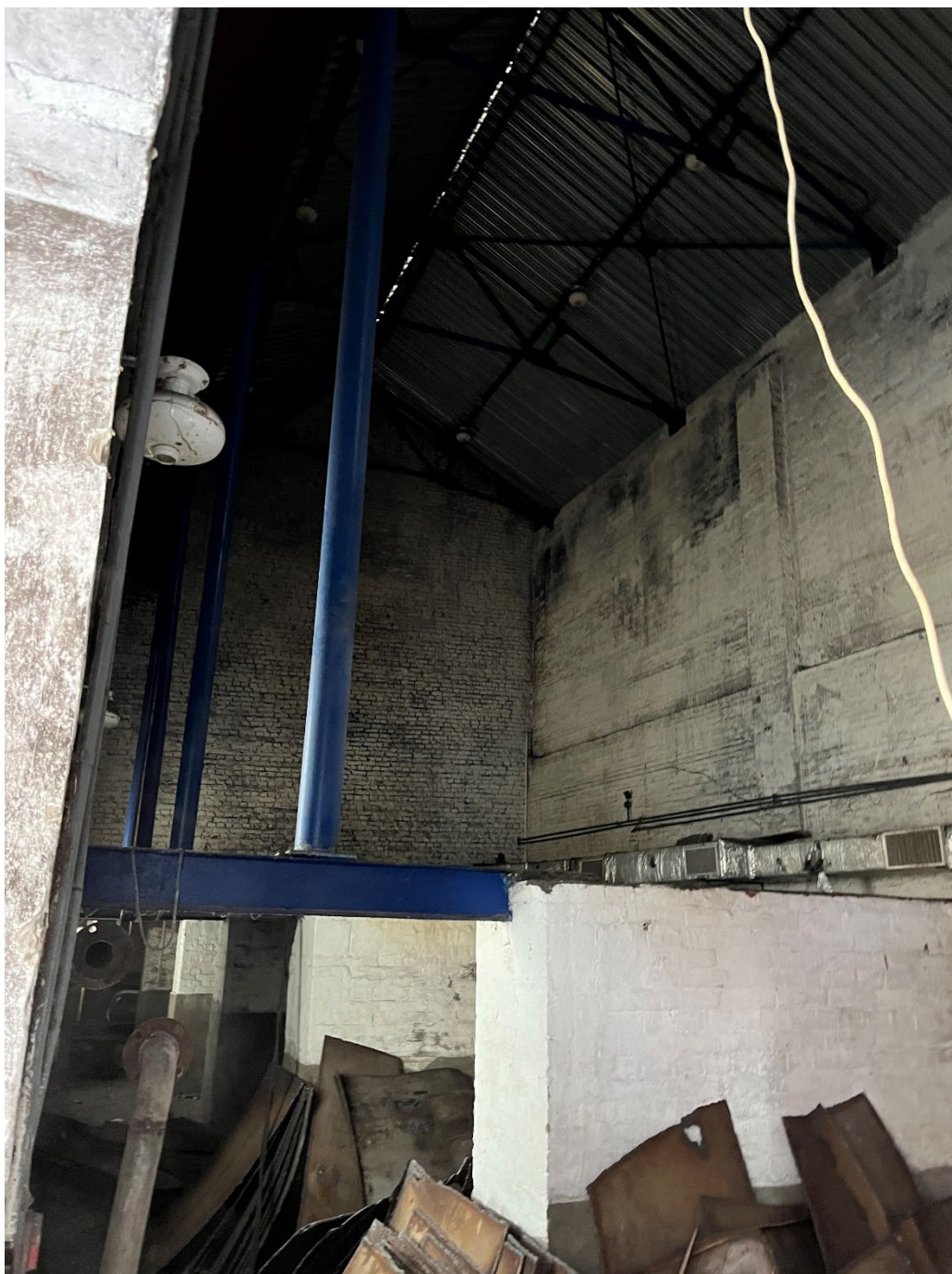
Т.ф. 9. Вид внутреннего помещения Объекта
