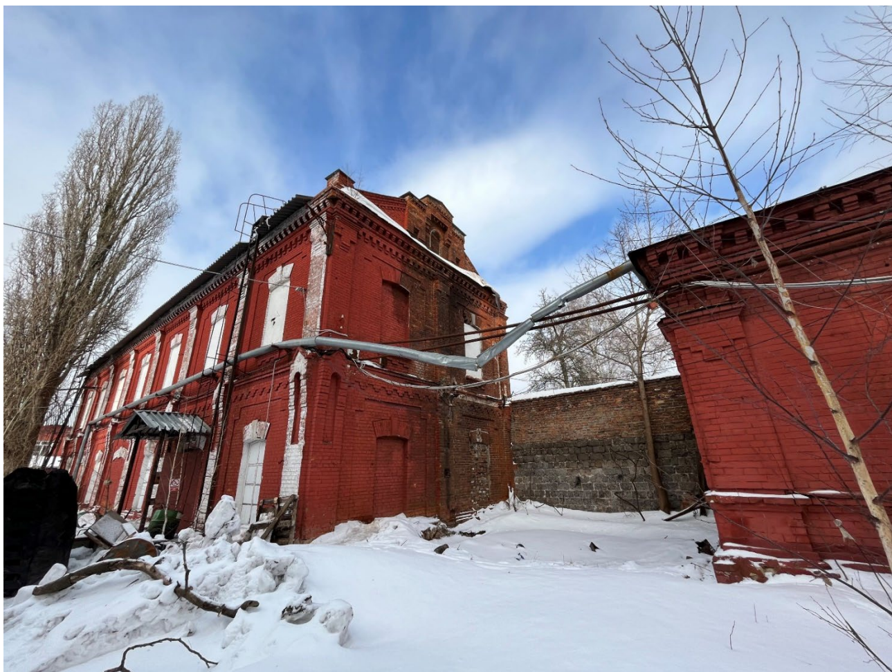
Т.ф. 6. Общий вид на Объект
