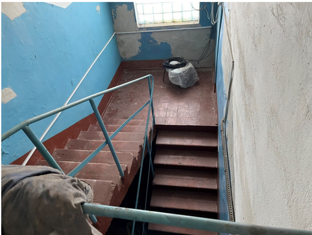
Т.ф. 12. Вид внутреннего помещения Объекта
