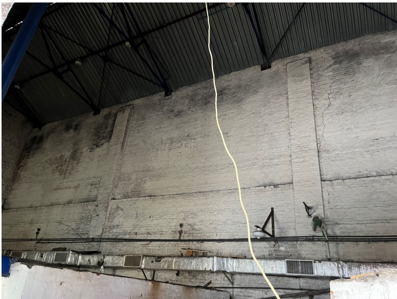
Т.ф. 7. Вид внутреннего помещения Объекта
