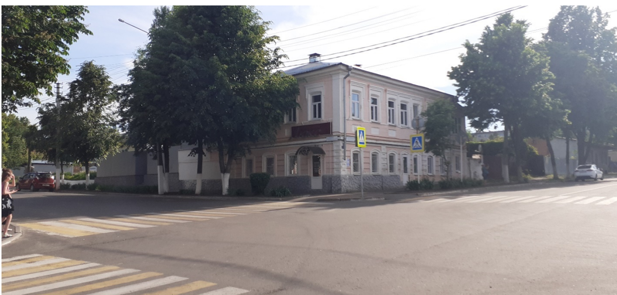
Фотография № 2. Вид с северо-востока на Объект.
