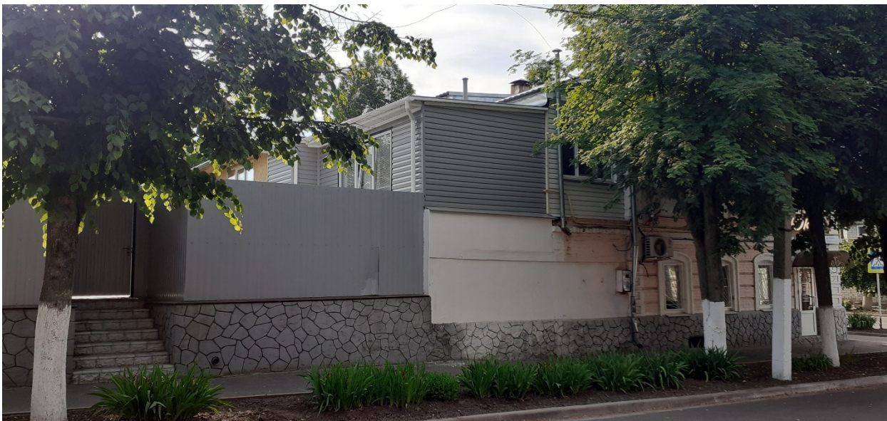
Фотография № 7 Вид с юго-востока на Объект.
