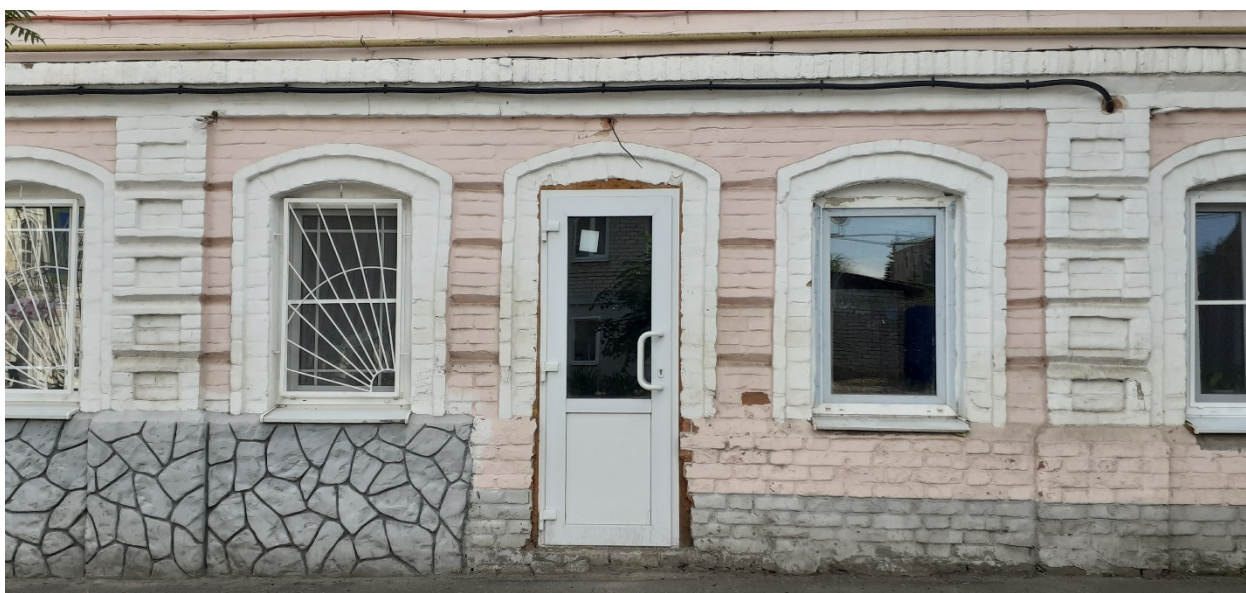
Фотография № 12. Вид с севера на Объект. Северный фасад. Фрагмент.
