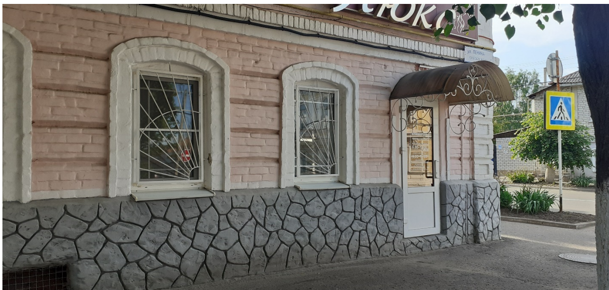
Фотография № 11. Вид с юго-востока на Объект. Восточный фасад. Фрагмент
