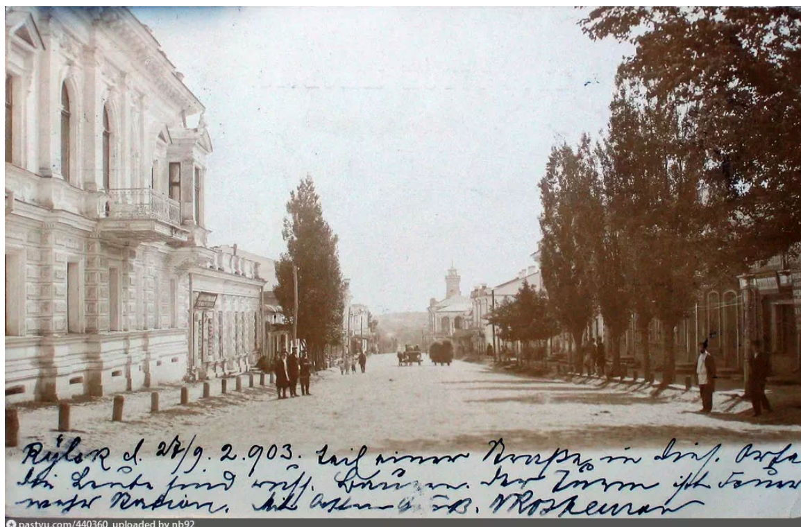
19. Восточная часть улицы, на которой находится здание Объекта. Рыльск. Архангельская улица (современная улица Дзержинского). Период создания: рубеж XIX-XX вв.
