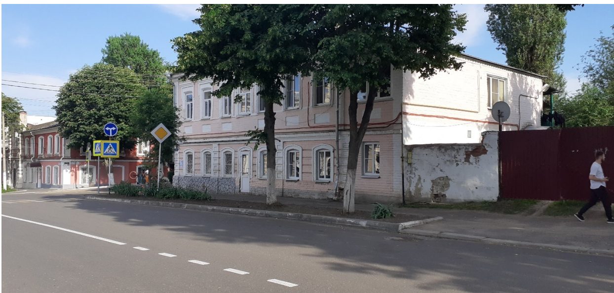
Фотография № 9. Вид с северо-запада на Объект.
