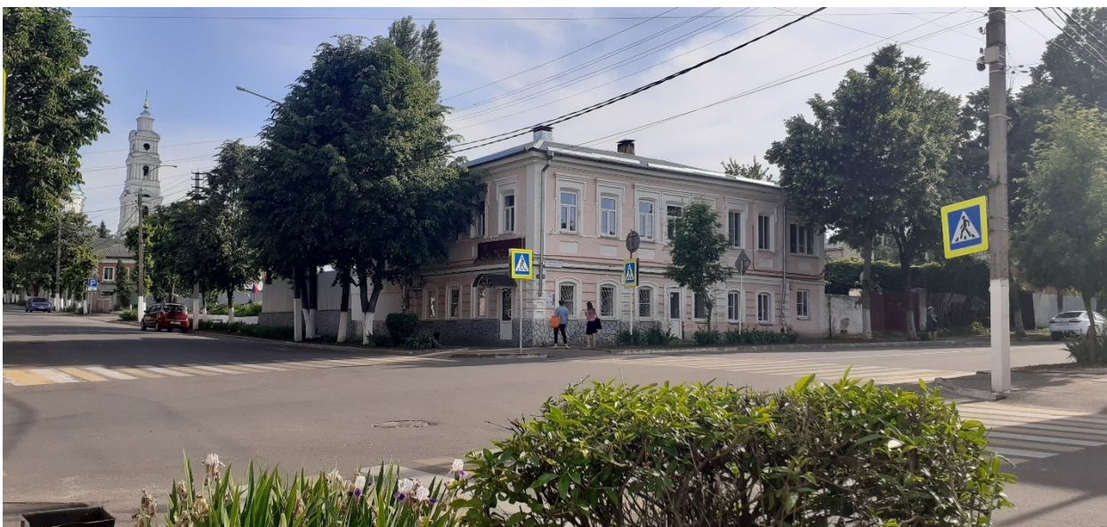
Фотография № 3. Вид с северо-востока на Объект.
