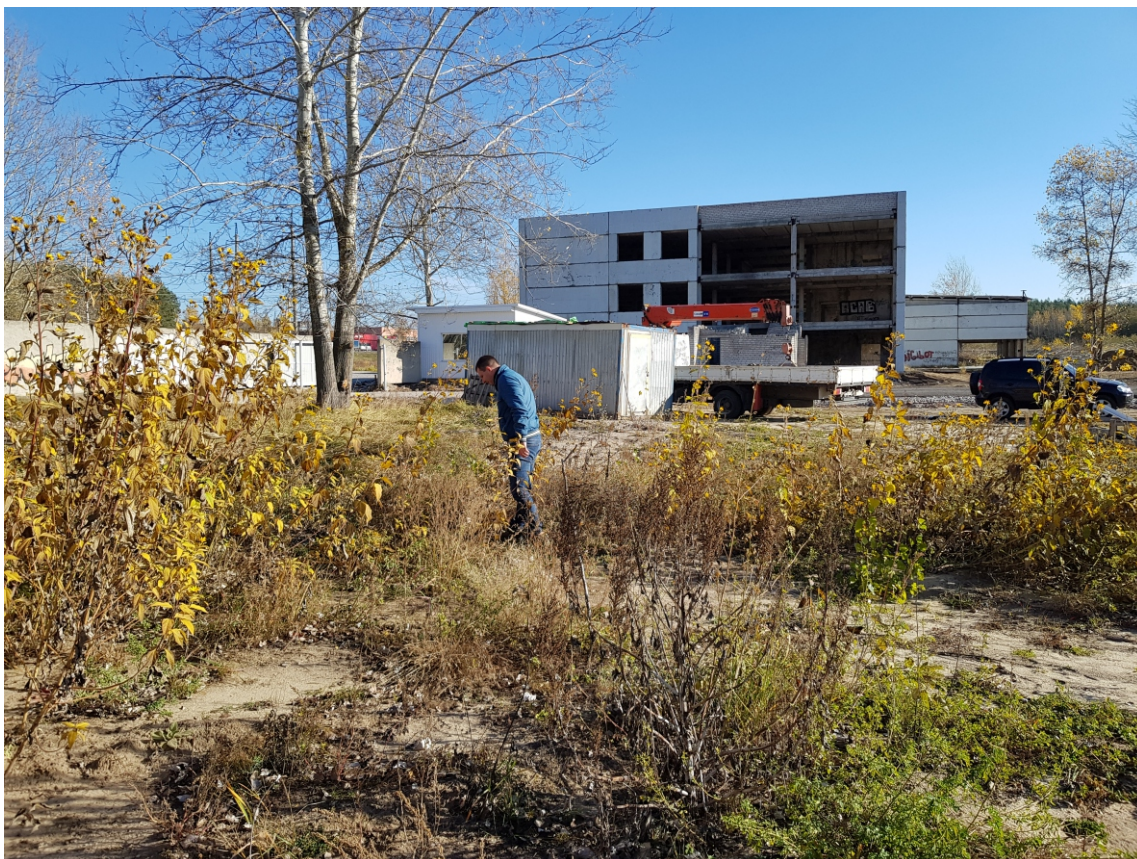
Илл. 38. Пеший осмотр местности в западной части участка обследования. Вид с запада.
