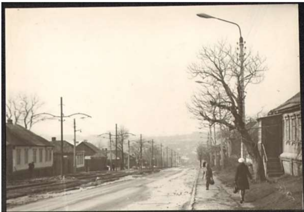
15. Курск. Улица Красный Октябрь. Вид в западном направлении. Фотограф В.Н. Зубец. Период создания: середина 1970-х гг. Местонахождение: Областное бюджетное учреждение культуры «Курский областной краеведческий музей» Источник: https://goskatalog.ru/portal/#/collections?id=11873429
