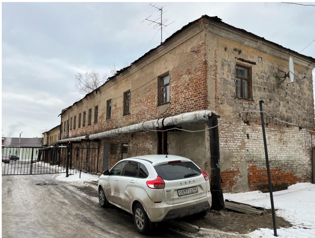
Фотография № 17. Вид с запада на Флигель.
