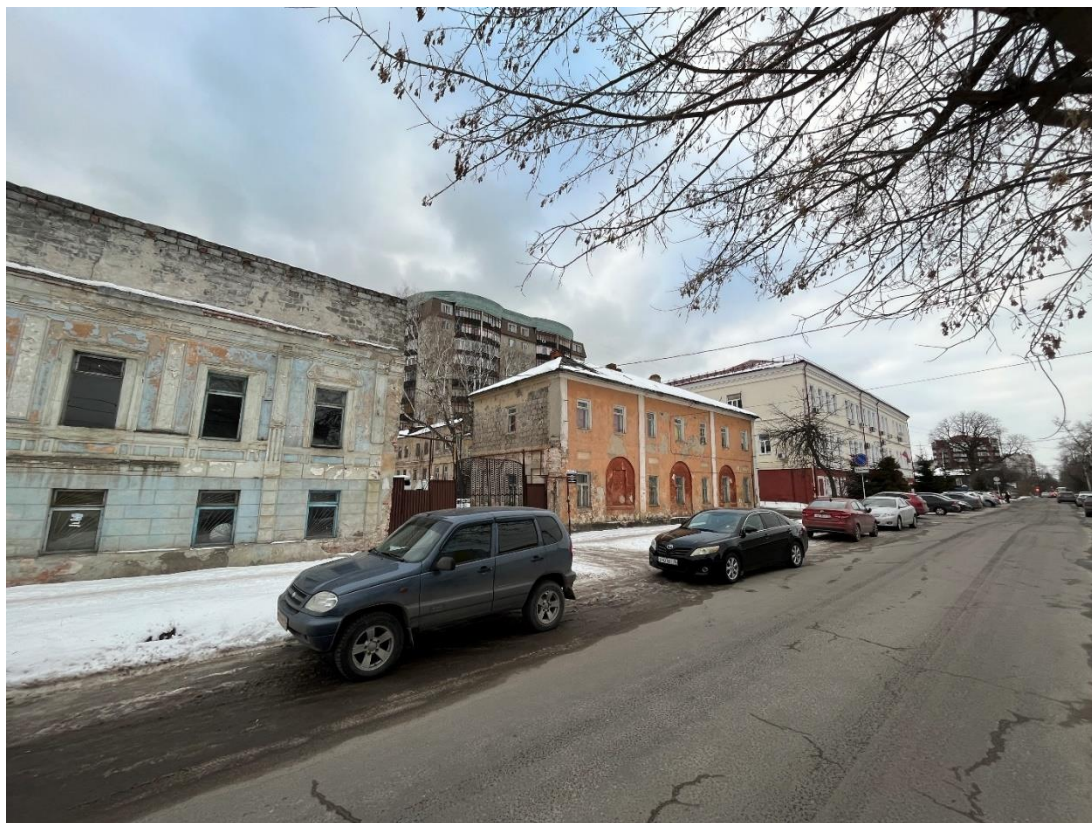
Фотография № 33. Вид с юго-востока на Ансамбль.
