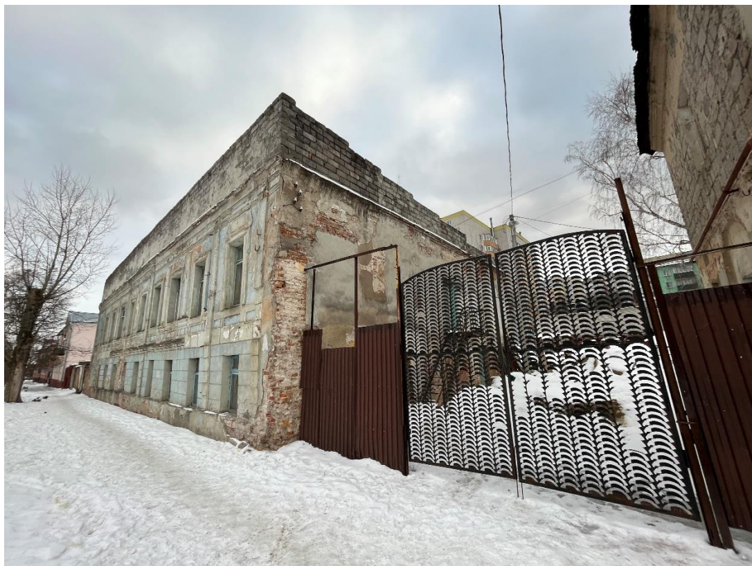
Фотография № 25. Вид с севера на Главный усадебный дом и Ворота.
