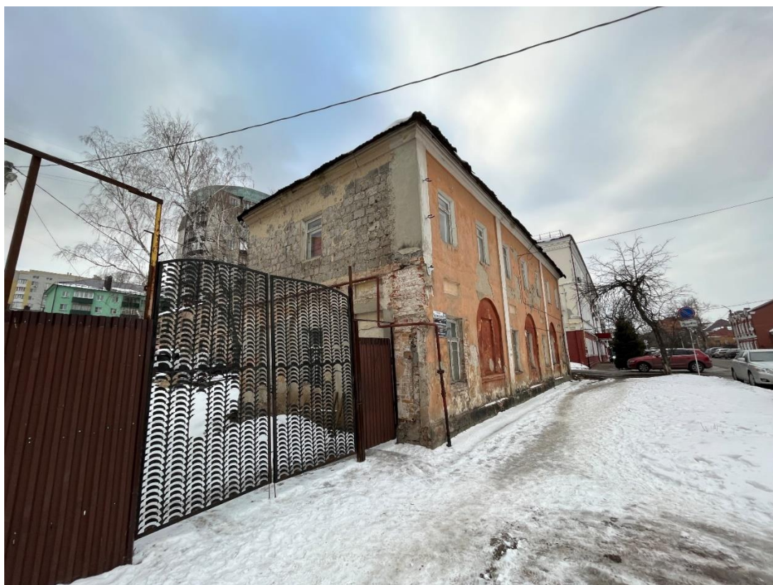
Фотография № 31. Вид с юго-востока на Флигель и Ворота.
