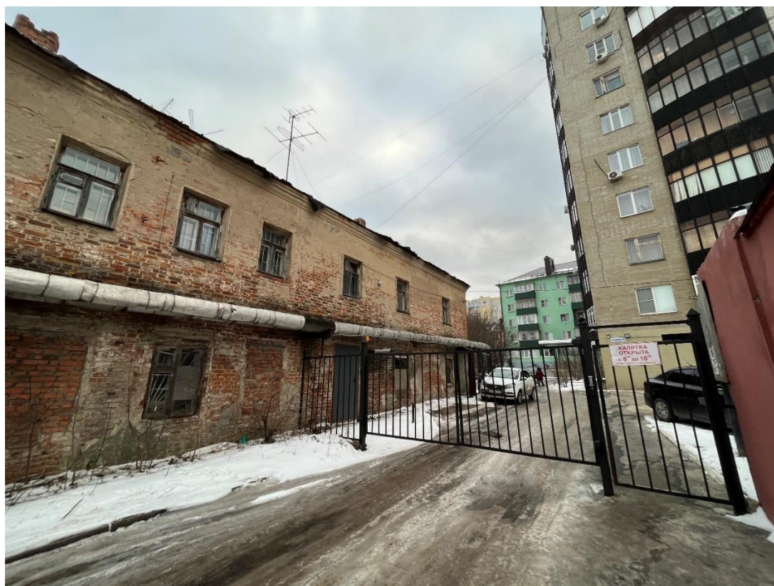
Фотография № 8. Вид с северо-востока на Флигель.
