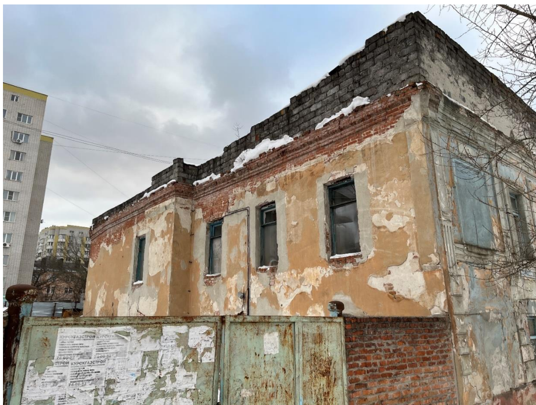
Фотография № 37. Вид с юго-востока на Главный усадебный дом.
