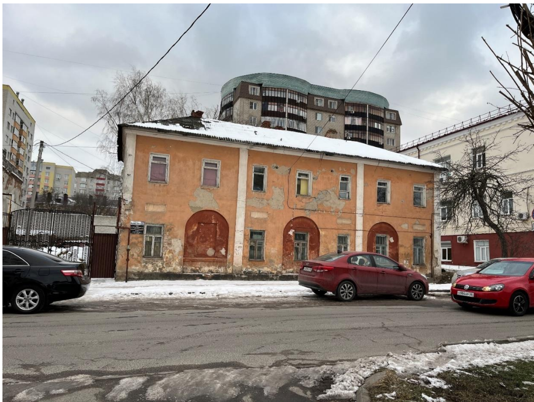
Фотография № 23. Вид с северо-востока на Флигель.
