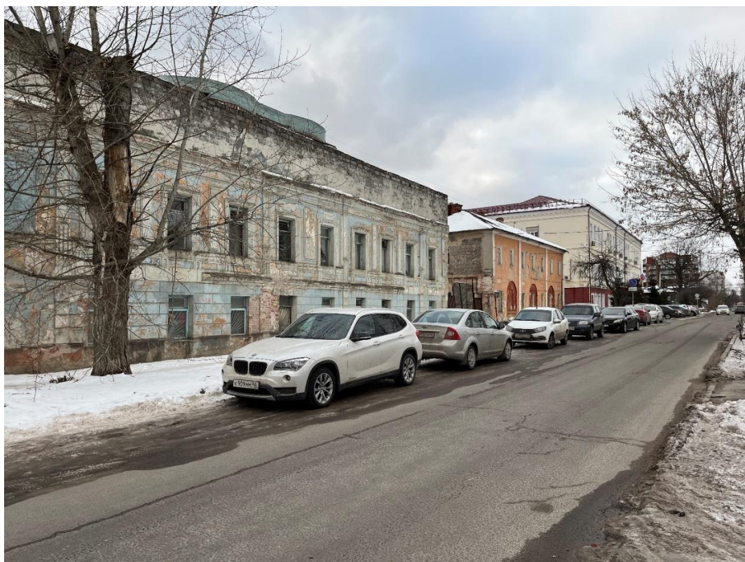
Фотография № 35. Вид с юго-востока на Ансамбль.
