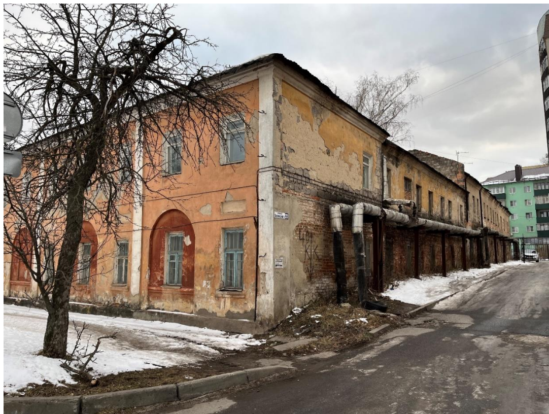
Фотография № 5. Вид с северо-востока на Флигель.
