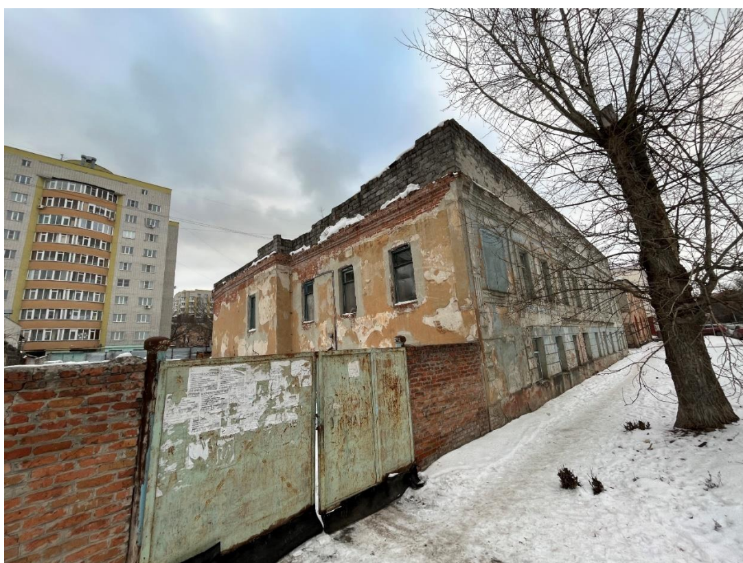
Фотография № 38. Вид с юго-востока на Главный усадебный дом.
