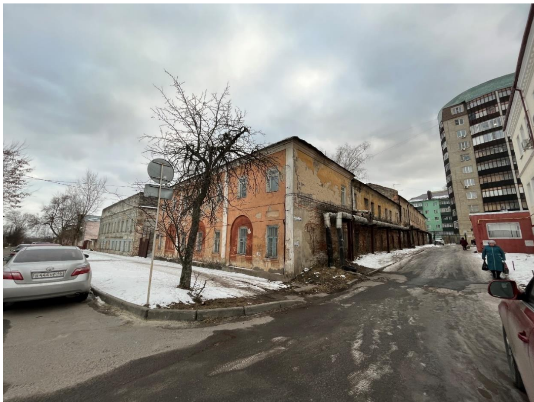
Фотография № 3. Вид с северо-востока на Ансамбль.
