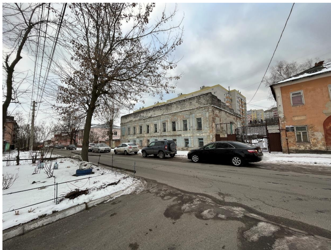
Фотография № 20. Вид с севера на Главный усадебный дом и Ворота.
