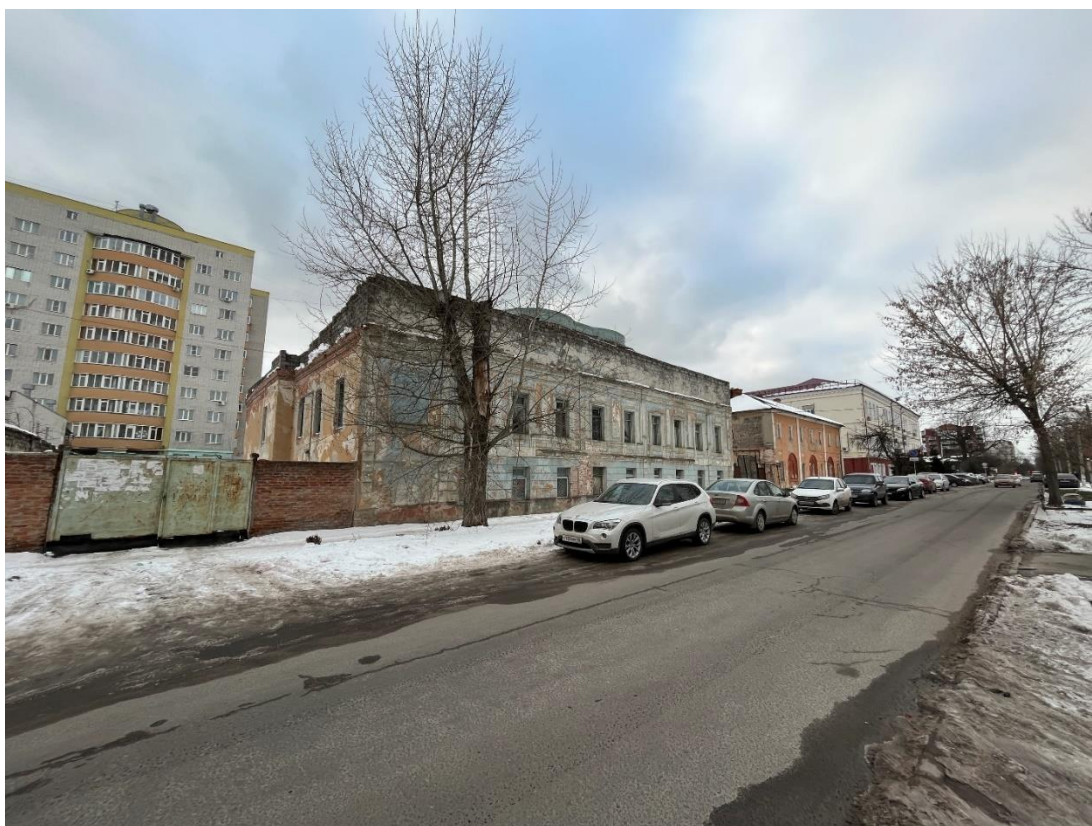
Фотография № 40. Вид с юго-востока на Ансамбль.
