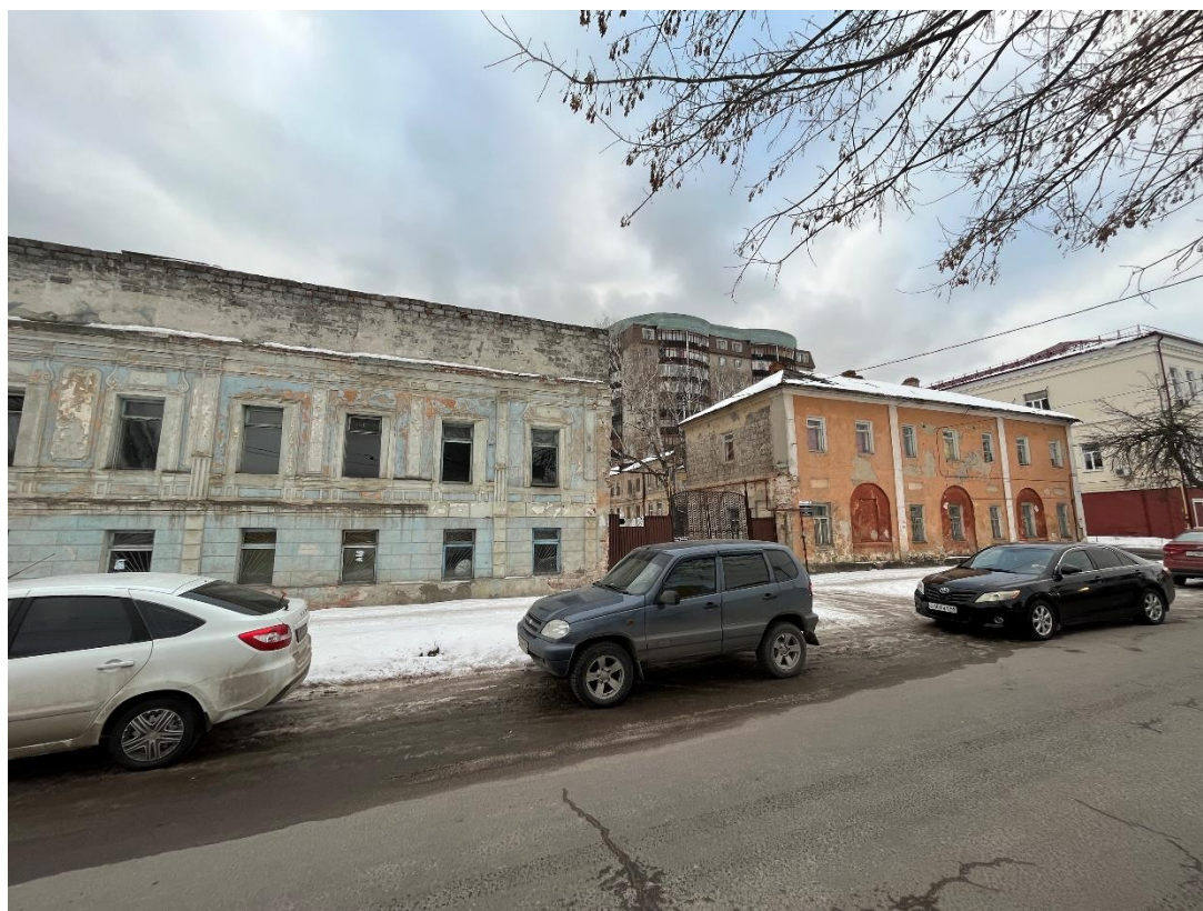
Фотография № 34. Вид с юго-востока на Ансамбль.
