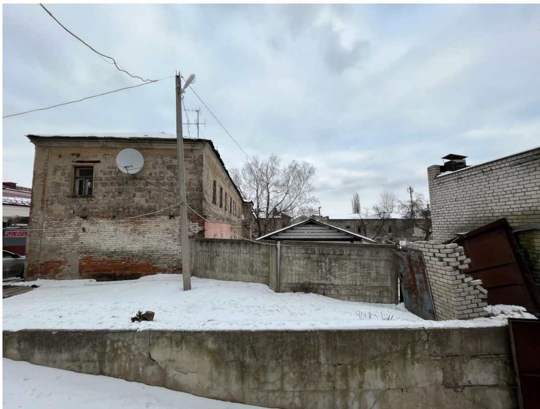
Фотография № 11. Вид с юго-запада на Главный усадебный дом и Флигель.
