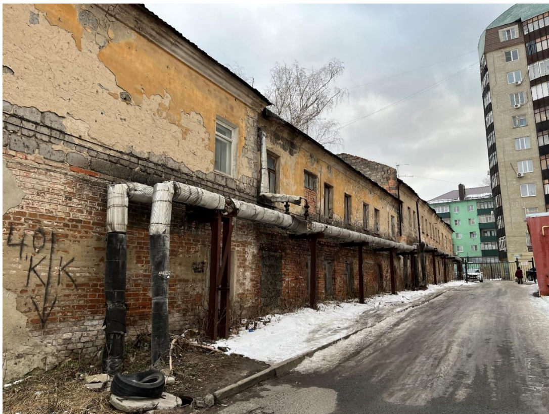
Фотография № 7. Вид с северо-востока на Флигель.
