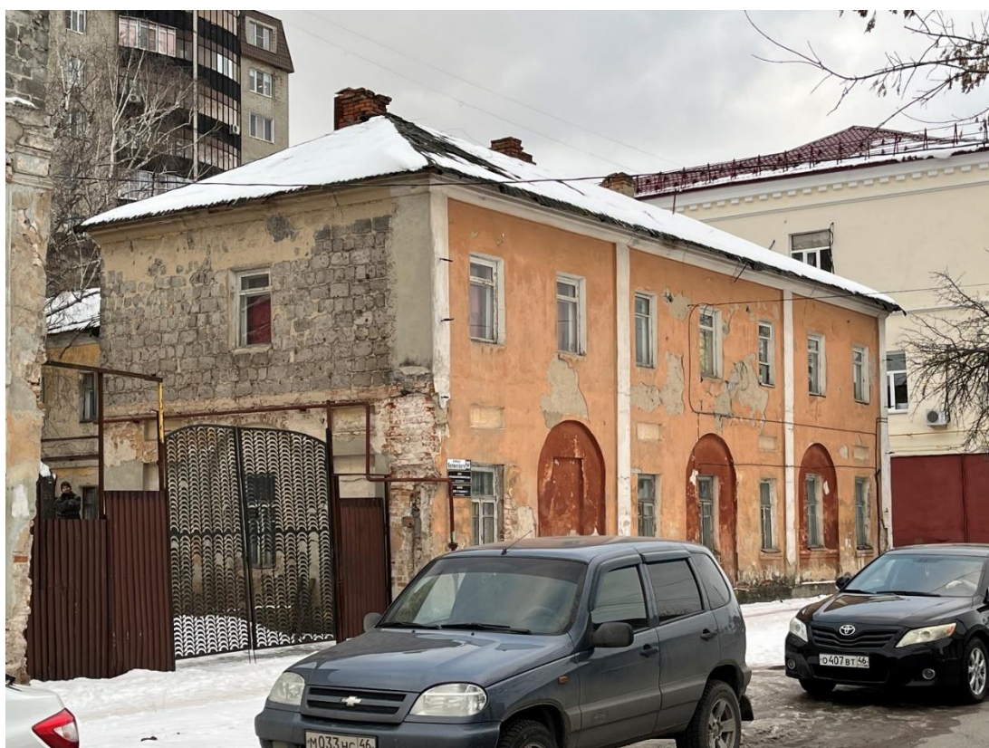
Фотография № 30. Вид с юго-востока на Флигель и Ворота.
