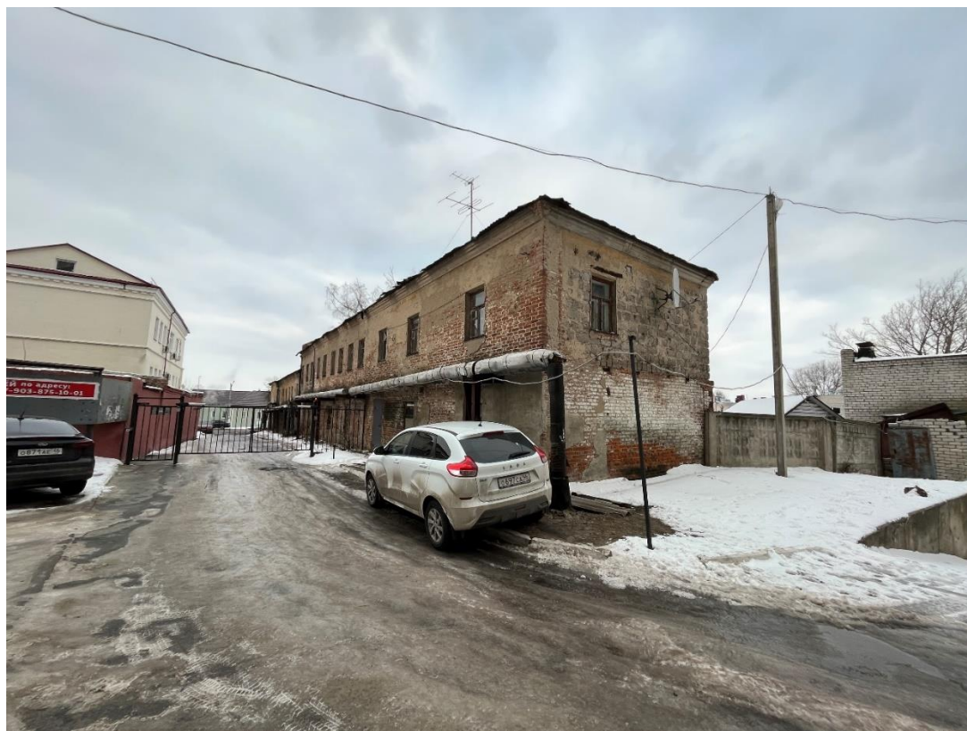
Фотография № 16. Вид с запада на Флигель.
